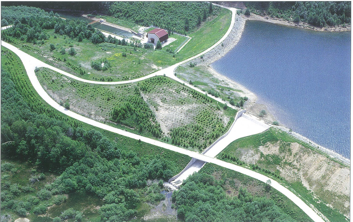
STROJARNICA, BRANA I PRELJEVNA GRAĐEVINA
