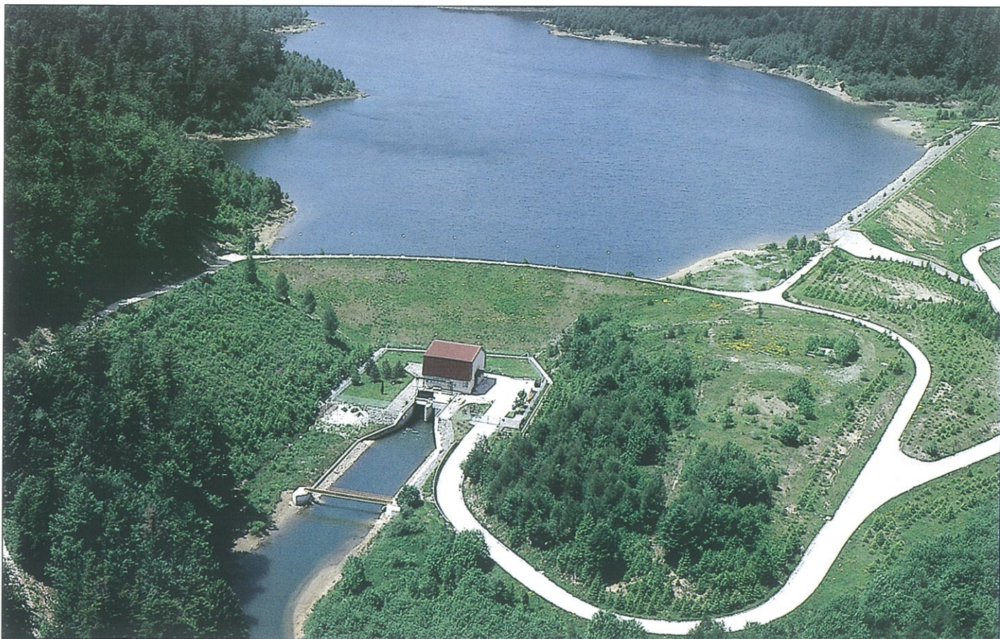
POGLED NA BRANU, STROJARNICU I AKUMULACIJSKO JEZERO
