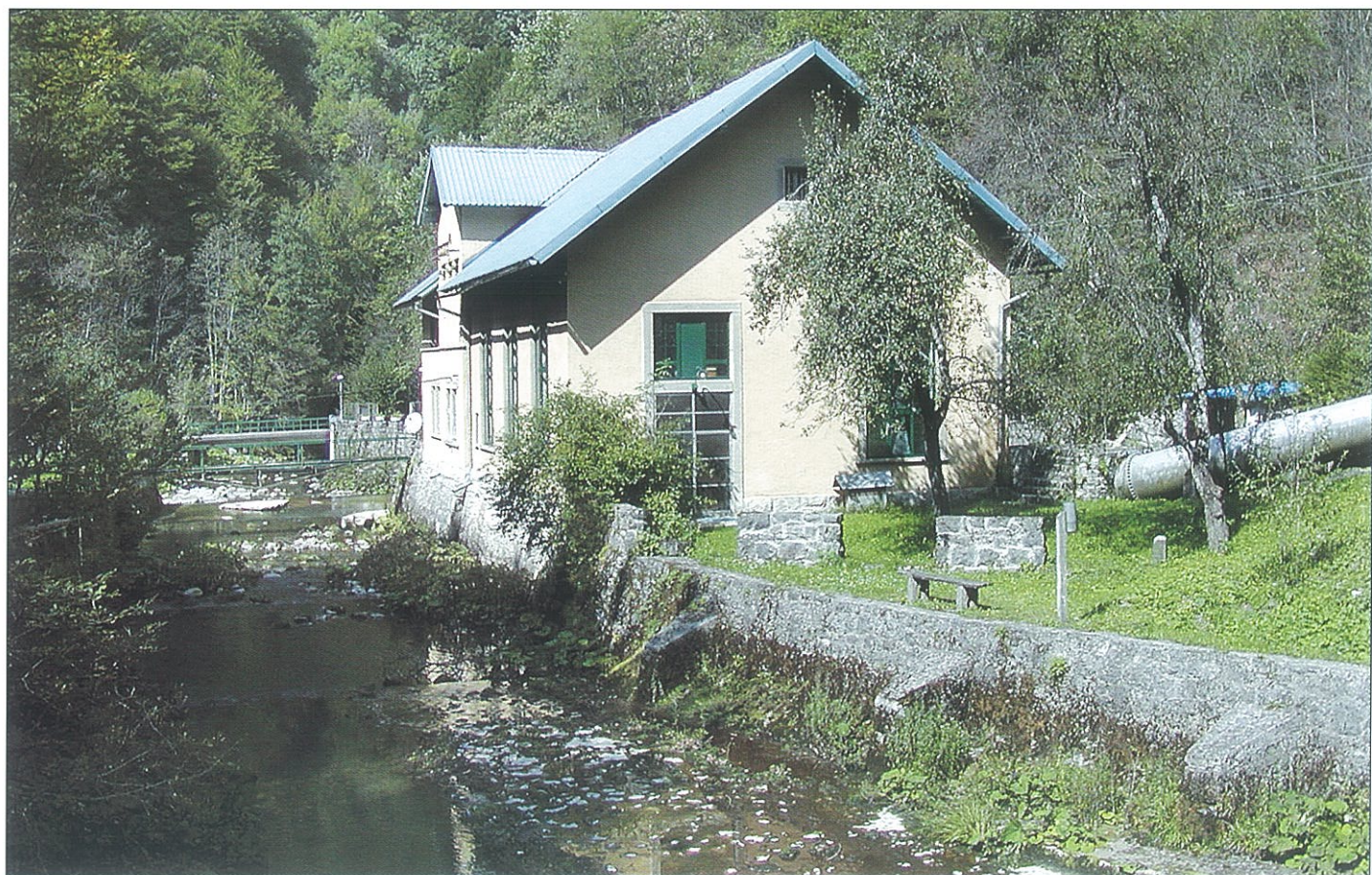
STROJARNICA, ČELIČNI TLAČNI CJEVOVOD I POTOK CURAK
