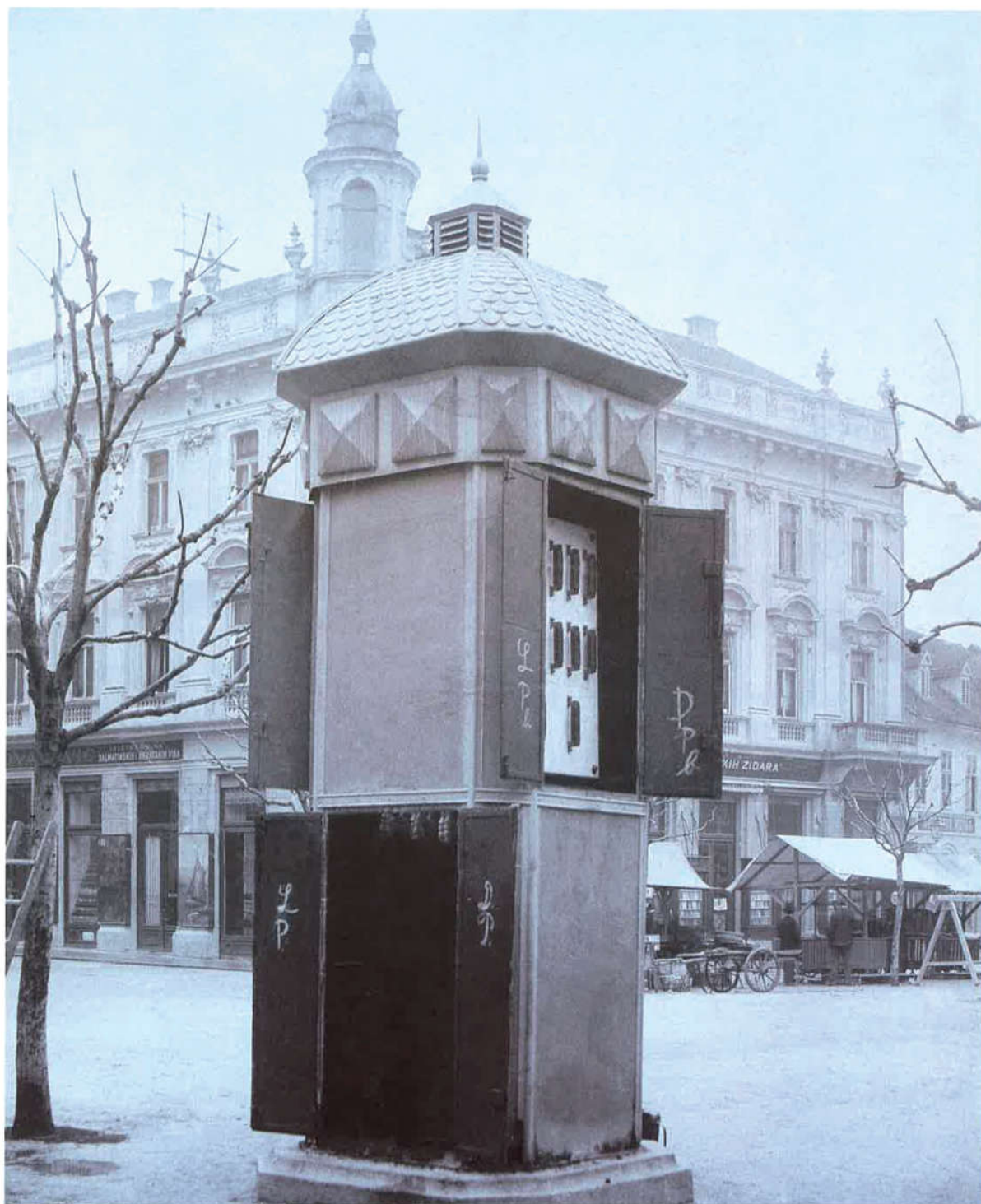
△ Jedna od prvih transformatorskih stanica 5 kV u Zagrebu
