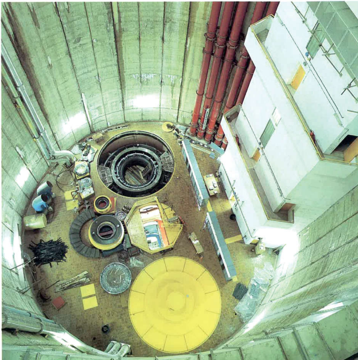
Δ Crpna hidroelektrana Obrovac
