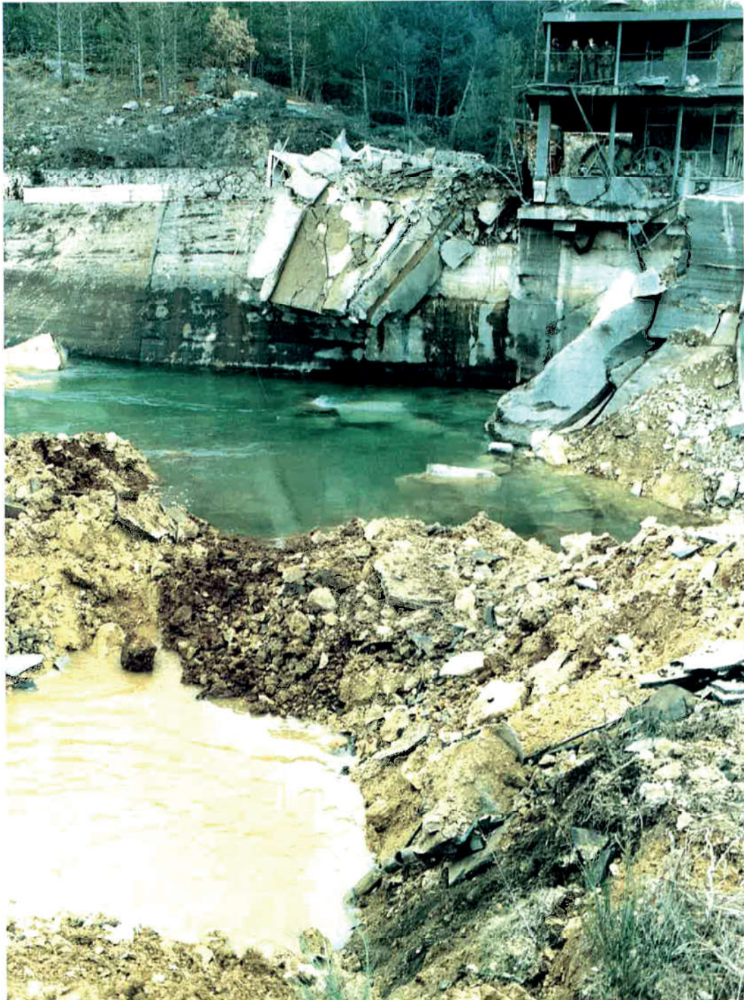
△ Brana hidroelektrane Peruća dan nakon miniranja, 29. siječnja 1993.
