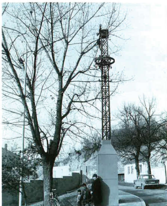
Δ Ulična TS 3/0,11 kV u Vukovaru, 1909.
