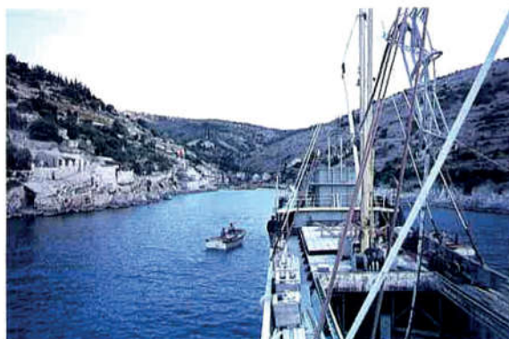
Δ Polaganje podmorskog kabla 110 kV
