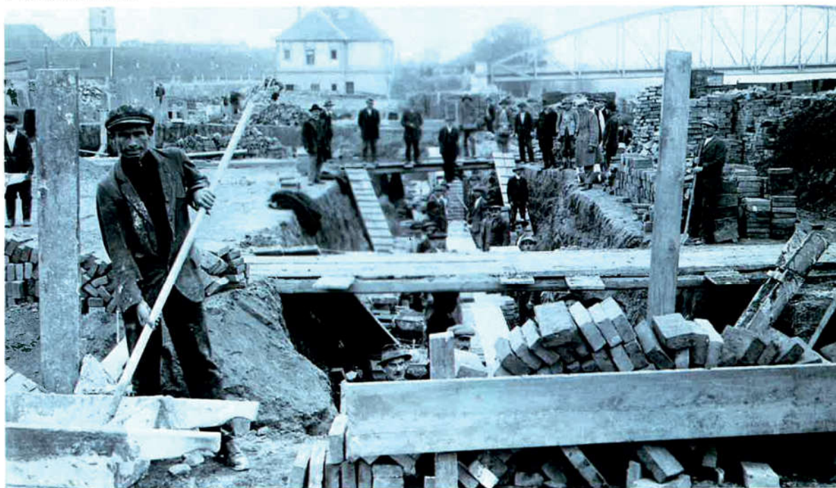
▽ Temelji Munjare Osijek
