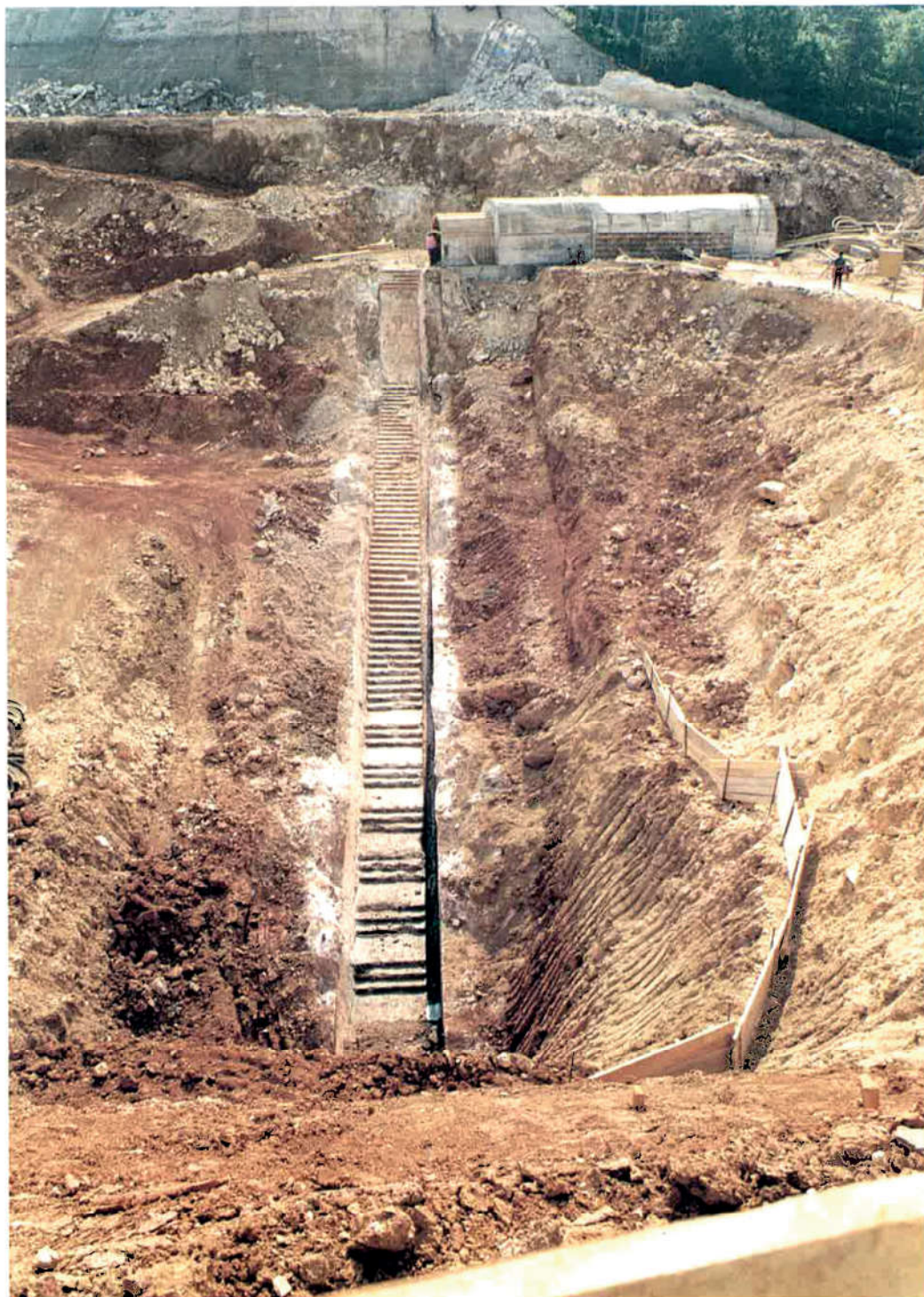
△ Početni radovi na sanaciji brane hidroelektrane Peruća
