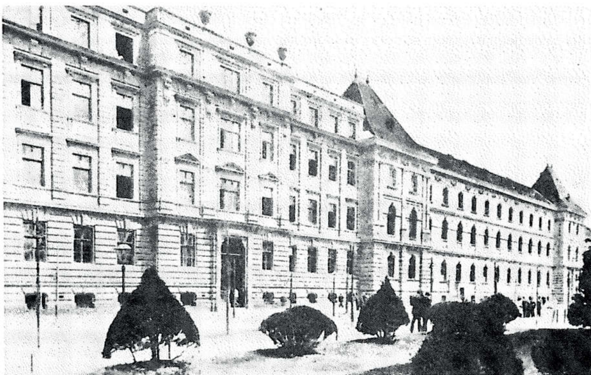
Sl. 5. Zgrada Visoke tehničke škole (Tehničkog fakulteta) na Wilsonovu trgu (Rooseveltov trg). Laboratorij za električna mjerenja nalazio se u desnom dijelu prizemlja.
