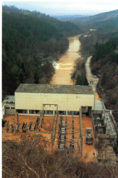
Pogled na strojarnicu i rasklopno postrojenje HE Peruća nakon miniranja brane. Voda je protjecala kroz razrušenu injekcijsku galeriju i drenažni odvod na rasklopno postrojenje iznoseći komade glinene jezgre promjera i do 0,50 m
