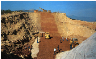
Nasipavanje lijevog kraja brane, kota 338,50 m n.m.
