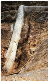
Novoizgrađena galerija s pristupnim tunelom na lijevom kraju brane
