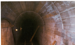
Obnovljeni dio potpuno razrušene galerije betonskom oblogom debljine 80 cm
