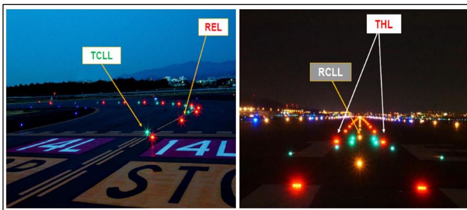
Sl.: 17. Ulazna svjetla na pistu – REL, na zračnoj luci Osaka i svjetla čekanja za polijetanje - THL na zračnoj luci Fukuoka
