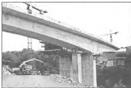
Slika 11. Most Kamačnik tijekom izvedbe
