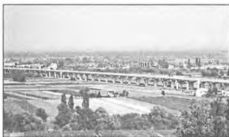
Slika 12. Vijadukt Drežnik kraj Karlovca
