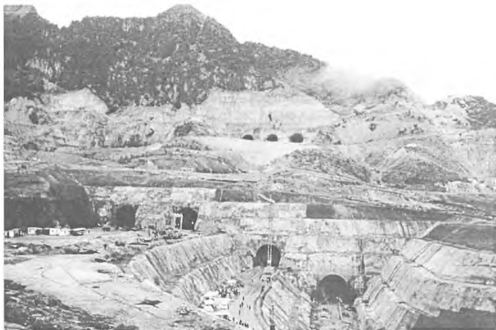
Slika 2. Bekhme dam project u Iraku. Ukupna dužina svih tunela iznosi oko 15 km. Promjeri tunela 14,16 i 18 m. Predusjeci tunela oko 2,3 milijuna m 3 .
