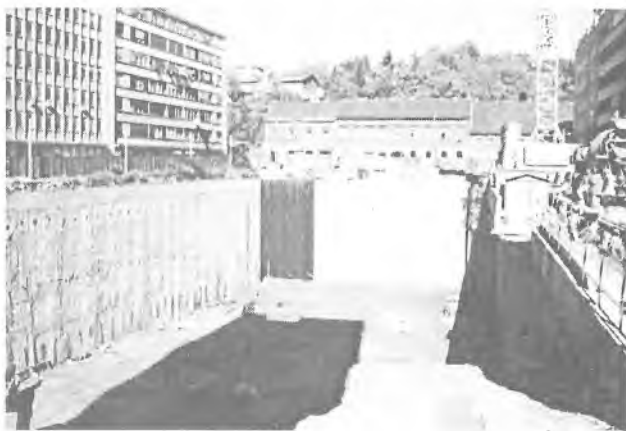
Jama na Iblerovom trgu, dubine 18.5 m, sa zgradama i Iblerovim neboderom u blizini; na slici se vide završeci prednapetih sidara u tri reda
