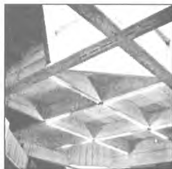
Slika 21. Konstrukcija krovšta XII paviljona Zagrebačkog velesajma
