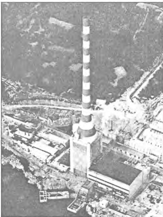
Slika 30. Kotlovnica i dimnjak termoelektrane Rijeka I
