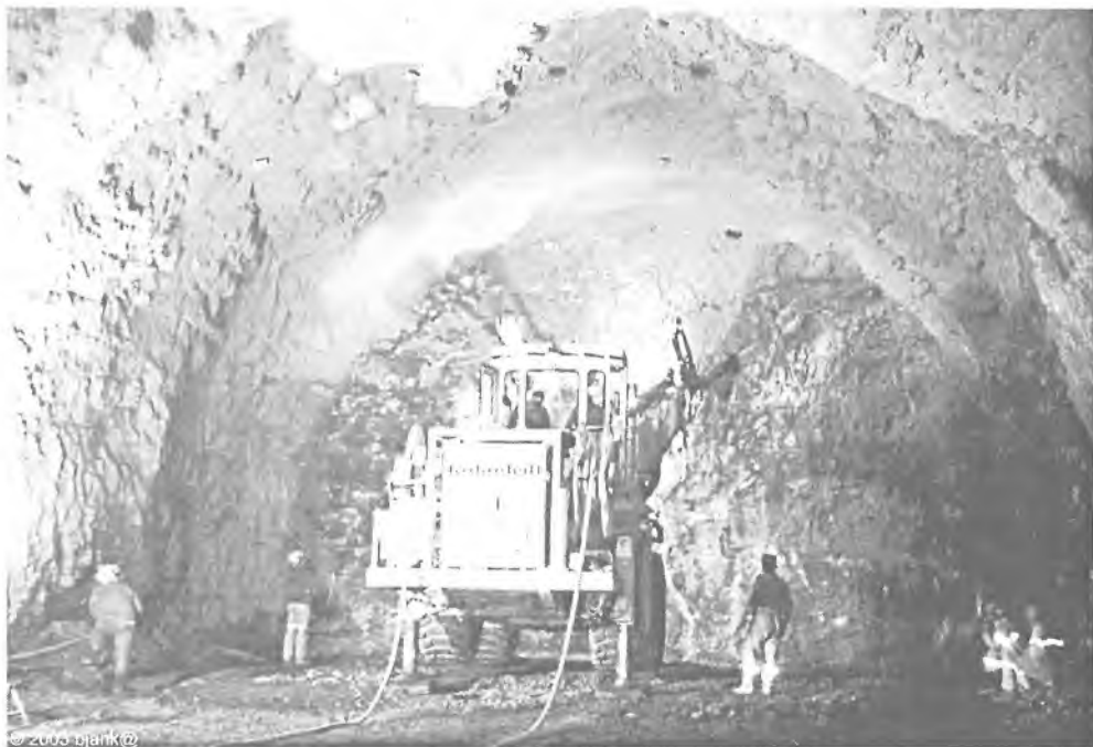
Slika 2. Na probijanju tunela "Veliki Gložac" prvi je put u Hrvatskoj primijenjeno računalno vođeno bušenje
