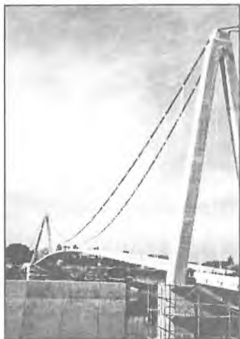
Slika 14. Most preko Save u Martinskoj Vesi
