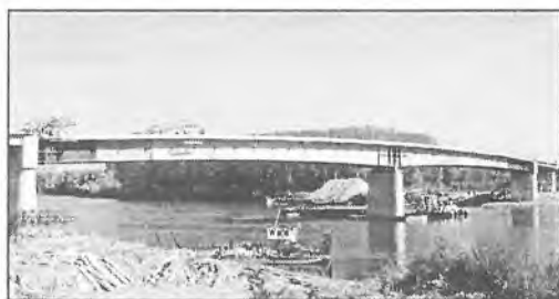
Slika 13. Most preko Drave kod Belišća tijekom izvedbe
