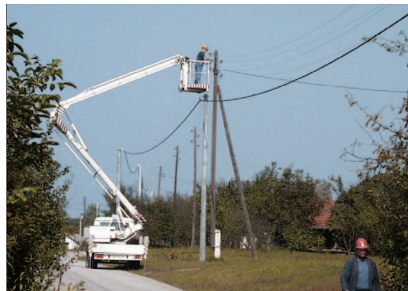
Radovi na niskonaponskoj mreži uz korištenje mehanizacije
