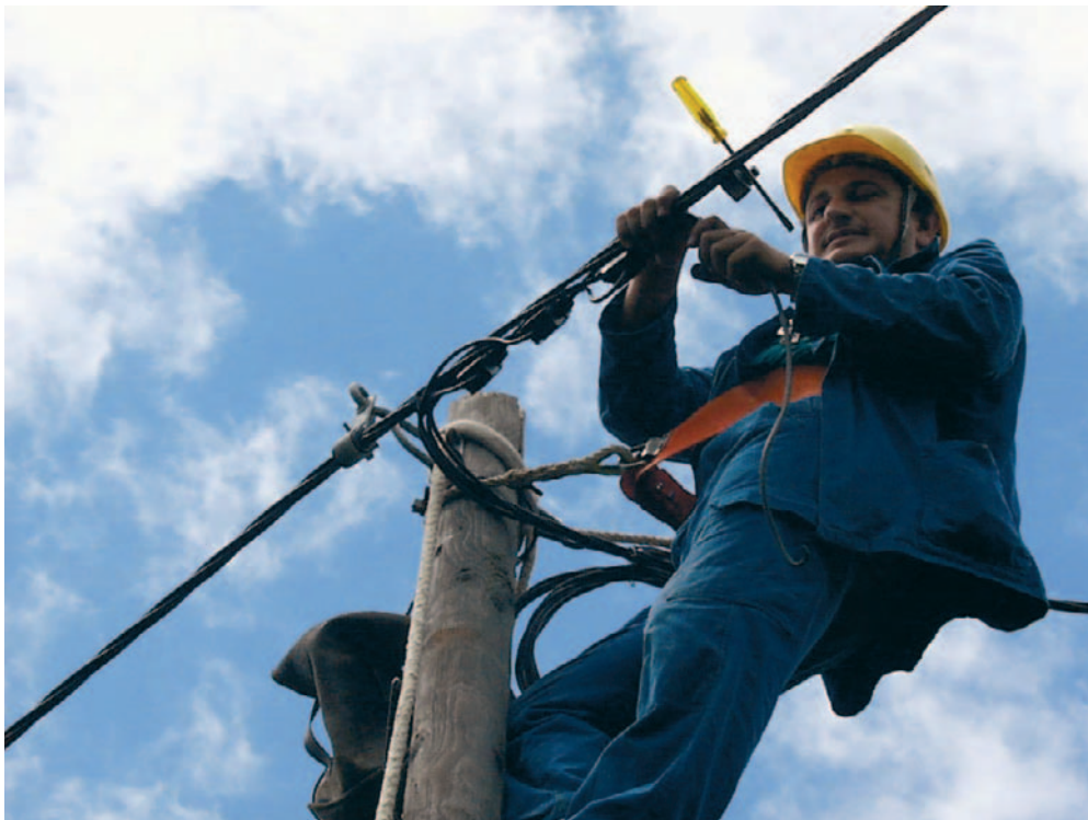
Čakovečki elektraš radi na niskonaponskoj mreži
