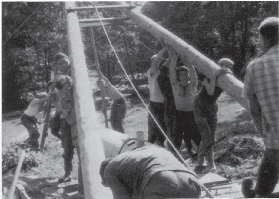
Stupovi dalekovoda podizali su se ručno
