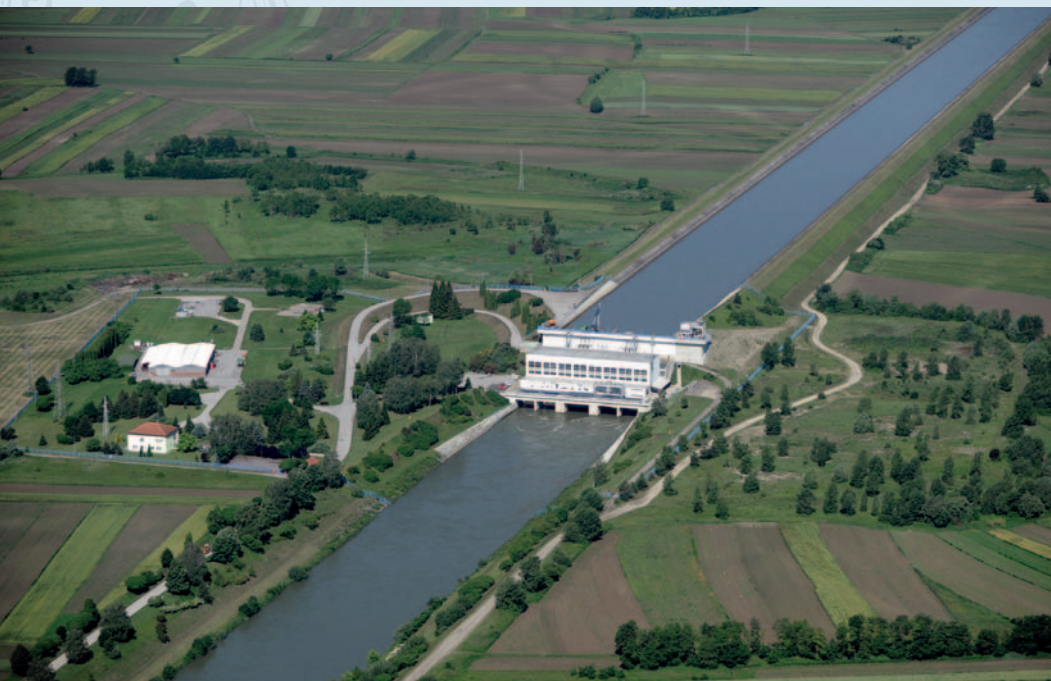
Strojarnica i derivacijski kanal Hidroelektrane Varaždin
