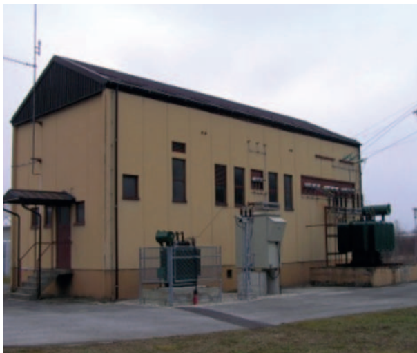
Transformatorska stanica Novi Marof 2 rekonstruirana je 2009. godine
