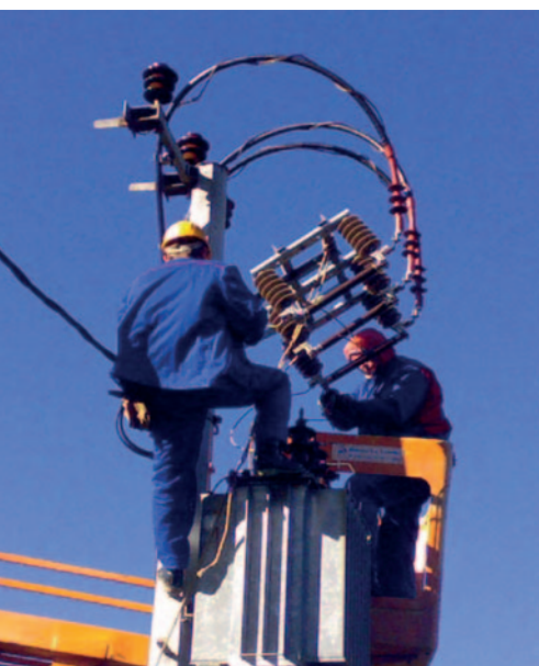
Zamjena opreme postojećih stupnih transformatorskih stanica
