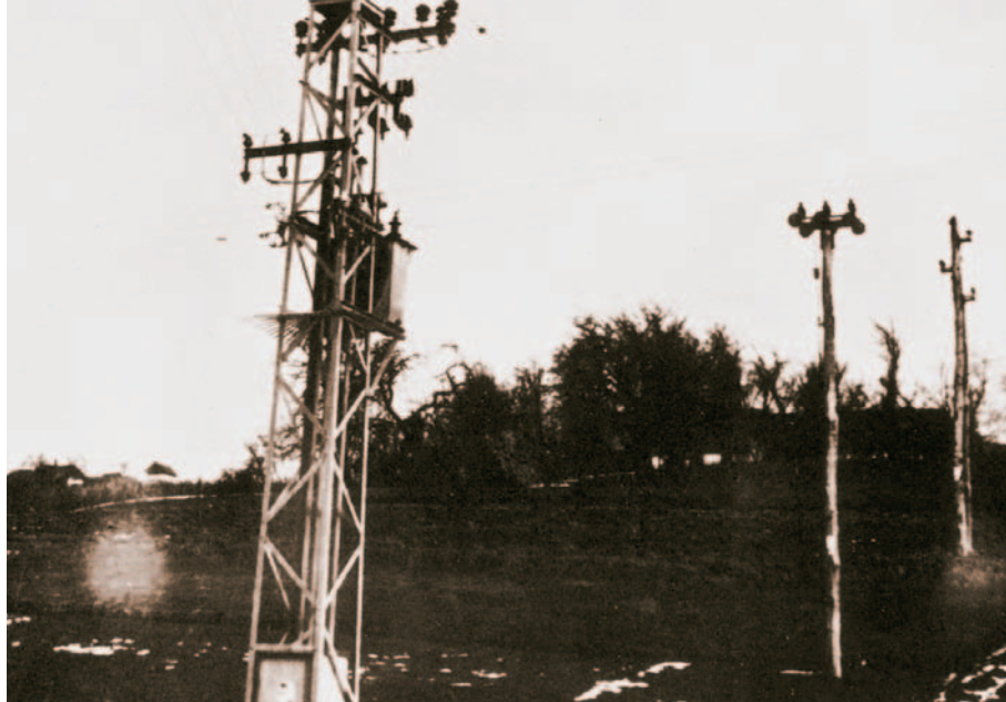
Distribucijska 10/0,4 kV transformatorska stanica na čeličnoretkastom stupu
