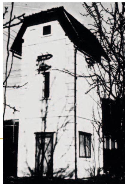
Zidana transformatorska stanica – tornjić, u Varaždinskim Toplicama
