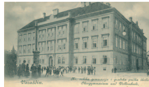
Reprezentativna zgrada Kraljevske velike gimnazije i gradske pučke škole izgrađena je nakon požara 1776.
