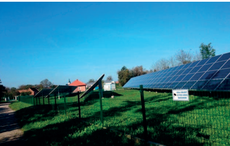
Neintegrirana sunčana elektrana Auto-Blaži priključne snage 130 kW na lokaciji Petrijanec
