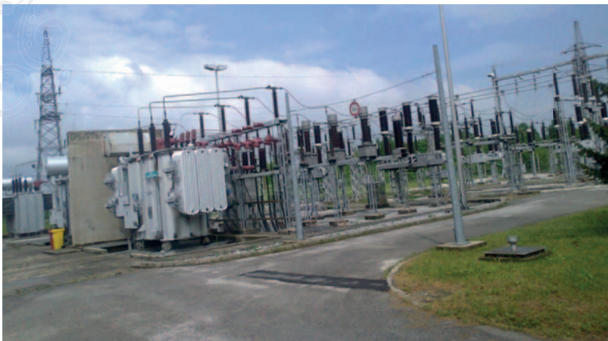
Dogradnja transformatorske stanice 110 kV Varaždin završena je 2007. godine
