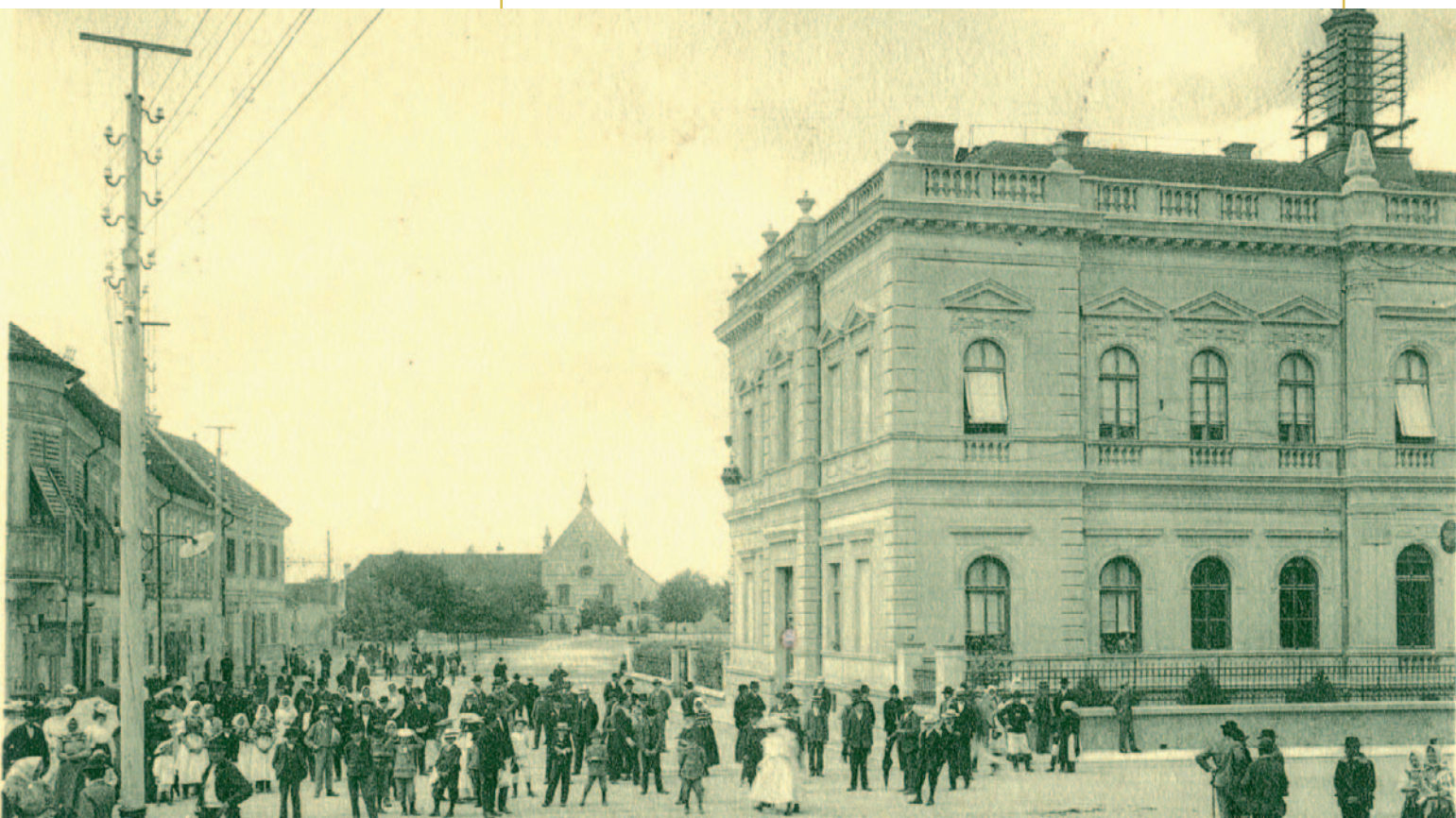
Reprezentativna zgrada Kraljevske pošte (i stup gradske električne mreže na Kapucinskom trgu)
