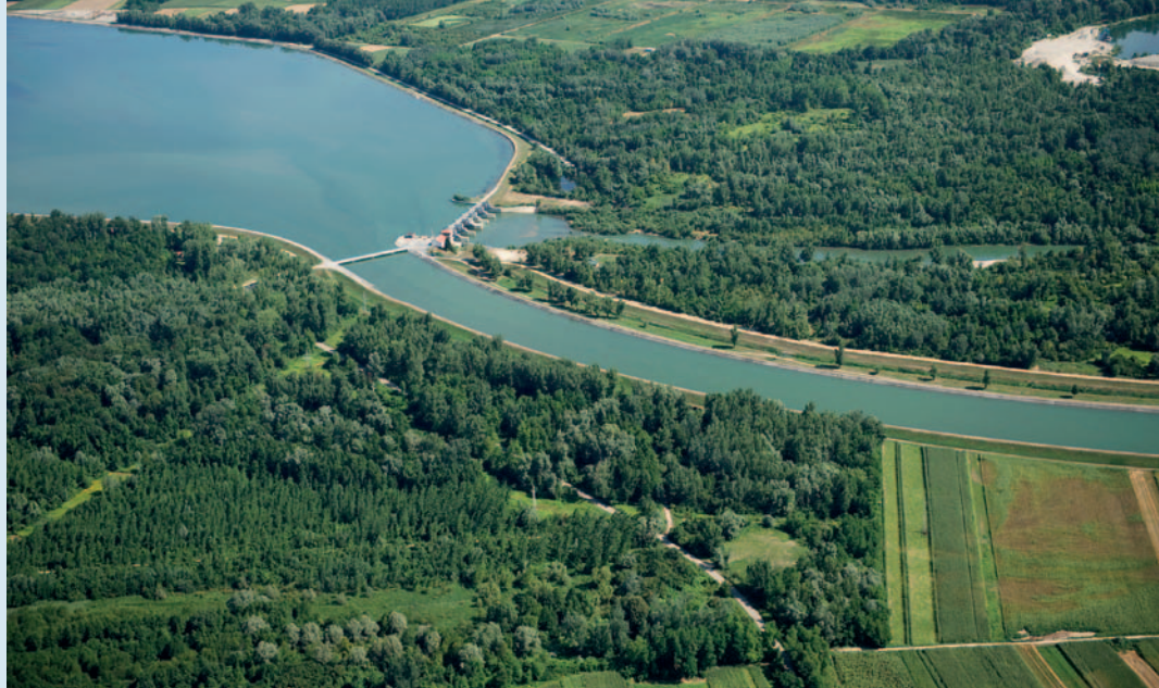
Brana i akumulacijsko jezero Hidroelektrane Varaždin
