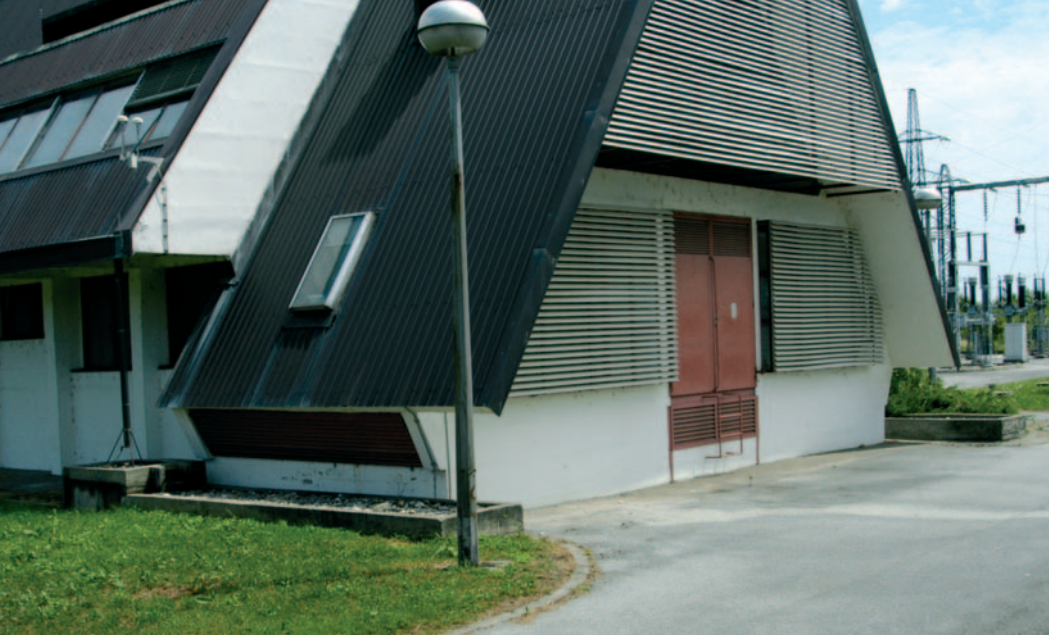
Transformatorska stanica 110/35/10 kV Varaždin bila je važan tehnološki iskorak Elektre Varaždin u području pogonske sigurnosti
