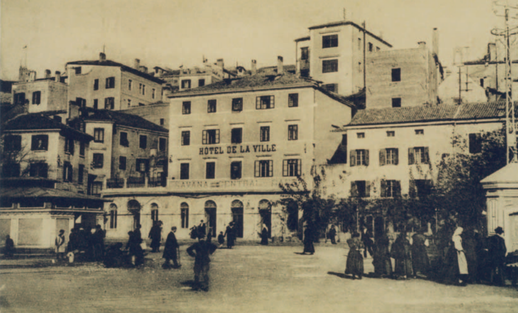
Šibenik: transformatorska stanica (desno)
