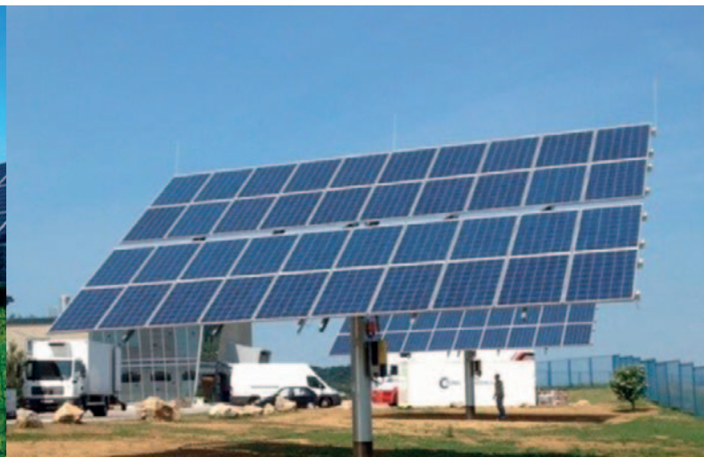
Neintegrirana sunčana elektrana Croma priključne snage 25 kW na lokaciji Sv. Ilija (tzv. tracker sustav)
