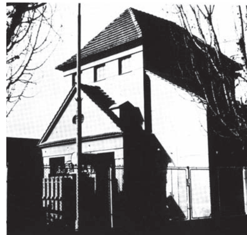
Prva transformatorska stanica 36/6 kV u Varaždinu
