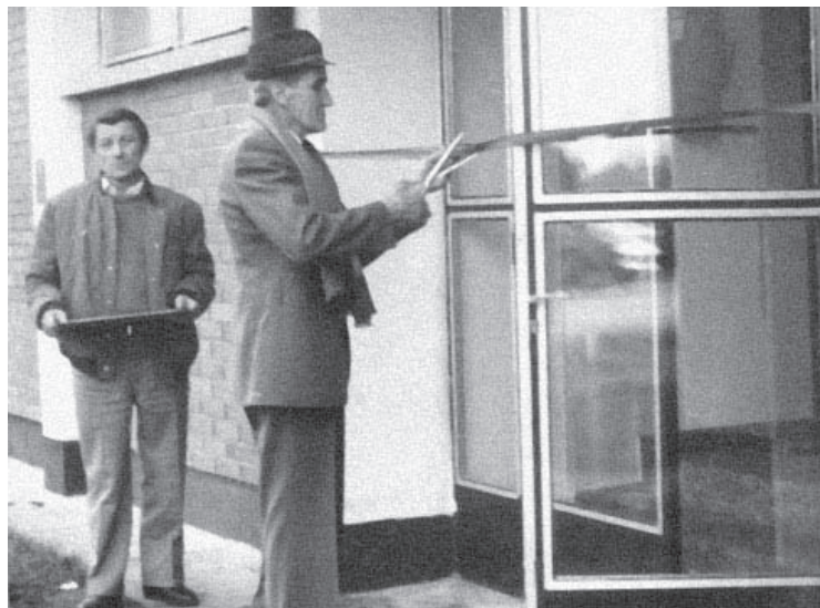
GABRIJEL MATAIJA I IVAN BOGDAN PRIGODOM PUŠTANJA U RAD TRANSFORMATORSKE STANICE 35/10 kV BOROVO NASELJE
