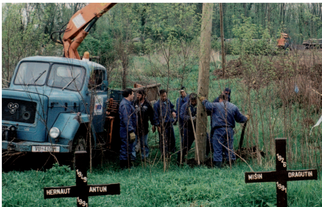
EKIPA POGONA VUKOVAR POSTAVLJA STUPOVE JAVNE RASVJETE UZ MASOVNE GROBNICE NA NOVOM VUKOVARSKOM GROBLJU DUBRAVA
