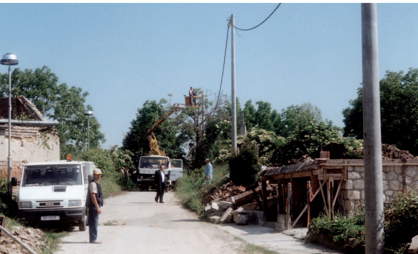
U POTPUNO RAZRUŠENOJ RATARSKOJ ULICI NA MITNICI POSTAVLJA SE NISKONAPONSKA MREŽA I JAVNA RASVJETA, A NA TOM NAJRAZRUŠENIJEM DIJELU VUKOVARA RADILA JE EKIPA ELEKTRE ZAGREB
