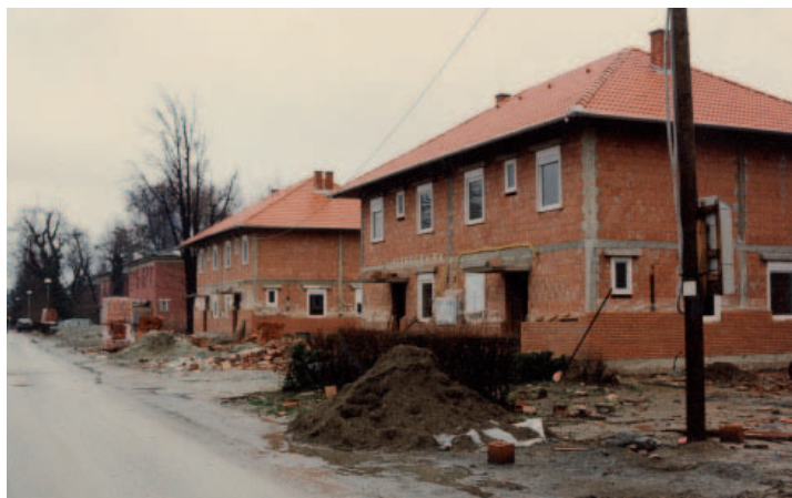
OBNOVLJENA ELEKTROENERGETSKA INFRASTRUKTURA ČEKA OBNOVU KUĆA U BOROVU NASELJU
