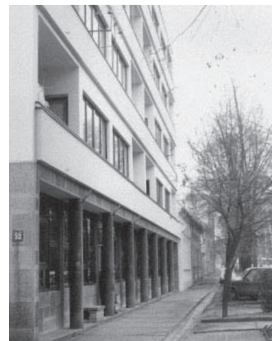
... NOVI POSLOVNI PROSTOR U PRIZEMLJU ZGRADE U ŽUPANIJSKOJ ULICI
