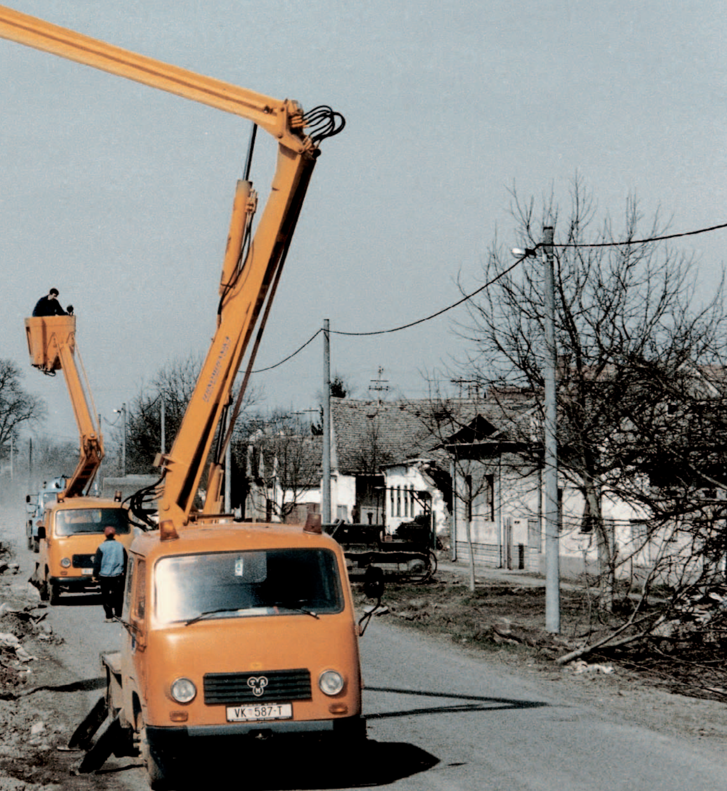
IZGRADNJA NISKONAPONSKE MREŽE I JAVNE RASVJETE U NIJEMCIMA
