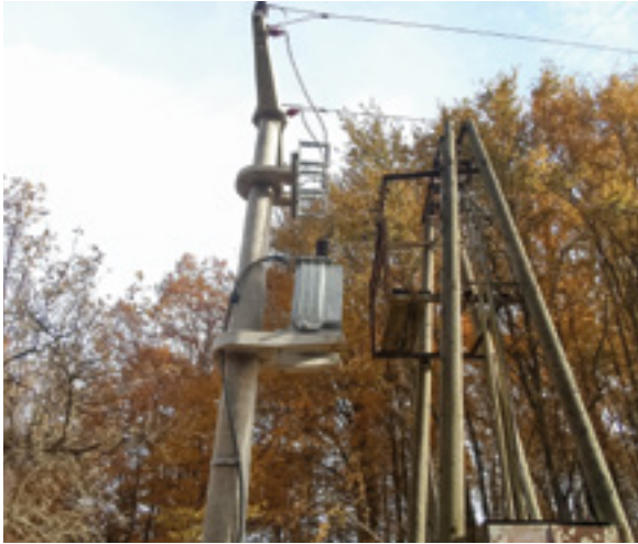
Slika 18/IV. TS 10(20)/0,4 kV na armiranobetonskom stupu (lijevo) i TS 10/0,4 kV na drvenim stupovima (desno)
