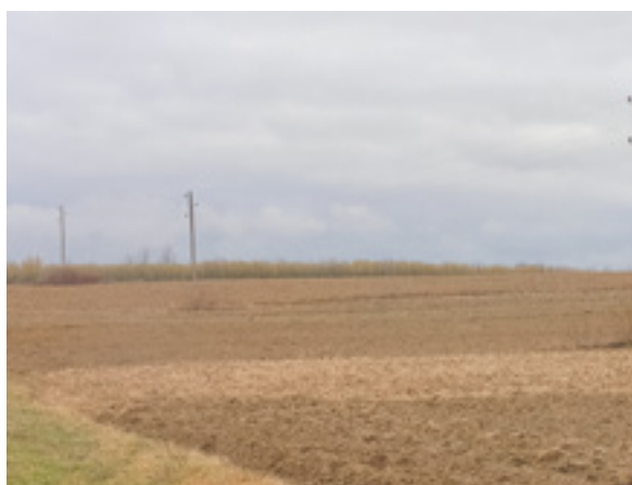
Slika 16/IV. 10 kV zračni dalekovod na drvenim stupovima
