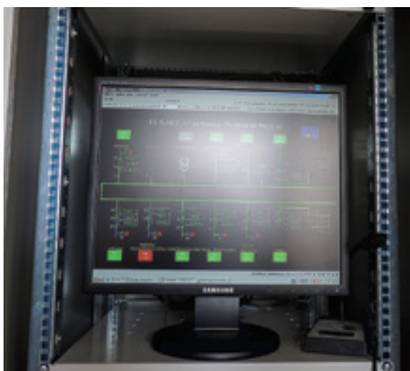
Slika 22/V. Stanično računalo u TS 35/10(20) kV Špišić Bukovica
