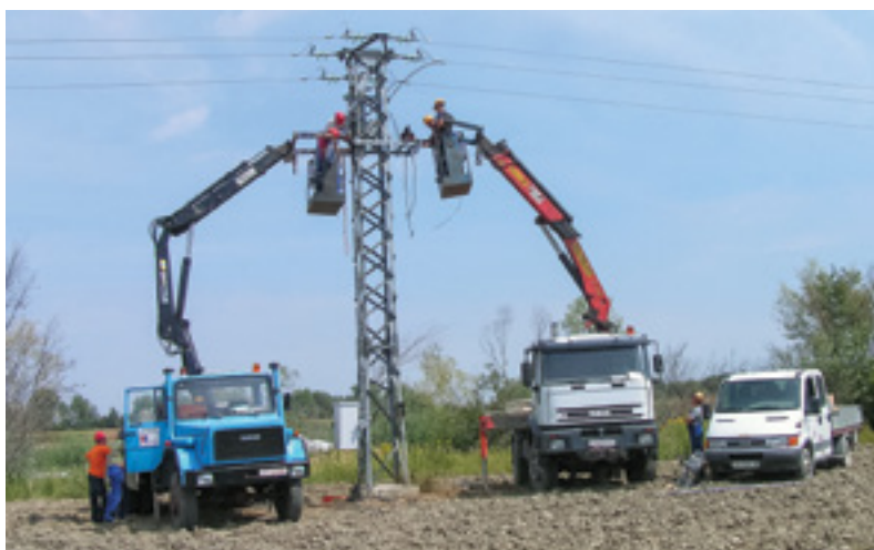
Slika 36/V. Montaža daljinske upravljive rastavne naprave - rastavljač
