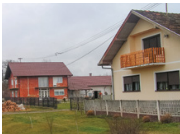
Slika 14/IV. Niskonaponska mreža na krovnim stalcima
