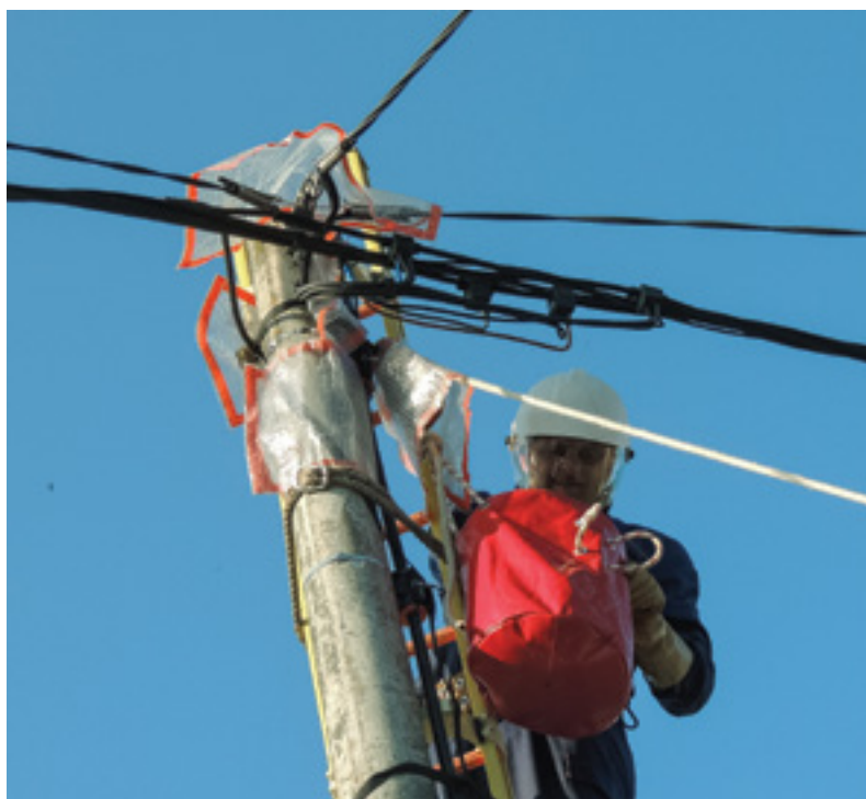
Slika 45/V. Rad pod naponom - rad s izoliranih ljestvi
