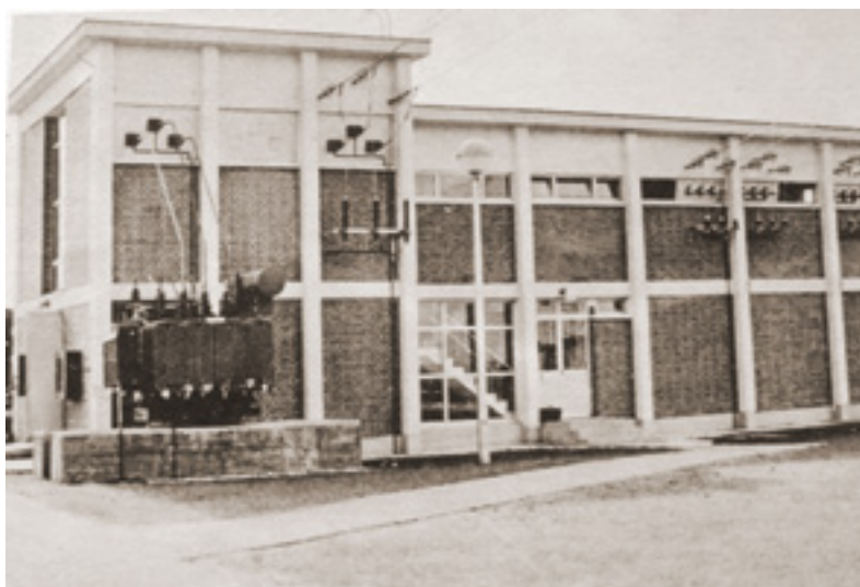
Slika 8/I. Trafostanica 35/10 kV u Špišić Bukovici
