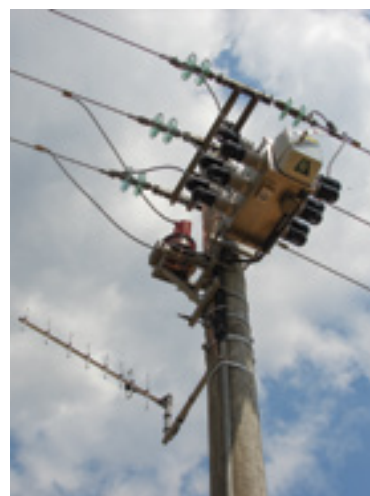
Slika 37/V. Daljinski upravljiva rastavna naprava (DURN)
