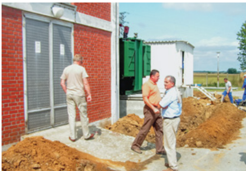
Slika 20/V. Nadzor rekonstrukcije TS 35/10(20) kV Suhopolje
