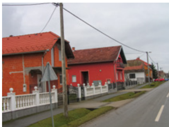
Slika 15/IV. Niskonaponska mreža na armiranobetonskim stupovima
