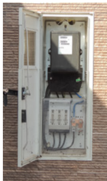
Slika 1/IV. Primjer sanacije i rekonstrukcije obračunskih mjernih mjesta
