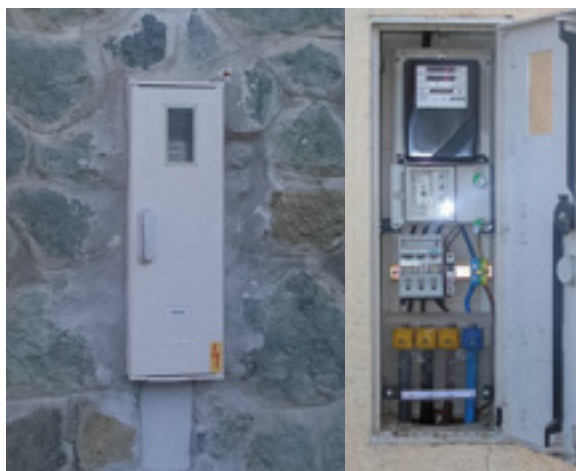
Slika 5/II. Mrežni kućnopriključni mjerni ormarić (MKPMO)
