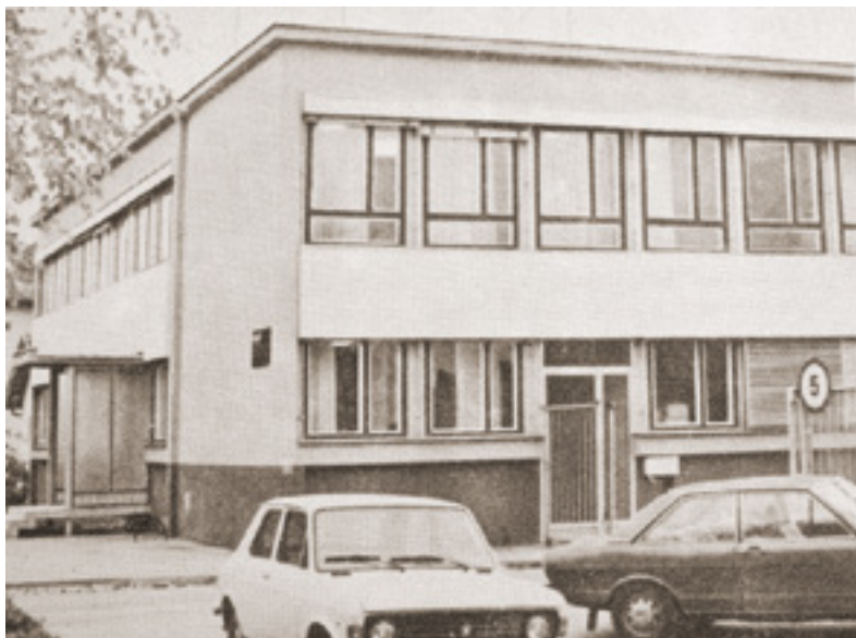
Slika 7/II. Upravna zgrada OOUR-a Elektra u Virovitici
