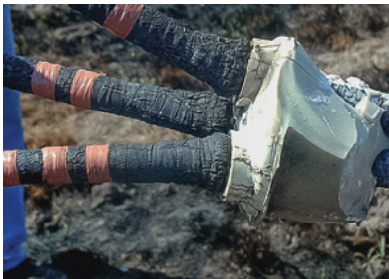
Slika 14/V. Kabelski završetak starog kabela koji se demontira
