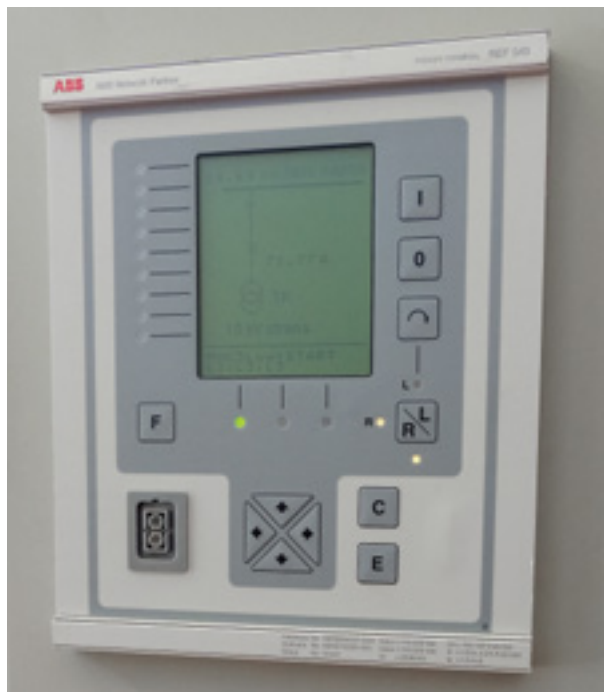
Slika 9/III. Numerički relej tipa REF 543 ugrađen 1999. g.
