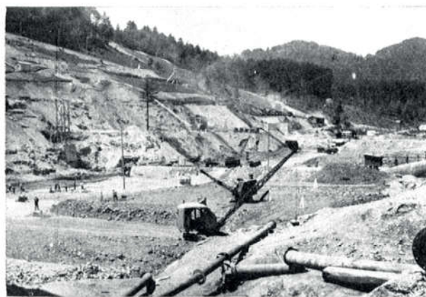
Sl. 5 — Izgradnja pregrade Lokvarka Stanje 31. 5. 1952.
