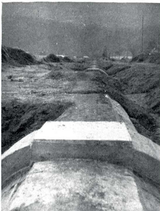
Sl. 28 — Cjevovod Lič prije zasipavanja
