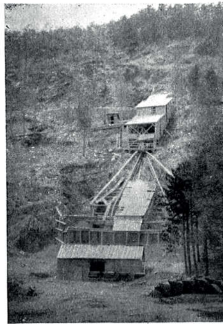
Sl. 6 — Vranjak: kamenolom, silosi i drobilana
