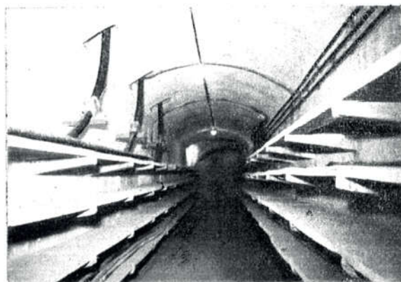
Sl. 7 — Kabelski kanal
