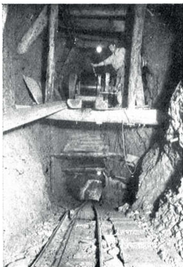
Sl. 13 — Kosa uzvlaka na gornji potkop u strojarnici
