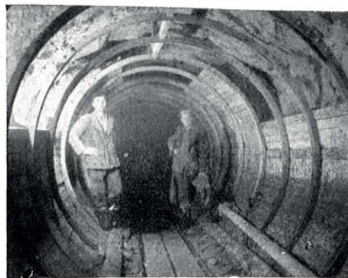
Sl. 5 — Tunelska oplata sa željeznim remenatima
