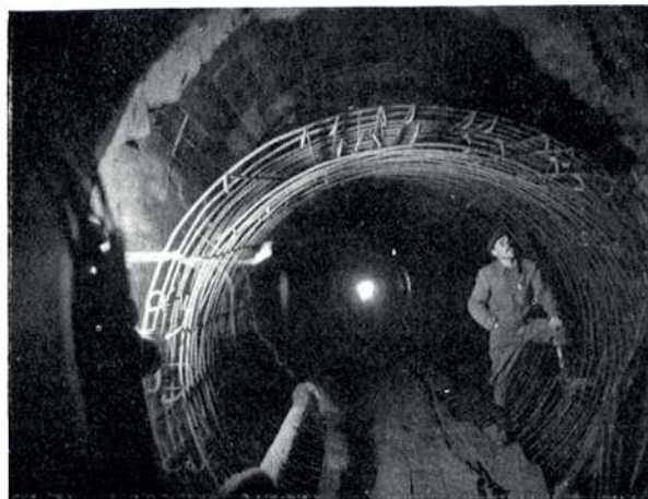
Sl. 29 — Tunel Kobiljak—Razromir, prolaz kroz vrtaču
