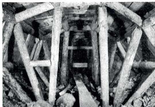
Sl. 11 — Gornji potkop prilaznog tunela u strojarnicu
