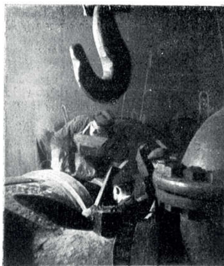
Sl. 4 — Montažni radovi u razdjelnoj komori
