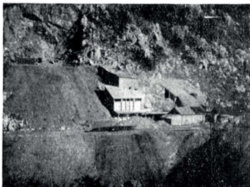
Sl. 4 — Gradilište Desni
