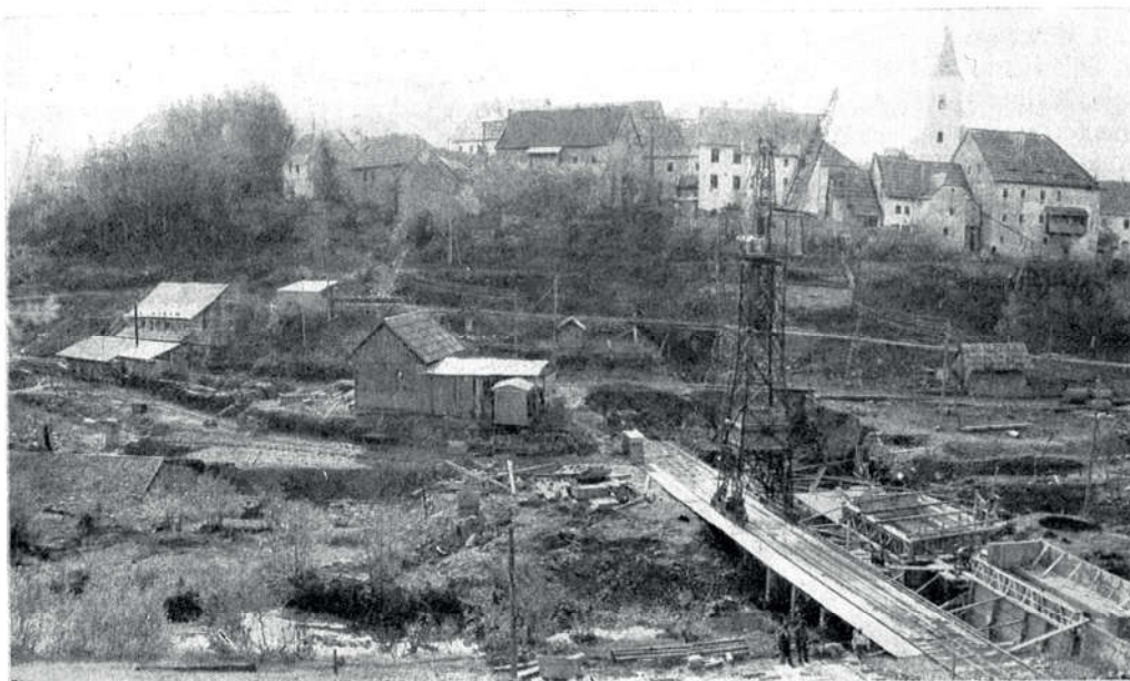
Sl. 2 — Gradilište pregrade Bajer u Fužinama
