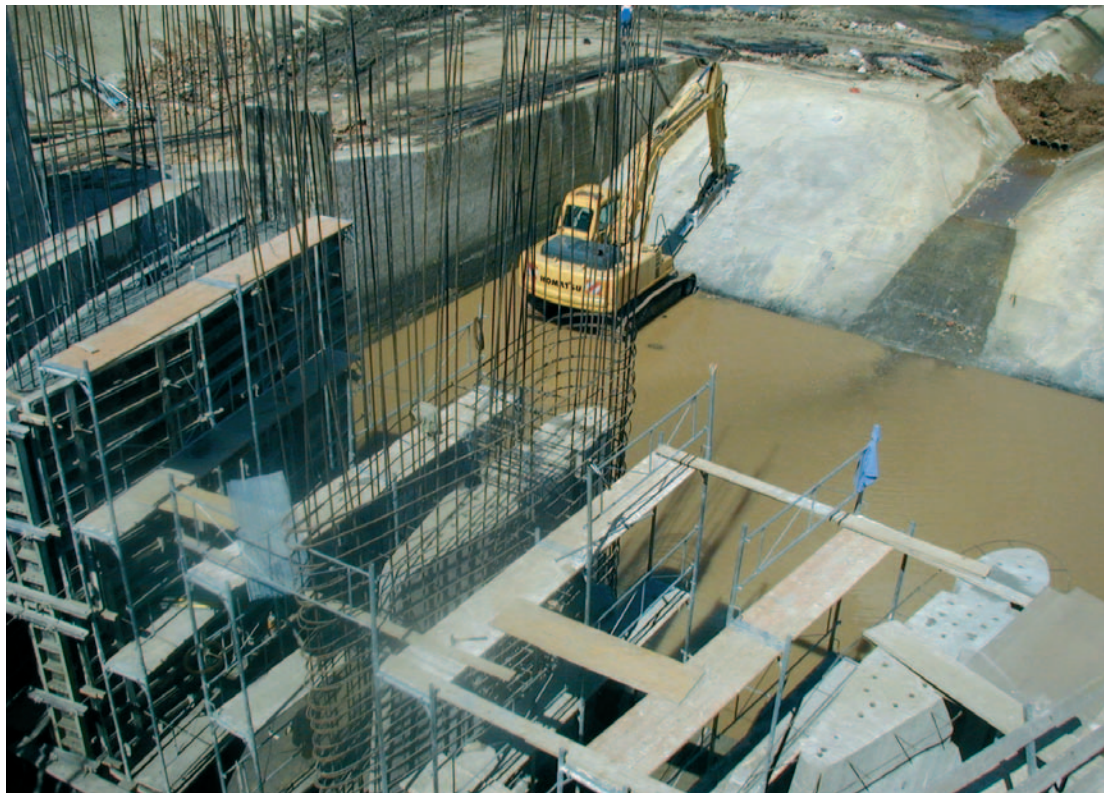
Izgradnja pomoćnih zatvarača u Gusić polju
