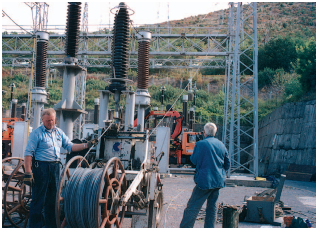
Postavljanje optičkog kabela
