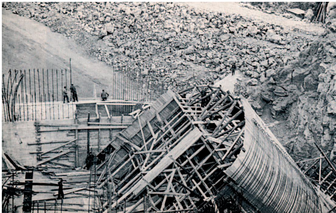
Preljevna građevina HE Sklope u izgradnji
