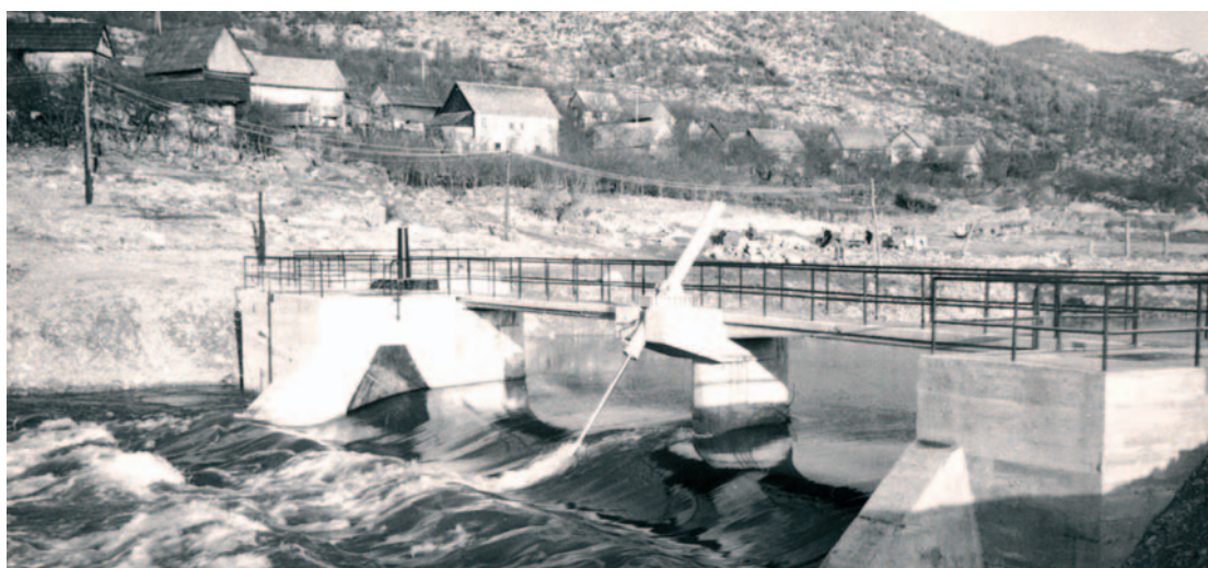
Preljevni zatvarač na zatvaračnici Selište
