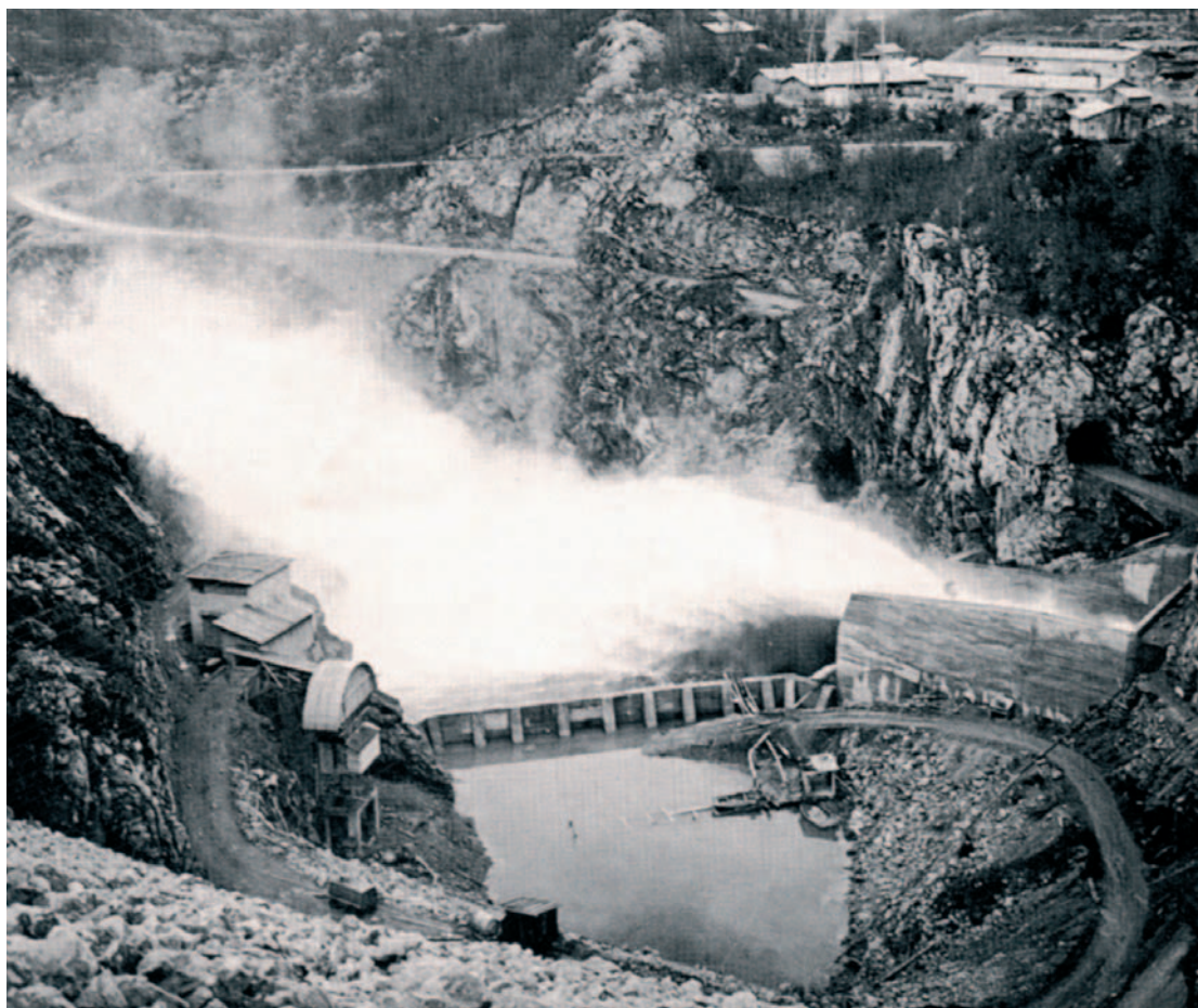
Probni rad preljeva pri protoku od 1200 \text{ m}^3/\text{s}
