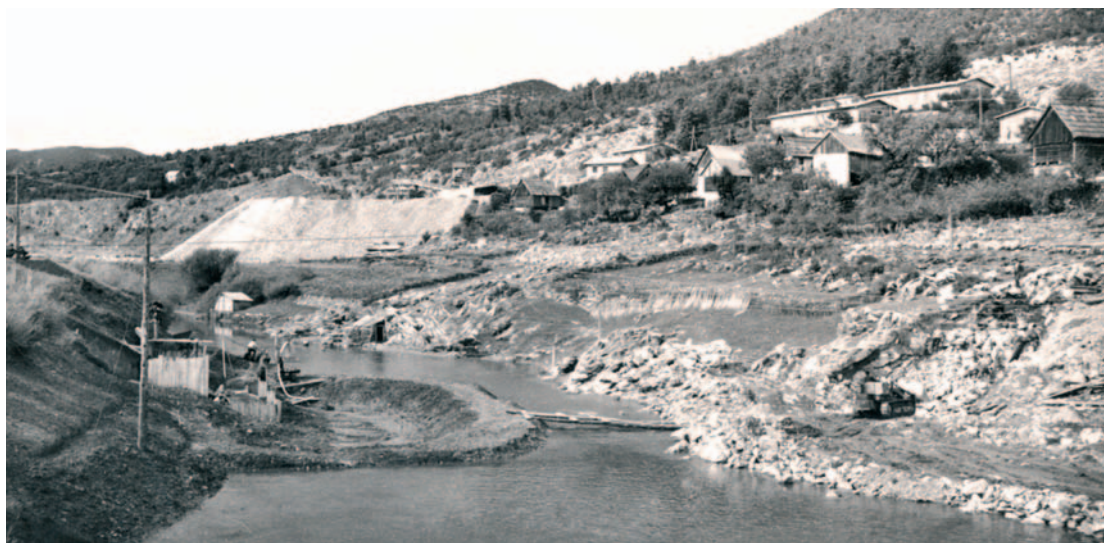
Gradilište zatvaračnice Selište
