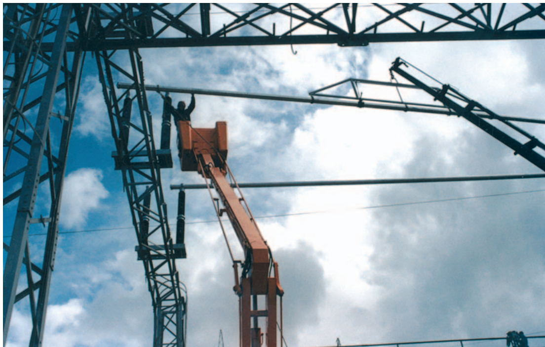
Zamjena sabirnica u rasklopištu 220 kV
