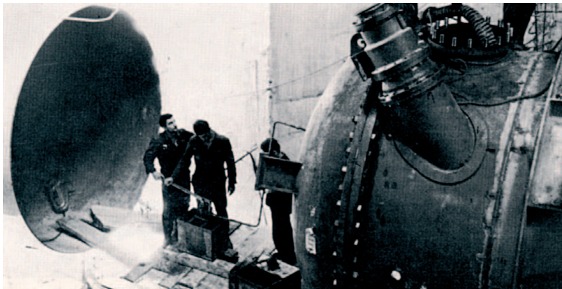
Montaža leptirastog zatvarača
