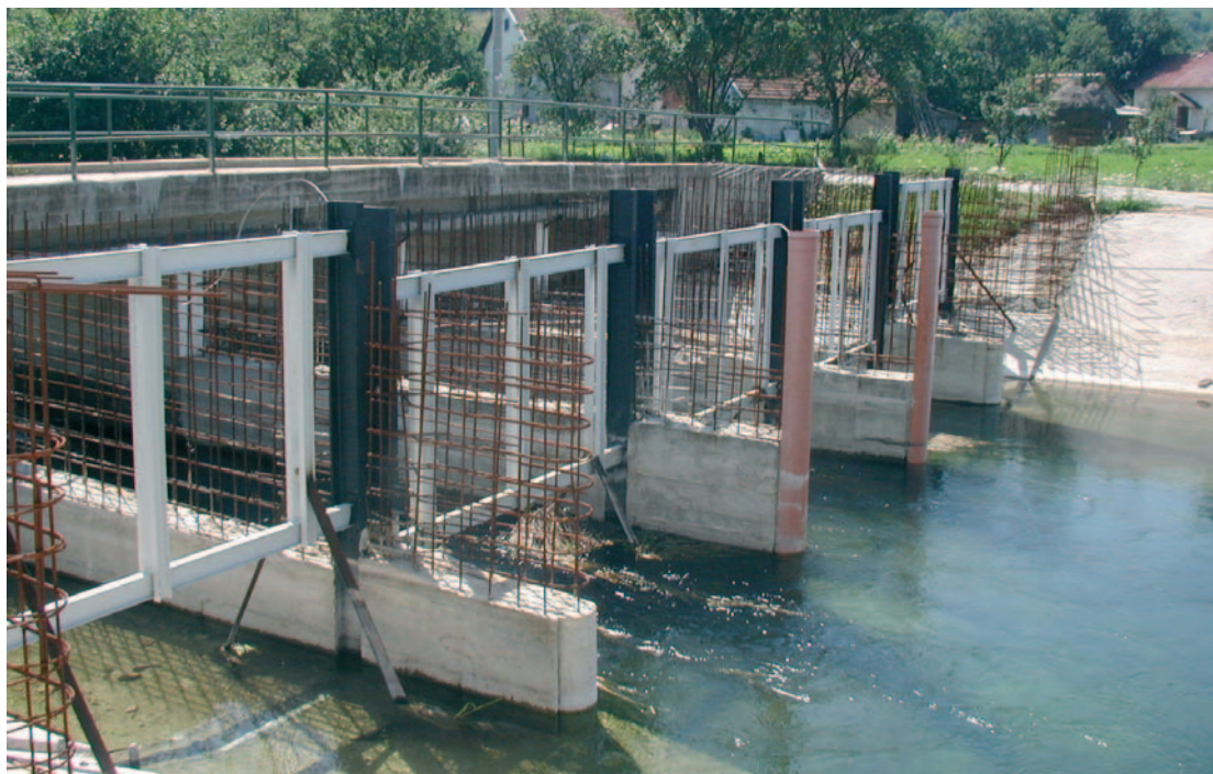
Izgradnja zatvarača na brani Vivoze
