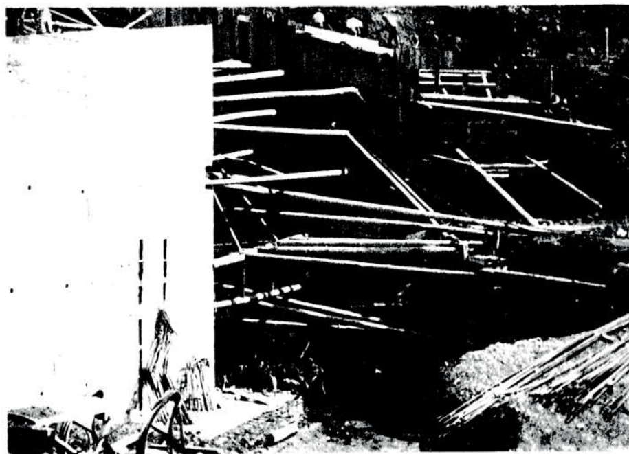
Duboki usjek ispred ulaza dovodnog tunela zahtijeva teške betonske zidove i razupiranje
