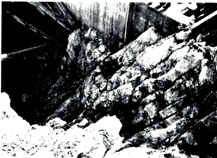
Razlomljena stijena ispod temelja brane
