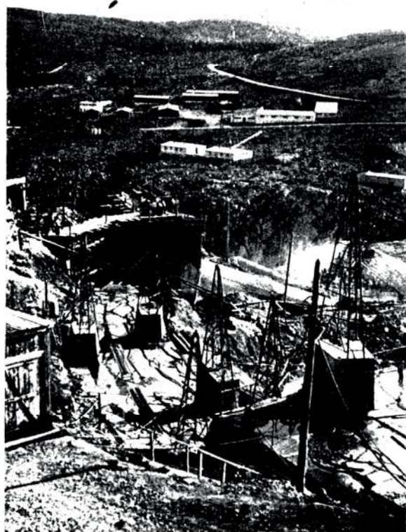
Bušilice za injektiranje zavjese na lijevom boku uz branu, ljeti 1958
