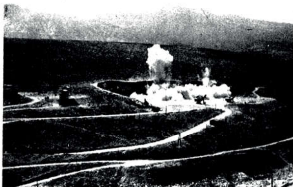
Miniranje u kamenolomu pomoću rednih dubokih mina odvaljuje jednim paljenjem 20—30000 m 3 kamena
