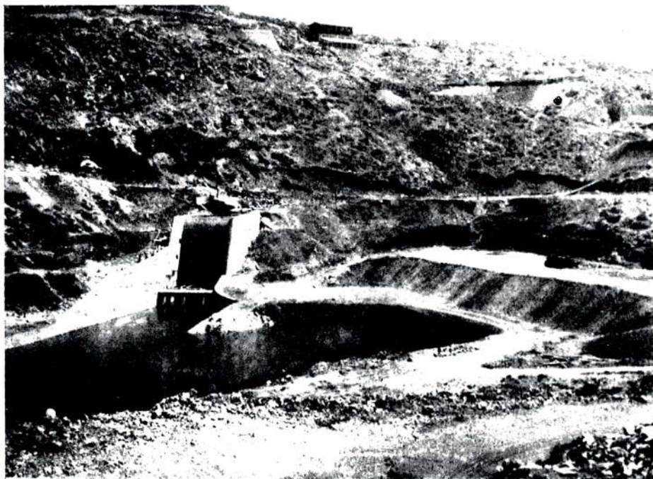
Ulazna građevina dovodnog tunela u toku gradnje
