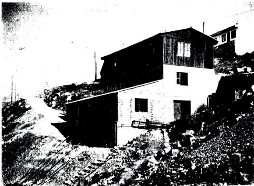
Centralna injekciona stanica Geo-istraživanja
