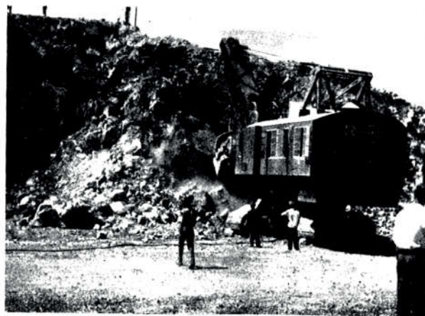
Bager Rapier s kašikom 3,7 m 3 grabi odvaljeni kamen i utovaruje na kamione
