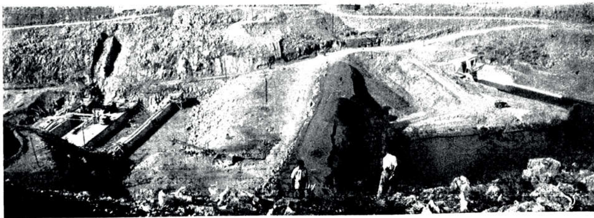
Zagati i iskop temelja za jezgru brane, ljeto 1956. god.
