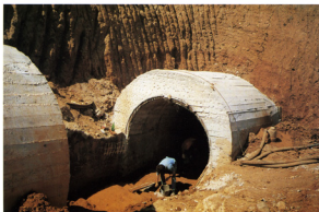
Foto 4. Iskop injekcijske galerije od sta: 0+90,58 do sta: 0+93,00 u vremenu od 12. srpnja 1994 do 28. srpnja 1994 kroz nebetonirani dio galerije
