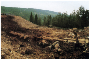
Foto 29. 2. srpnja 1994 Desni kraj brane - uklanjanje oštećenih dijelova galerije
