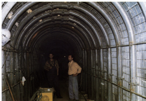
Foto 13. Početak radova na obnovi injekcijske galerije
