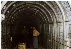
Foto 8. Pristupni tunel br. 2 nakon osiguranja čeličnim lukovima
