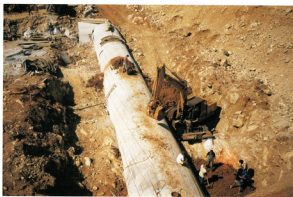
Foto 35. 12. kolovoza 1994 godine - Početak ugradnje gline na desnom kraju brane
