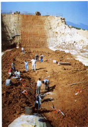
Foto 3. Ugradnja čelija za mjerenje pritiska porne vode i totalnog pritiska na lijevom kraju brane
