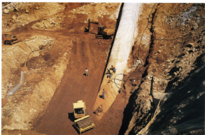
Foto 36. 19. kolovoza 1994 godine - Nasipavanje na lijevom kraju brane, kota 334,10 m n.m.
