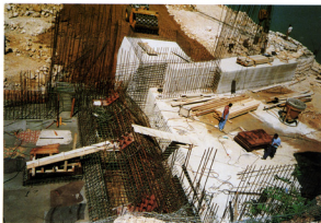
Foto 8. 21. lipnja 1995. godine - Radovi na preljevnoj građevini
