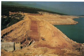
Foto 31. 1. srpnja 1994 godine - Lijevi kraj brane - potpuno završen iskop
