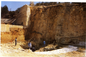
Foto 2. Iskopana građevinska jama preljeva i postavljanje armature okna cilindra
