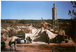
Foto 4. Betonara za potrebe sanacije galerije na radnom platou ispred ulaznog hodnika br. 2
