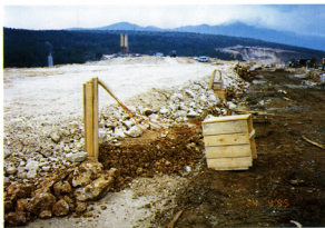
Foto 11. Zaštita kabela mjernih uređaja za vrijeme gradnje
