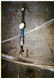
Foto 10. Mjerenje konvergencije obloge injekcijske galerije
