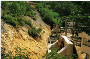
Foto 41. 2. kolovoza 1994 godine - na nizvodnoj nožici brane u fazi izgradnje
