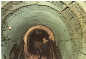
Foto 16. Obloga od mlaznog betona
