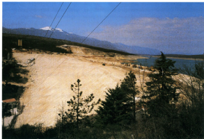
Foto 1. Završni radovi na obnovi brane
