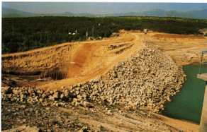
Foto 2. Iskop lijevog kraja brane
