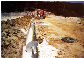
Foto 9. Ugradnja ekstenzometra u krunu brane
