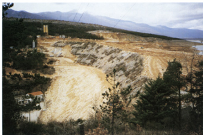
Foto. 40. 27. veljače 1995. godine - Ugradnja kamenog materijala u nizvodnu potpornu zonu; kota 339,50 m n.m.
