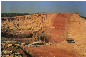
Foto 2. 2. srpnja 1994 godine - Lijevi kraj brane - potpuno završen iskop
