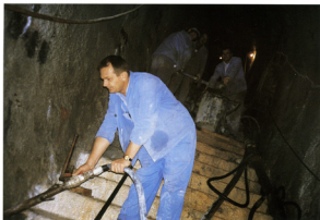
Foto 46. Vezno injektiranje u injekcijskoj galeriji
