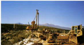
Foto 45. 2. studenog 1994 godine - Izvođenje glino-betonske dijafragme i ugradnja materijala na lijevom kraju brane
