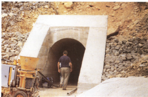
Foto 7. Obnovljeni portal u pristupni hodnik br. 2
