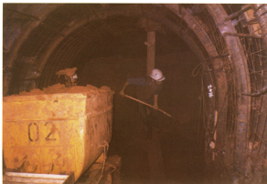
Foto 21. Utovar iskapanog materijala u vagonet
