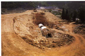
Foto 22. 21. srpnja 1994 godine - Izvedba injekcijske galerije na desnom kraju brane
