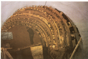
Foto 31. i 32. Obnova galerije podgrađivanjem i mlaznim betonom s lijevog kraja brane
