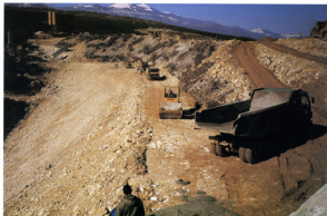
Foto 37. 10. ožujka 1995 godine - Ugradnja materijala u nizvodnu potpornu zonu - proširenje brane za 5,0 m; kota 345,00 m n.m.
