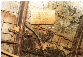
Foto 22. Procjeđivanje vode u galeriju na koti 321,80
