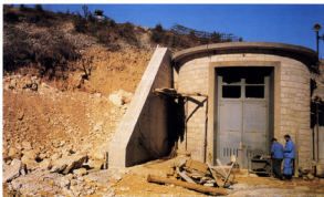
Foto 3. Potporni zid oko kućice pomoćnog zatvarača
