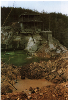
Foto 4. Pogled na lijevi kraj brane
