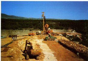
Foto 5. Zasipavanje nizvodnog filtrarskog rova filtrarskim materijalom
