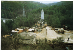
Foto 16. Pogled na gradilišne objekte za rekonstrukciju injekcijske galerije
