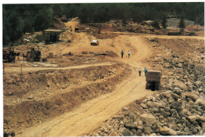
Foto 26. Prilazna rampa prema lijevom kraju brane
