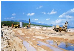
Foto 49. Injektiranje sa kote 353,00 m n.m.
