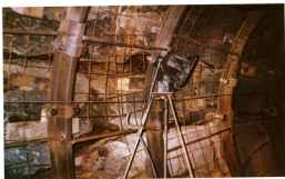
Foto 4. Detalj rekonstrukcije galerije čeličnim lukovima, mlaznim betonom i injektiranjem
