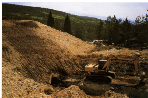
Foto 3. 15. rujna 1994 godine - Desni kraj brane - potpuno završen iskop
