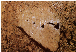
Foto 7. Jame iskopane u glinenoj jezgri za ugradnju čelija u raznim smjerovima
