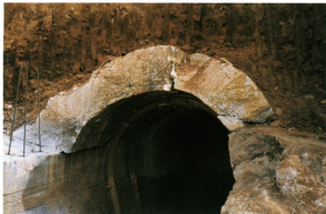
Foto 15, 10. srpnja 1994. godine - Injekcijska galerija nakon završenog iskopa na sta: 3+42,00 - desni kraj brane
