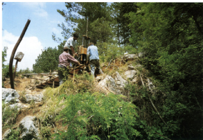
Foto 47. 19. lipnja 1995 godine - Injekcijski radovi na lijevom kraju brane
