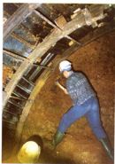
Foto 19. Obnovljeni dio potpuno razrušene galerije betonskom oblogom debljine 80 cm
