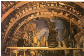
Foto 35. i 36. Spajanje zadnjih dijonica galerije
