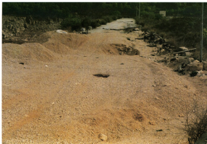
Foto 24. Pogled od desnog kraja brane prema kraterima sta: 3+62,00 - otvorio se dana 2. svibnja 1993 godine sta: 3+42,00 - otvorio se dana 3. lipnja 1993 godine
