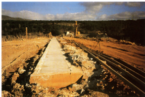
Foto 6. Vrh izvedene dijafragme na desnom kraju
