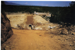
Foto 30. 15. srpnja 1994 godine Desni kraj brane - potpuno završen iskop
