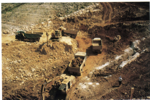
Foto 25. Iskop na lijevom kraju brane - Transport se odvija preko rampe na uzvodnoj strani
