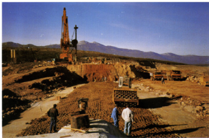
Foto 5. 29. studenog 1994 godine - Izvođenje glinobetonske dijafragme sta: 1+55,00 i izvođenje tijela brane na lijevom kraju; kota 347,00 m n.m.
