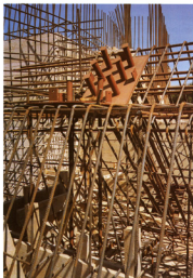
Foto 3. Sídra i sidrene ploče ležaja preljevne klapne
