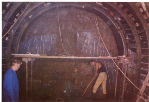
Foto 17. Osiguranje iskopa pomoću čeličnih lukova i platice - na slici se vide urušeni betonski blokovi
