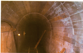
Foto 19. Obnovljeni dio potpuno razrušene galerije betonskom oblogom debljine 80 cm
