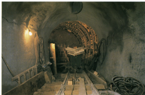
Foto 20. 19. listopada 1994 godine - Priprema oplata za betoniranje dionice od sta: I+17,53 do sta: I+22,78
