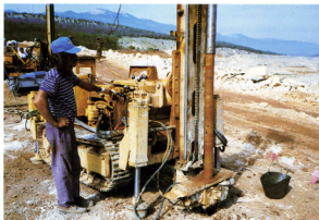
Foto 1. Geotehnički istražni radovi - bušenje jezgre i temeljne stijene
