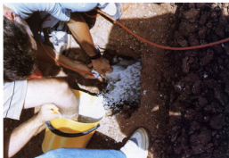
Foto 5. Ugradnja čelije za mjerenje tlaka porne vode u glinenu jezgu brane
