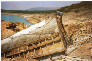
Foto 29. Obnova injekcijske galerije na lijevom kraju brane
