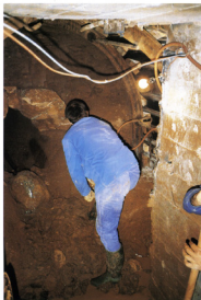
Foto 19. 21. rujna 1994 godine - Iskop drenažnog odvoda iz galerije na sta: 1+42,00
