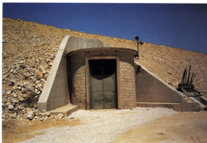
Foto 43. Pogled na kućicu pomoćnog zatvarača temeljnog ispusta i zaštitni zid
