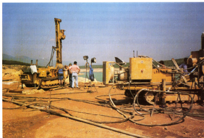
Foto 2. Izvedba injektiranja
