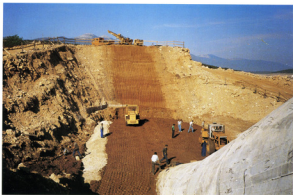
Foto 34. 7. rujna 1994 godine - Ugradnja materijala u lijevi kraj brane, kota 338,50 m n.m.
