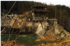
Foto 1. Preljevna građevina nakon miniranja
