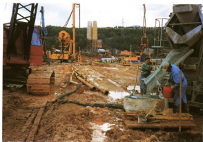
Foto 3. Betoniranje panela
