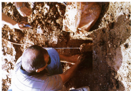
Foto 8. Ugradnja čelije za mjerenje totalnog pritiska
