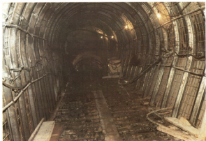
Foto 15. Osiguranje galerije podupiranjem pomoću čeličnih lukova
