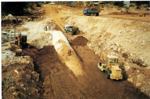
Foto 38. 1. rujna 1994. godine - Ugradnja gline na desnom kraju brane; kota 348,50 m n.m.
