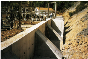
Foto 42. 7. rujna 1994 godine - Izgrađeni potporni zid na nizvodnoj nožici brane
