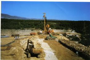
Foto 39. 23. rujna 1994. godine - Ugradnja filtera na desnom kraju brane; kota 353,20 m n.m.
