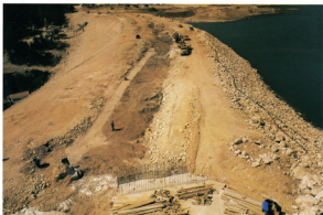
Foto 7. Radovi na izgradnji tijela brane iznad kota 353,00 m n.m. i 358,00 m n.m.
