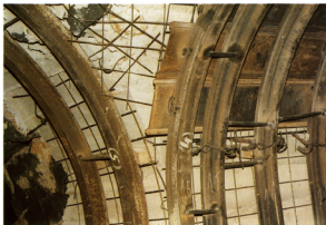
Foto 9. Podupiranje oštećenog svoda na spoju galerije i pristupnog hodnika br. 2
