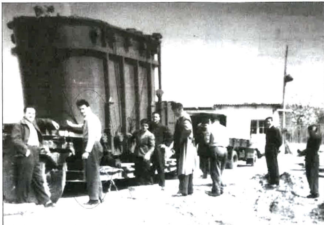
Istovar transformatora u TS 110/30 kV Matulji 1955. godine
