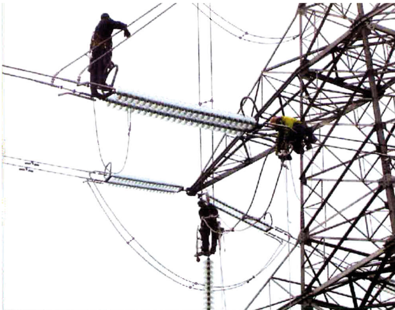
Radovi na usklađenju redoslijeda faza hrvatskog i zapadnoeuropskog elektroenergetskog sustava na DV 2 × 400 kV Tumbri-Krško, 2004. godine
