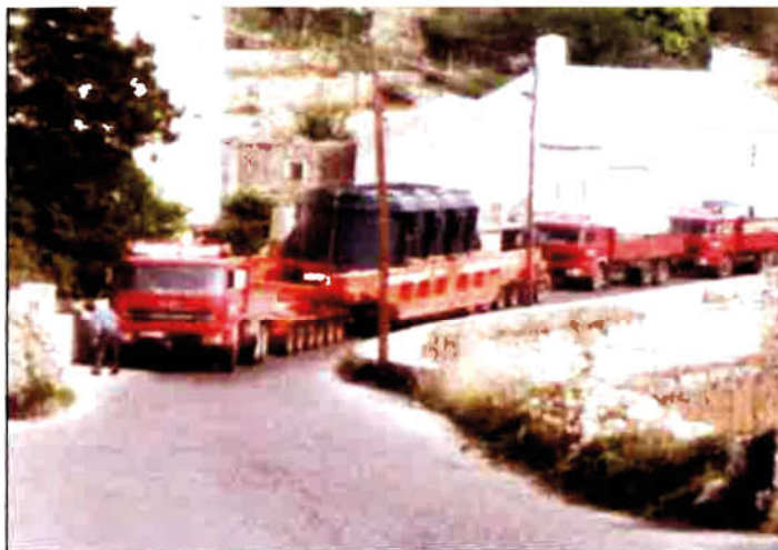
Transport transformatora za TS 400/220/110 kV Melina 1981. godine; prvo vozilo tegli, a dva vozila otraga podupiru tegljenje
