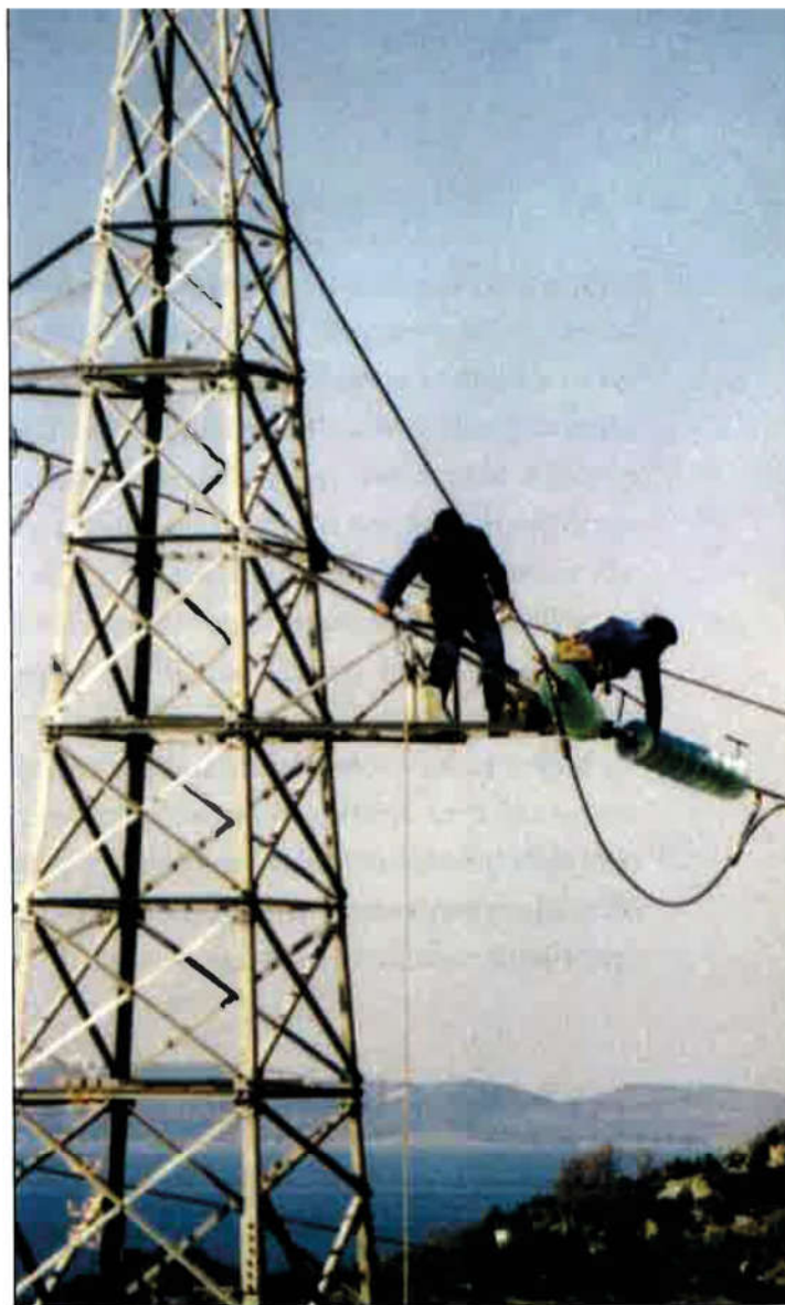
Intervencija na dalekovodnom stupu
