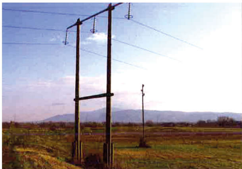
DV 110 kV Samobor–Rakitje (sadašnji snimak), to je dionica negdašnjeg dalekovoda 110 kV na drvenim stupovima Zagreb–Bre- stanica, izgrađenog 1943. godine i korištenog od 1949. godine pod naponom 110 kV
