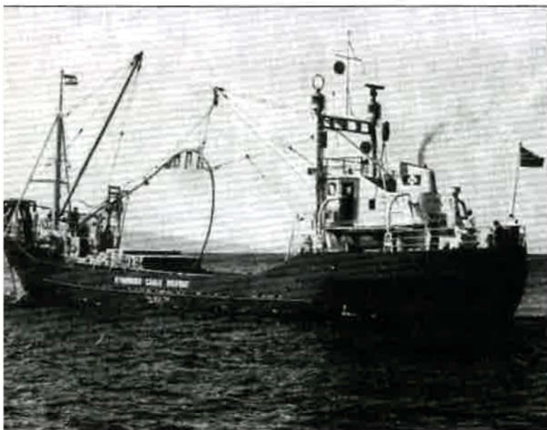
Polaganje kabela 110 kV Hvar–Korčula 1972. godine
