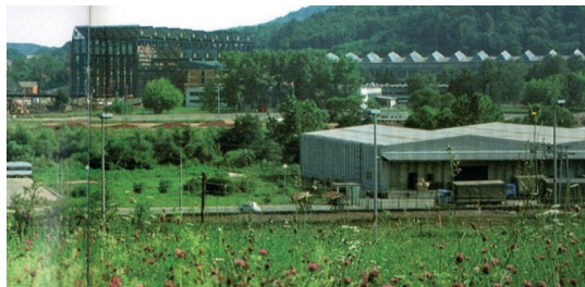
Sl. 10.: Hala velikih turbina u izgradnji 1983. godine
