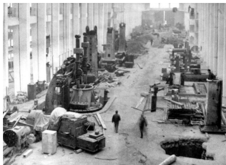
Sl. 1.: Početak montaže strojeva 1952. u glavnoj hali u Mrzlom Polju
