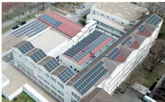
FNE s baterijskim spremnicima el. energije (mikromreža) FERIT 1
