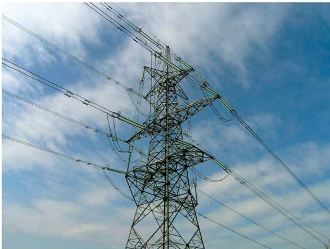
Slika 6.7. DV2x400 kV Žerjavinec – Heviz, preplet vodiča na stupu broj 225
