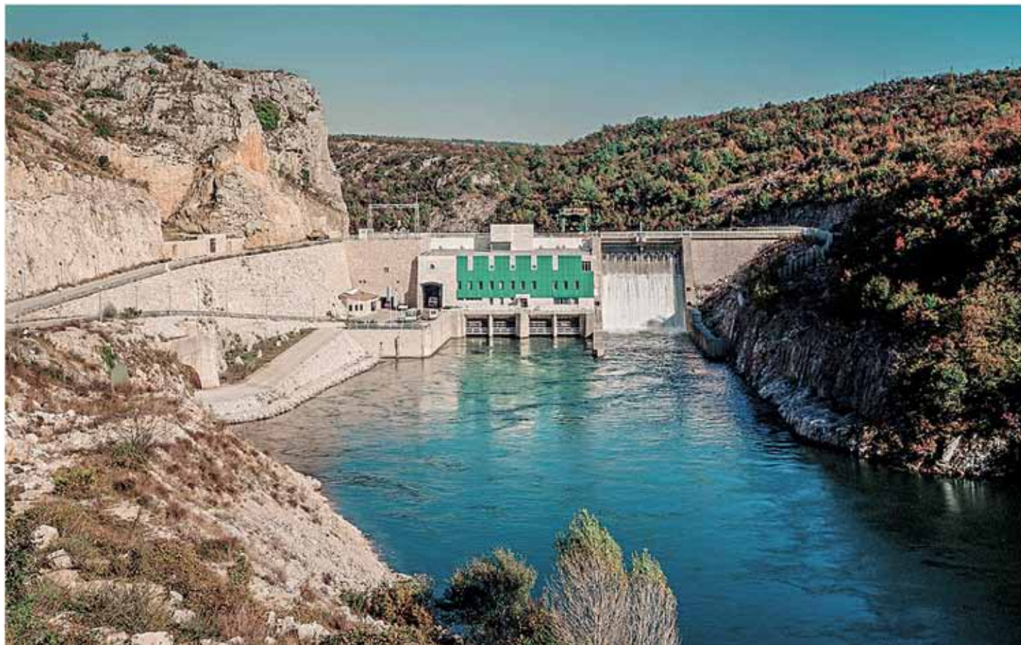
Bana HE Đale, uzvodno od najsnažnije hidroelektrane u Hrvatskoj, HE Zakučac, 538 MW, neto pad: 250 m. Proizvodnja električne energije 1,7 TWh (2019.)
