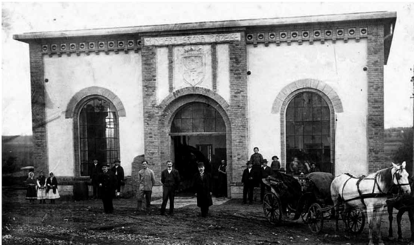
Pročelje Elektrane Kuzmica – Munjare grada Požege s gradskim grbom u sredini [24]
