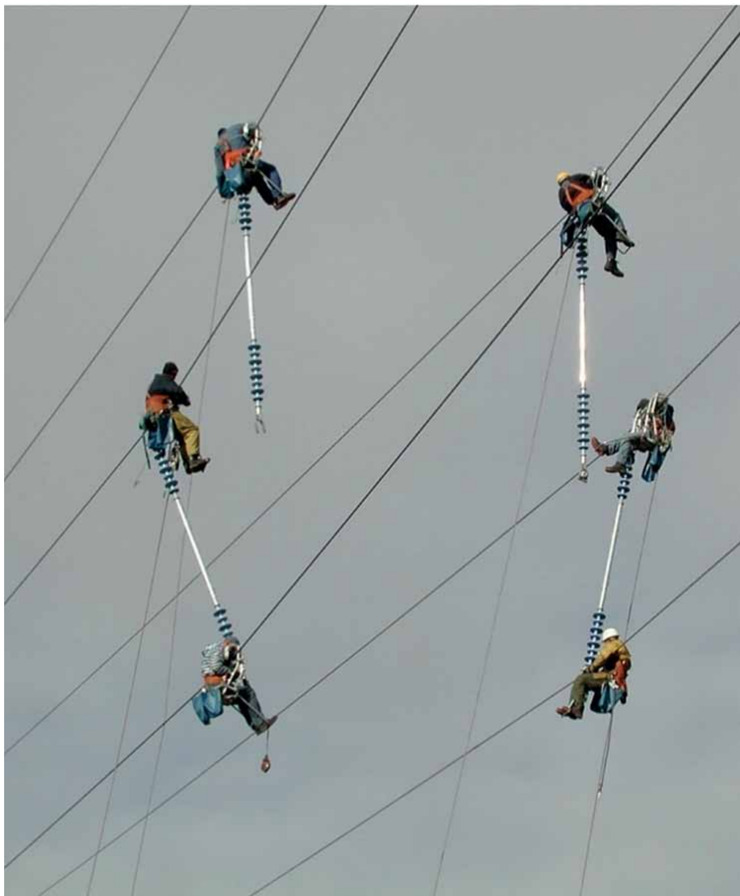
Ugradnja međufaznih rastojnika DV 2x110 kV u Sloveniji
