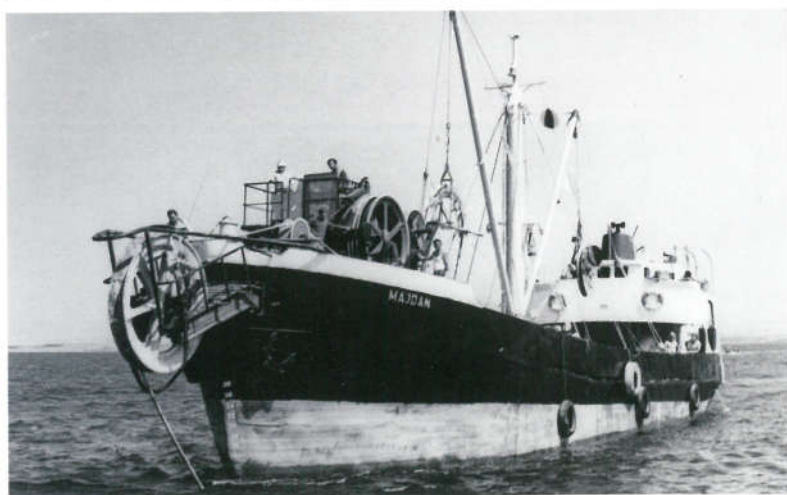
Brod MAJDAN s odgovarajućom opremom u Jadransko more spustio je puno kilometara kabela 10 kV i 35 kV
