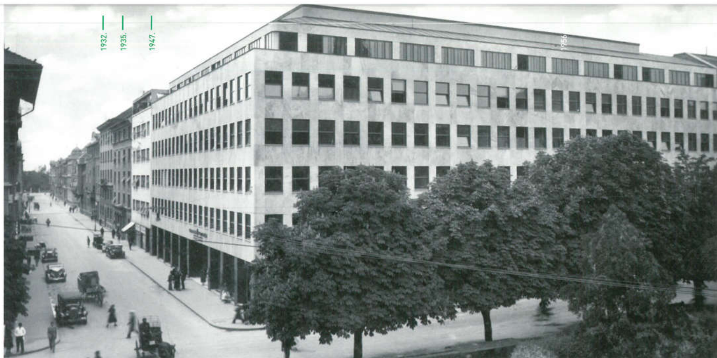
U poslovnoj zgradi u Gundulićevoj ulici, ponajprije izgrađenoj za potrebe zaposlenika GEC-a, uz namještenike Generalne direkcije elektroprivrede za NRH i Elektre Zagreb, bili su smješteni i zaposlenici poduzeća DALEKOVOD (snimljeno prije Drugog svjetskog rata)
