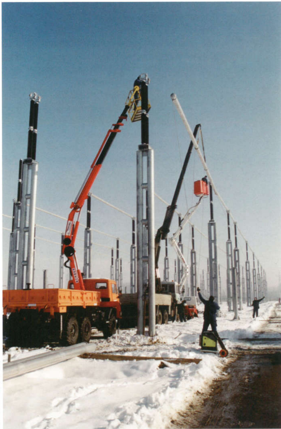
Tijekom temeljite obnove transformatorske stanice 400/110 kV Ernestinovo, u siječnju 2003. godine su montirane cijevi glavnih sabirnica 400 kV
