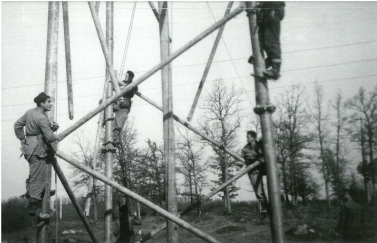
Montaža stupa u Škriljevu 1954. godine i ...
