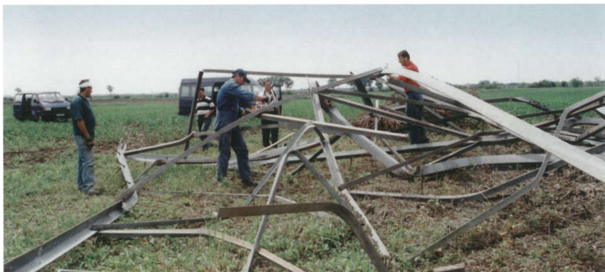
Demontaža uništenog i ...
