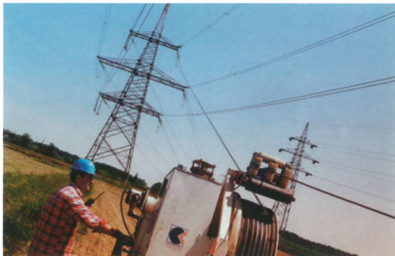
Montaža užeta na trasi sjeverne magistralne mreže dalekovoda 400 kV u Sloveniji
