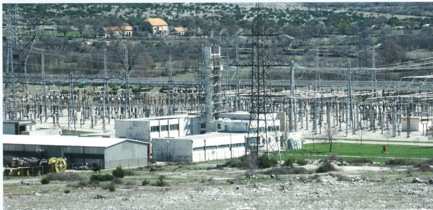
Projektanti Projektnog biroa, odnosno OOUR-a Dalekovodprojekt izradili su tehničku dokumentaciju za čelične konstrukcije i temelje za transformatorsku stanicu 400/220/110 kV Konjsko
