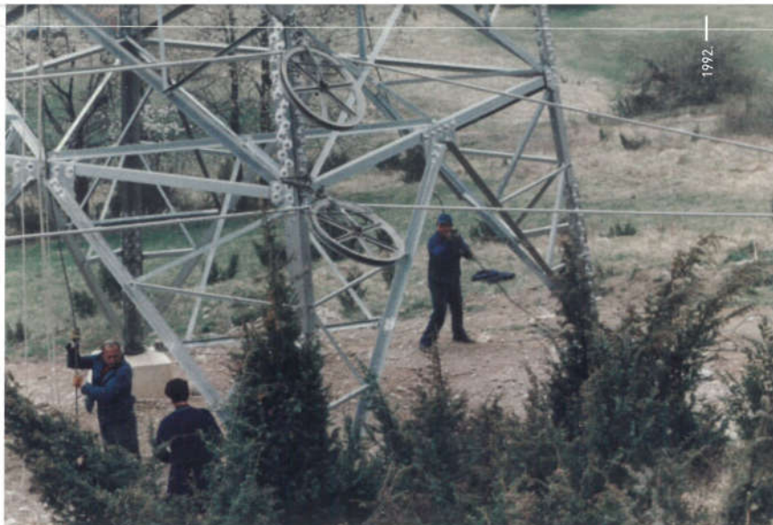
Svaki stup dalekovoda 400 kV Melina-Tumbri jedno je malo gradilište, a ukupno ih je 400
