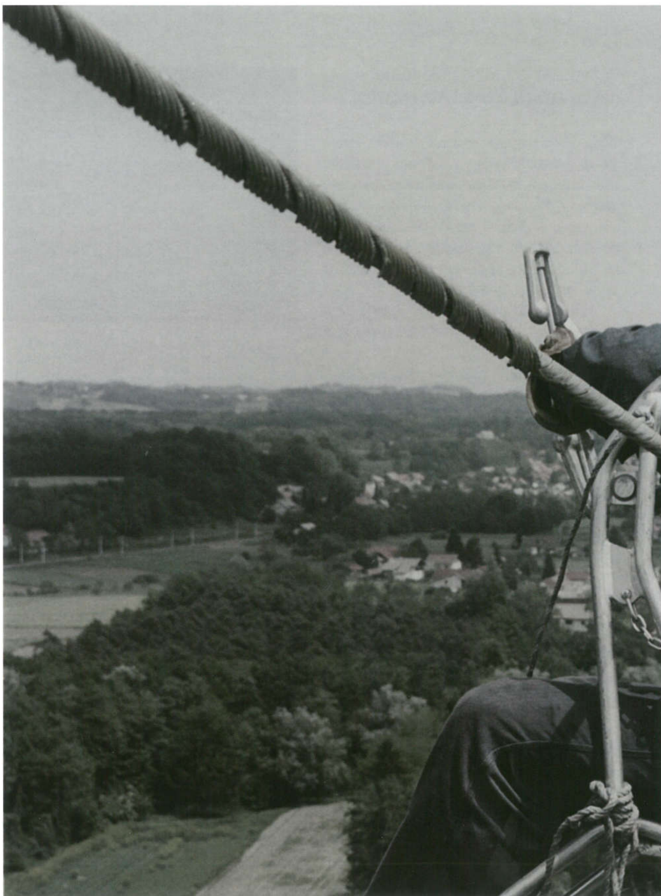
Montaža OPGW-a na dalekovodnom stupu 400 kV
