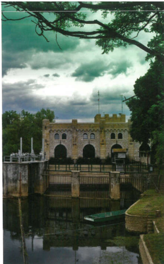
Hidroelektrana Ozalj I
