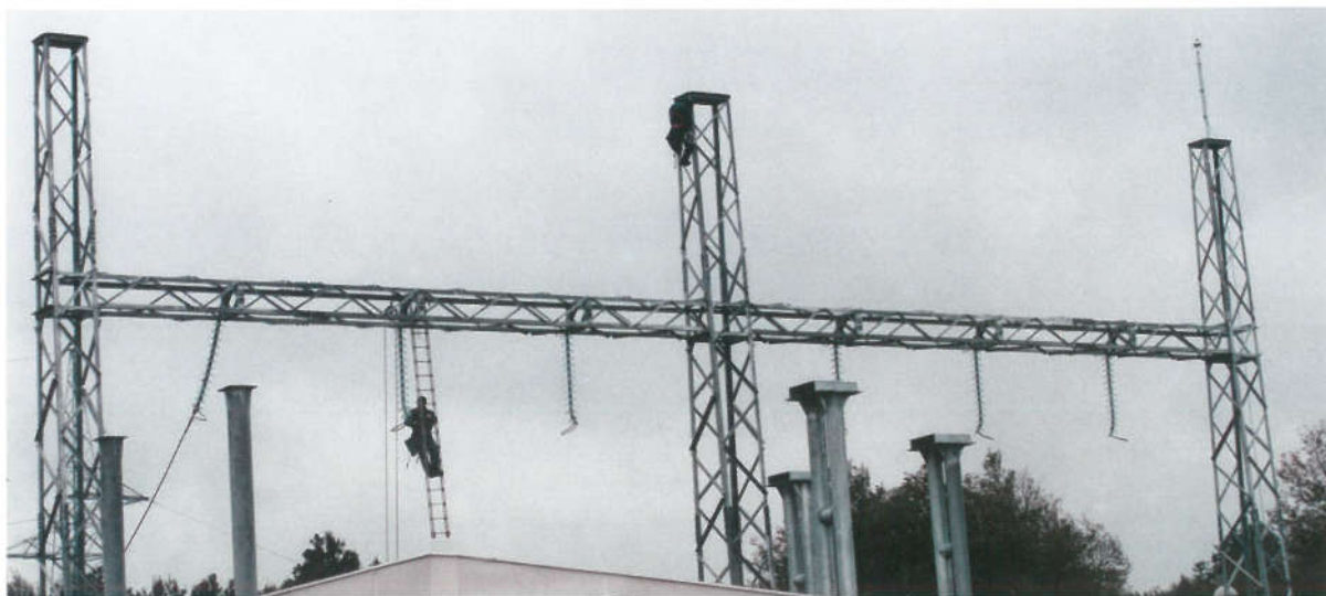
Montaža izolatora na portalu transformatorske stanice 400/220/110 kV Žerjavinec
