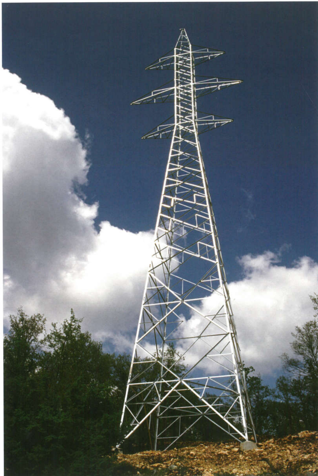
Dalekovod 220 kV Posušje-Rama u izgradnji
