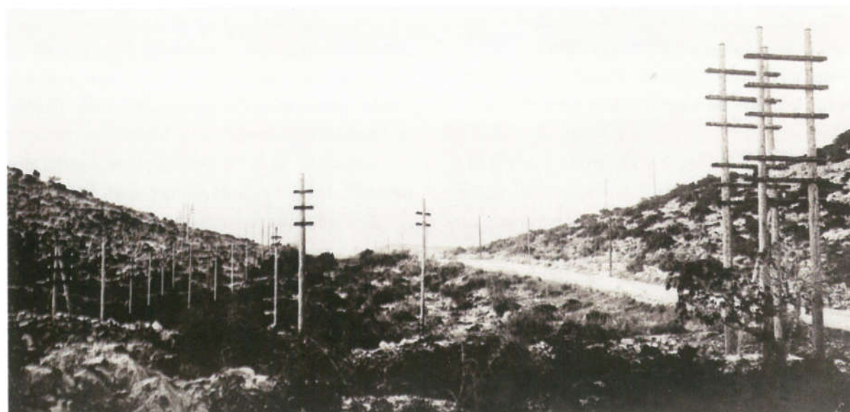
Izgradnja drvenih dalekovodnih stupova na trasi dugoj 11 km od Hidroelektrane Krka do grada Šibenika
