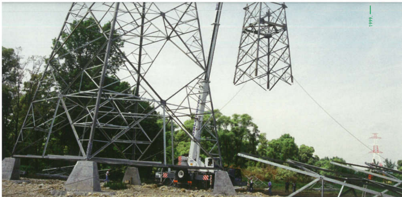
Dizanje stupa - povezivanje vodova od transformatorske stanice 400/110 kV Tumbri prema lokaciji buduće transformatorske stanice 400/220/110 kV Žerjavinec
