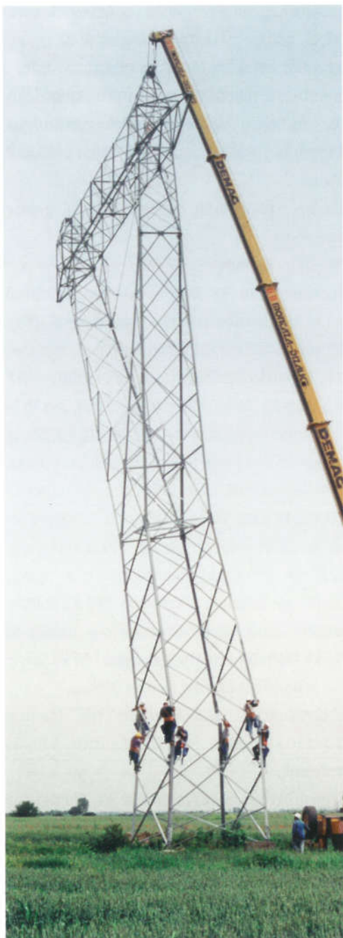
... dizanje novog stupa dalekovoda 400 kV Ernestinovo-Mladost
