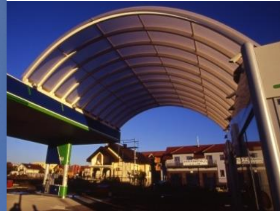
Antenski stupovi i metalne konstrukcije
