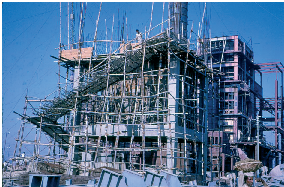
Sl. 22.: Dio termoelektrane u Kampuru tijekom izgradnje opasan bambusovom skelom
