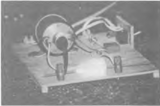
Abb. 34: Versuchsaufbau des Hochspannungsgenerators im Netzbetrieb mit Triac
