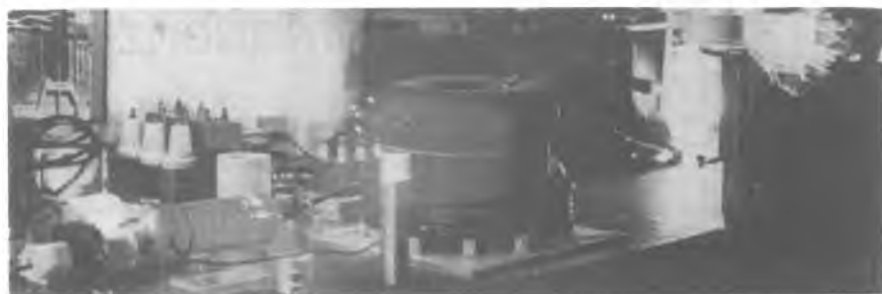
Abb. 91b: Tesla-Generator mit Wasserstoff-Thyratron im Betrieb
