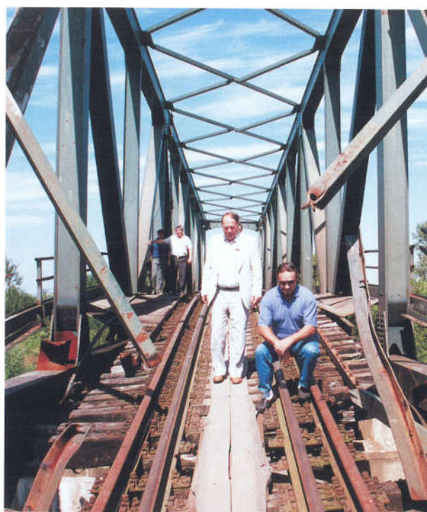
Članovi koprivničke Elektre na mostu preko Save kod Jasenovca
