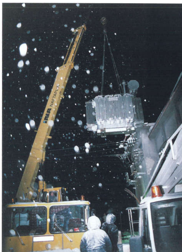
Zimska zamjena transformatora u TS 35/10 kV Koprivnica II.
