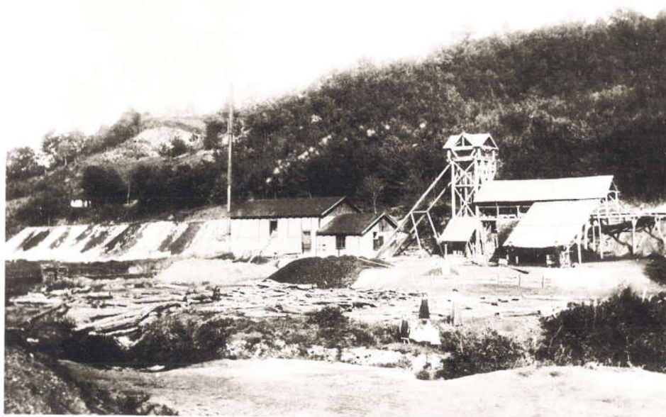
Rudnik smeđeg ugljena u Žlebicu kraj Koprivnice na prijelazu iz 19. u 20. stoljeće držala je jedna francuska kompanija. Veći bilogorski, ali i kalnički ugljenokopi imali su vlastite generatore za pridobivanje električne energije
