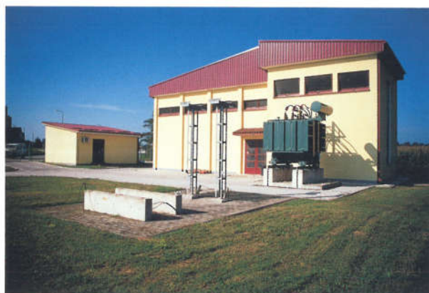
Današnji izgled modernizirane TS 35/10 kV Koprivnica II.
