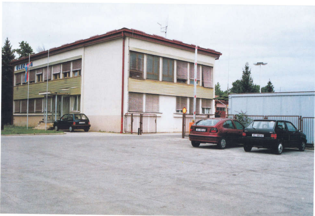
Dispečersko-poslovna zgrada Elektre u Đurđevcu
