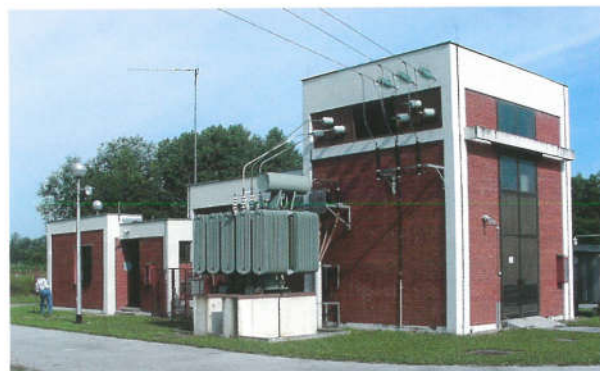
Pogled na obnovljenu 35/10 kV trafostanicu kod Legrada
