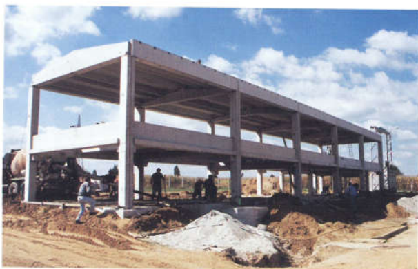
Gradnja TS 110/35/10 kV u Selniku kraj Ludbrega 1998. godine
