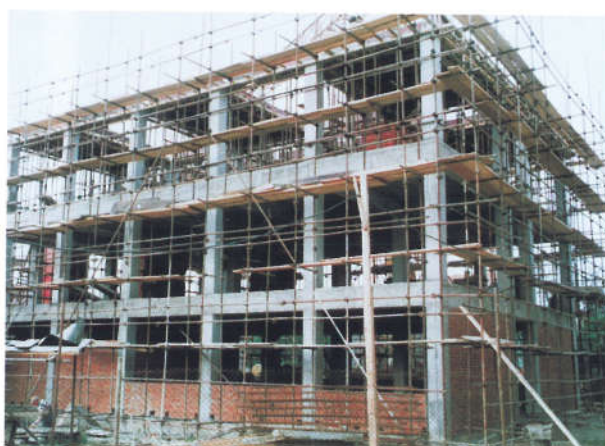
Novi dispečerski centar Elektre u Koprivnici građen je 1987. i 1988. godine
