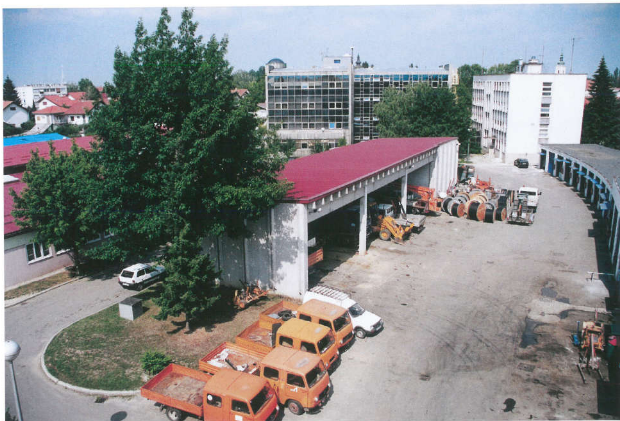
Pogled na radionice te dvorište središnje poslovne i dispečerske zgrade Elektro u Koprivnici
