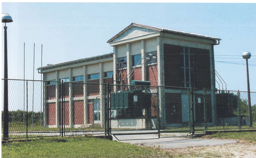
Pogled na novu TS 35/10 kV u industrijskoj zoni Danica u Koprivnici - otvorena 1981. godine
