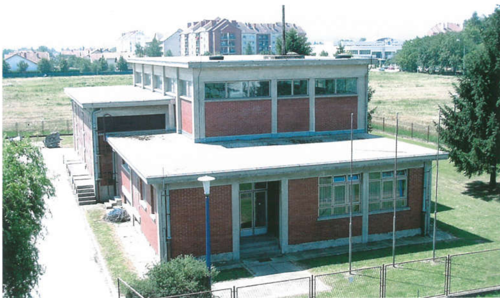
Suvremeno uređena zgrada TS 35/10 kV Koprivnica III.
