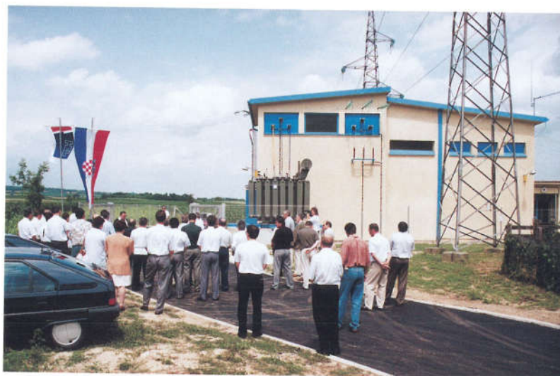
Obnovljeno zdanje TS 35/10 kV u Novigradu Podravskom
