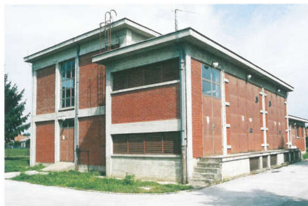
Pogled na TS 30/10 kV Koprivnica III.
