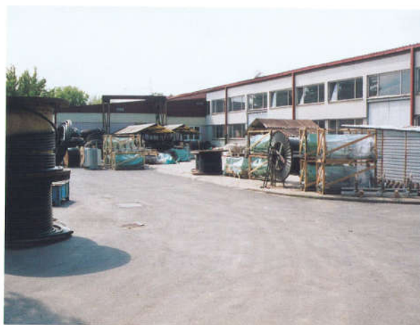
Dio radionica i skladišta u koprivničkoj Elektri
