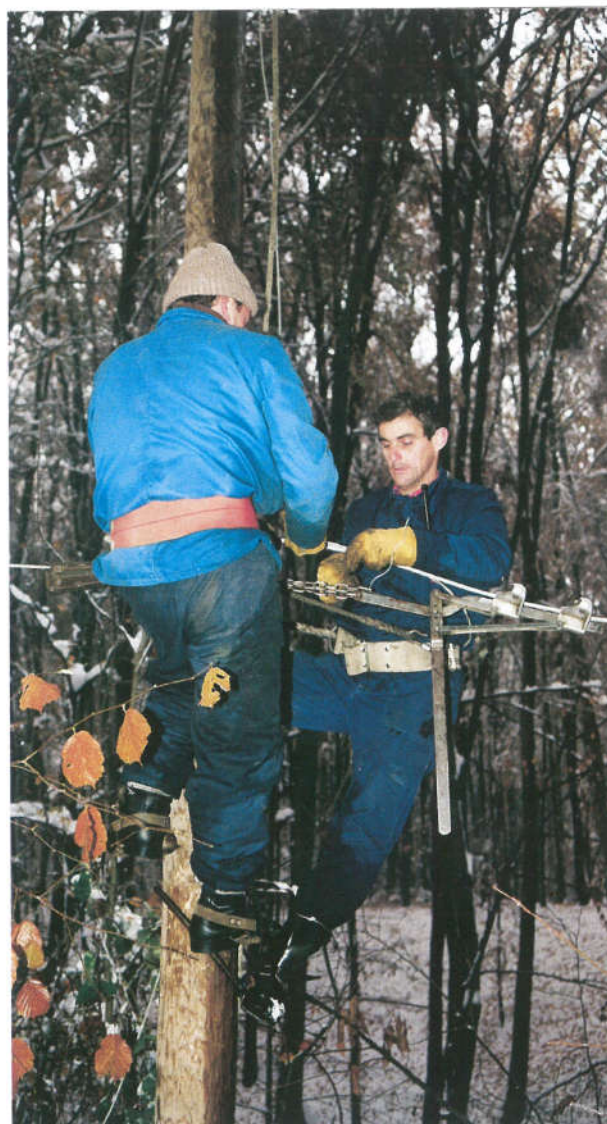
Popravlak električnih vodova pokidanih od snijega i leda u šumi kod Paunovca
