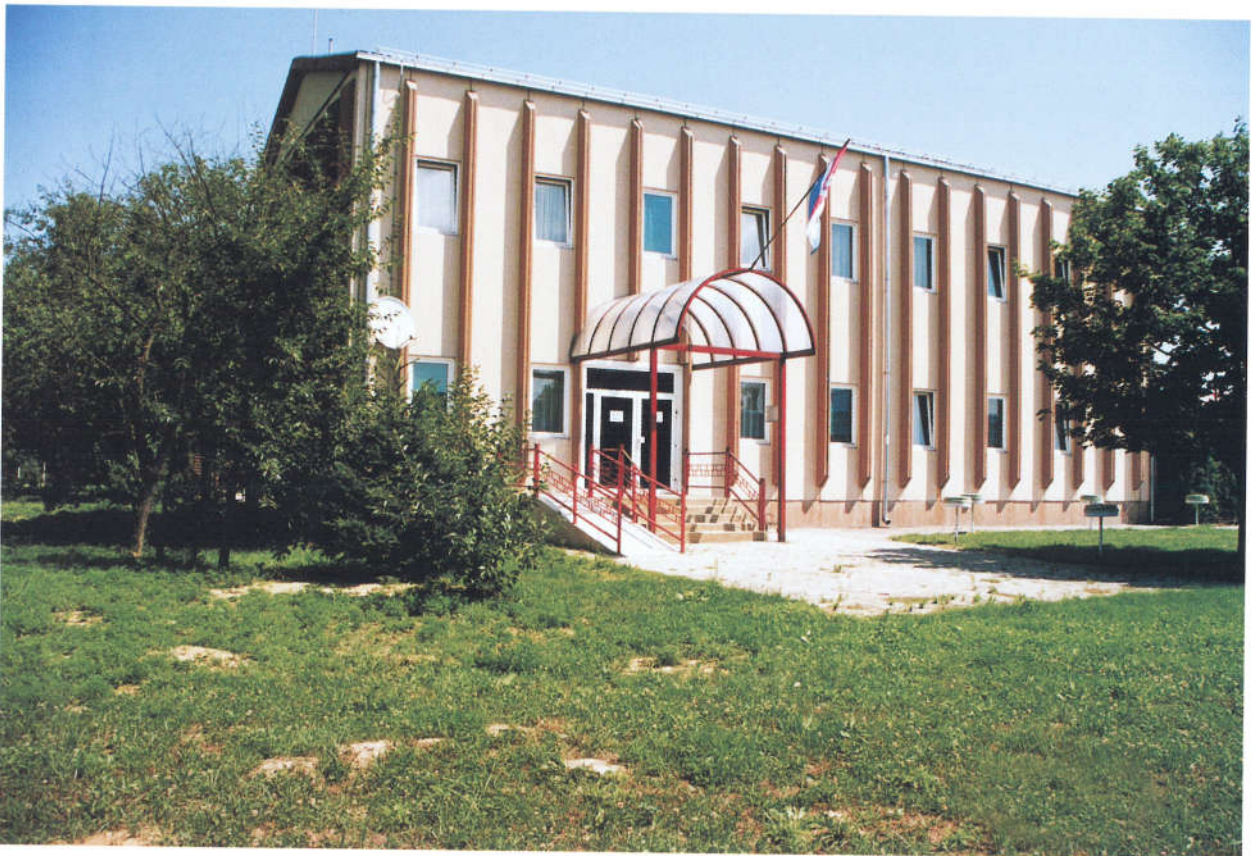
Dispečersko-poslovna zgrada Elektre u Ludbregu
