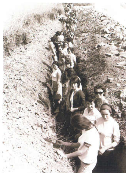
Srednjoškolci pomažu kopanje kanala za polaganje električnoga kabela u Koprivnici 1971. godine
