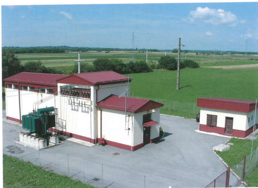
Pogled na TS 35/10 kV u Đurđevcu
