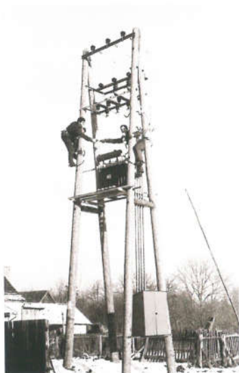
Montaža 10/0,4 kV trafostanice u Donjem Banovcu u Koprivnici oko 1963. godine
