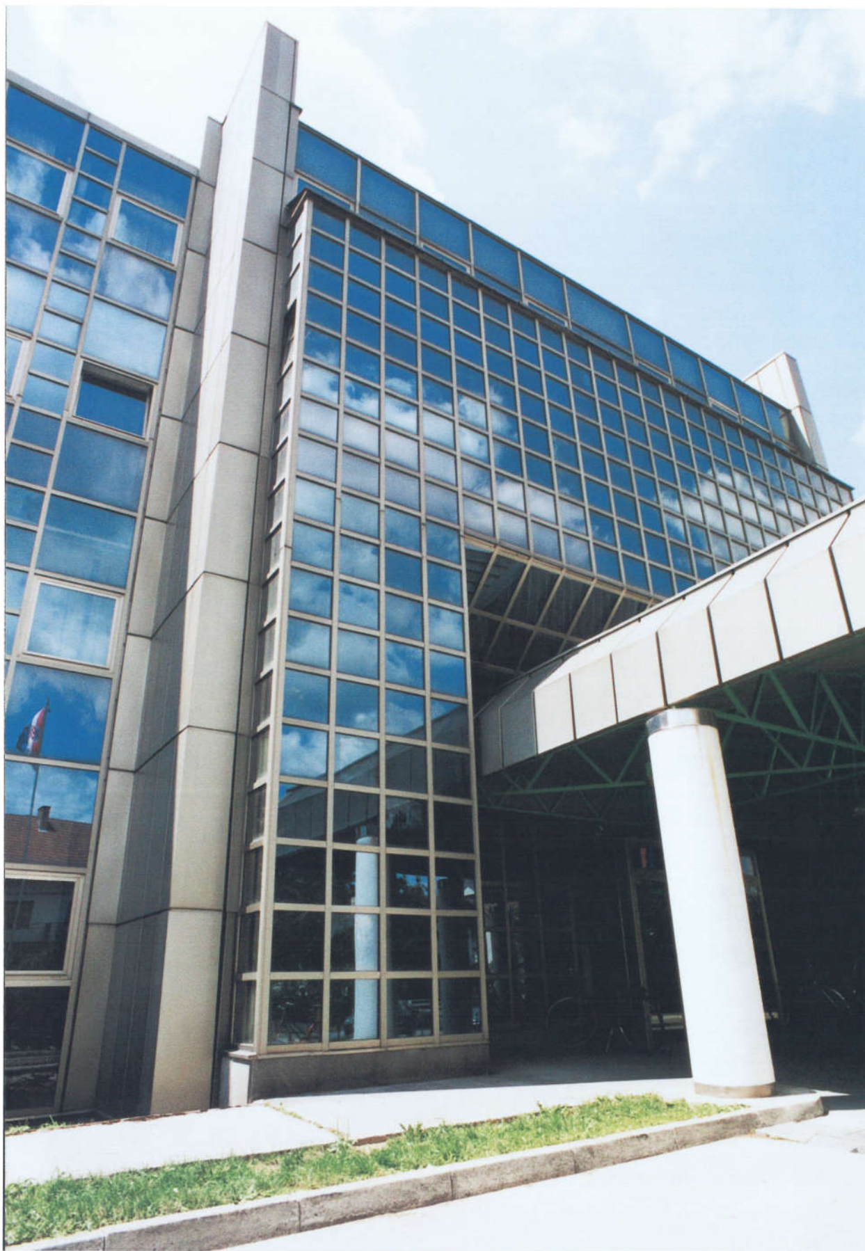
Atraktivno pročelje dispečersko-poslovne zgrade Elektre u Koprivnici
