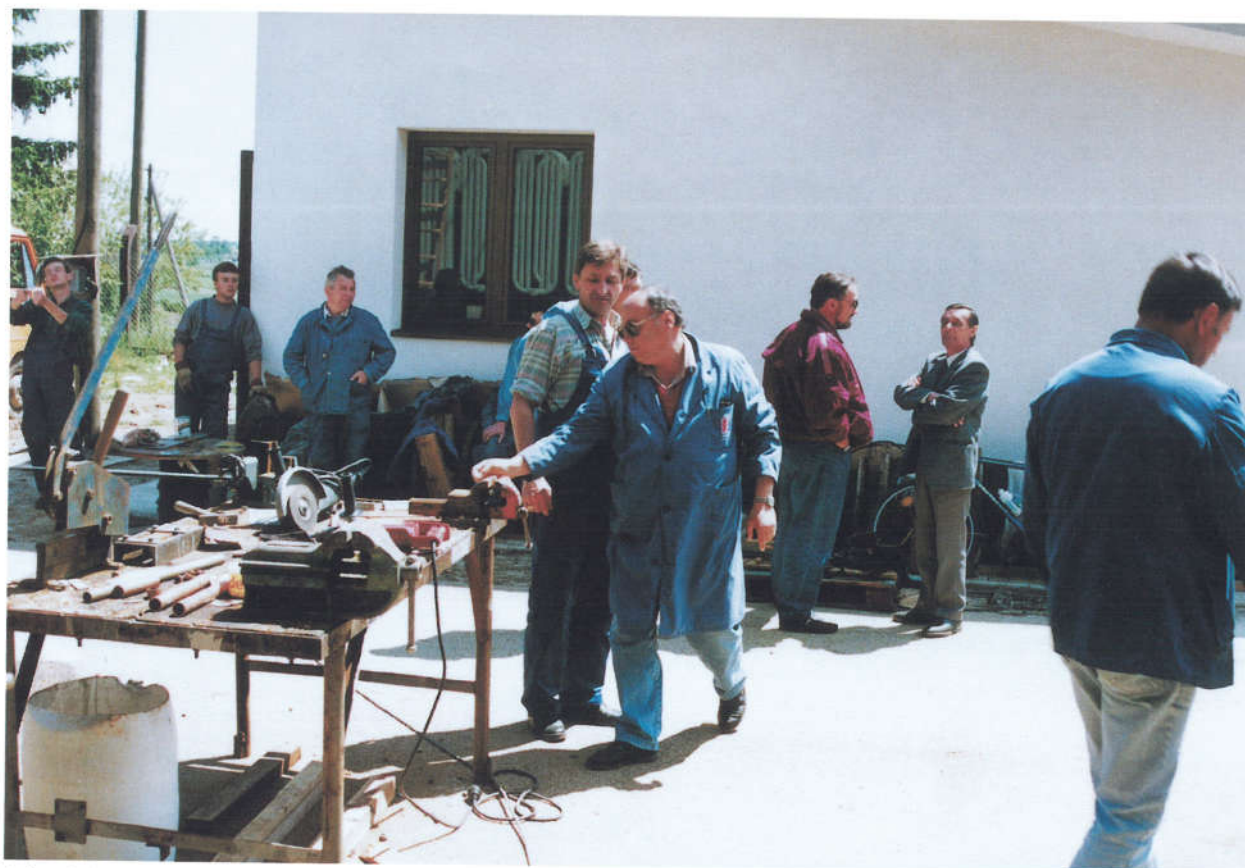
Prizor iz jedne Elektrine radionice na otvorenom - rekonstrukcija TS 35/10 KV Pitomača
