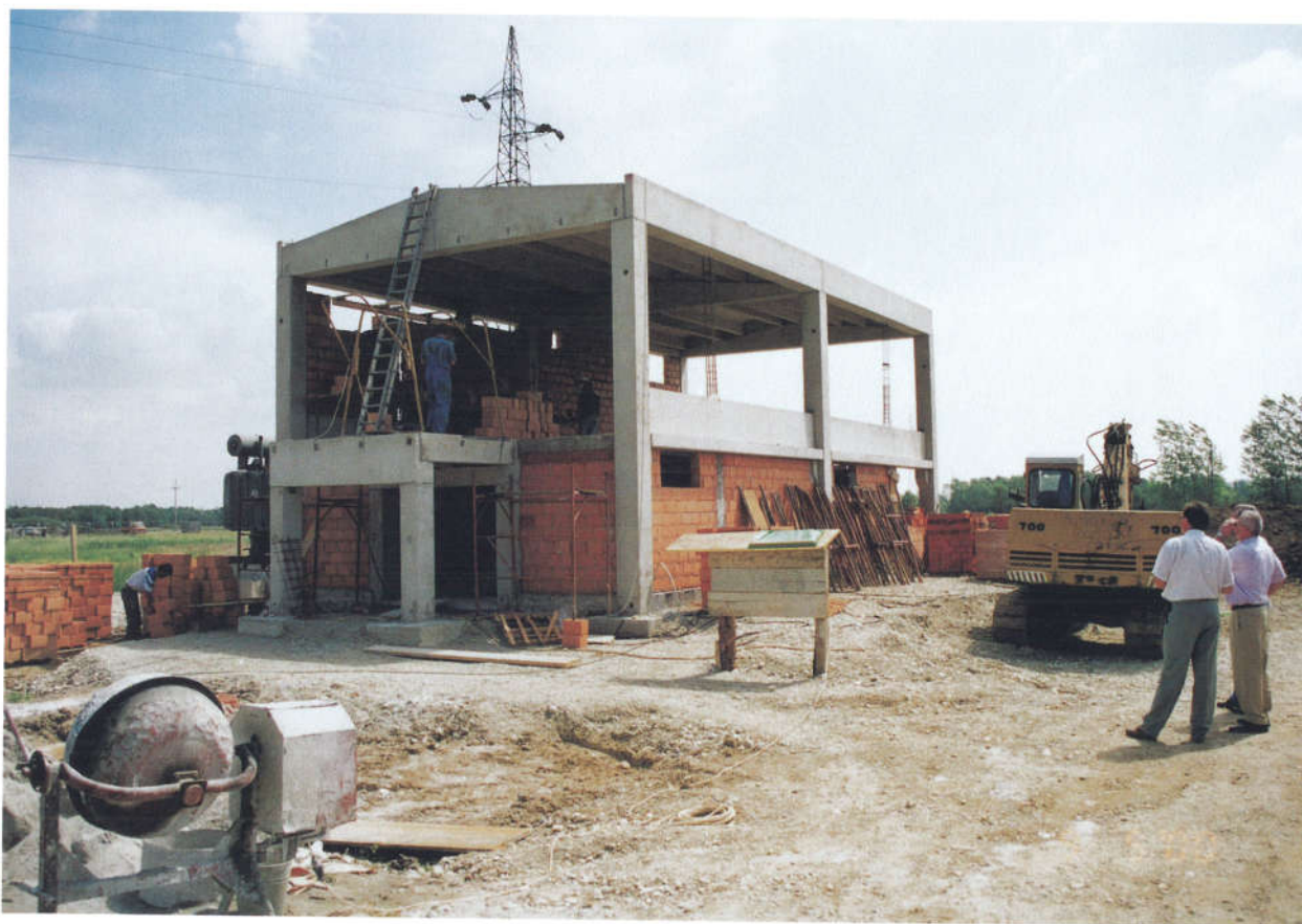
Gradnja TS 35/10 kV u Rasinji 2000. godine
