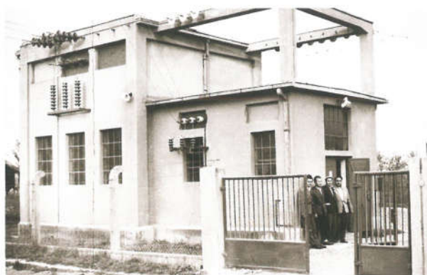
Trafostanica 35/10 kV u Đurđevcu snimljena 1957. godine
