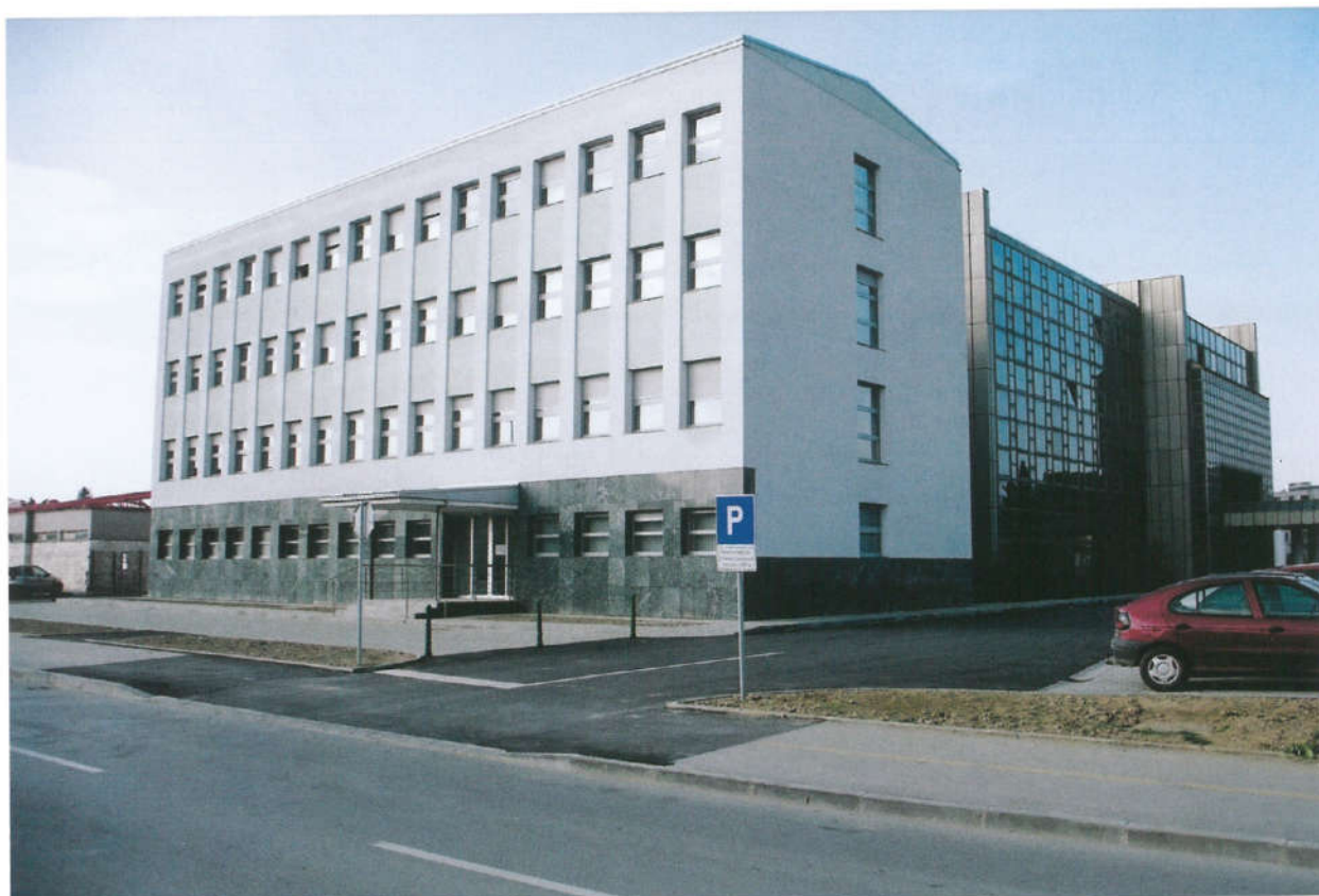
Obnovljena stara dispečersko-poslovna zgrada Elektro u Koprivnici
