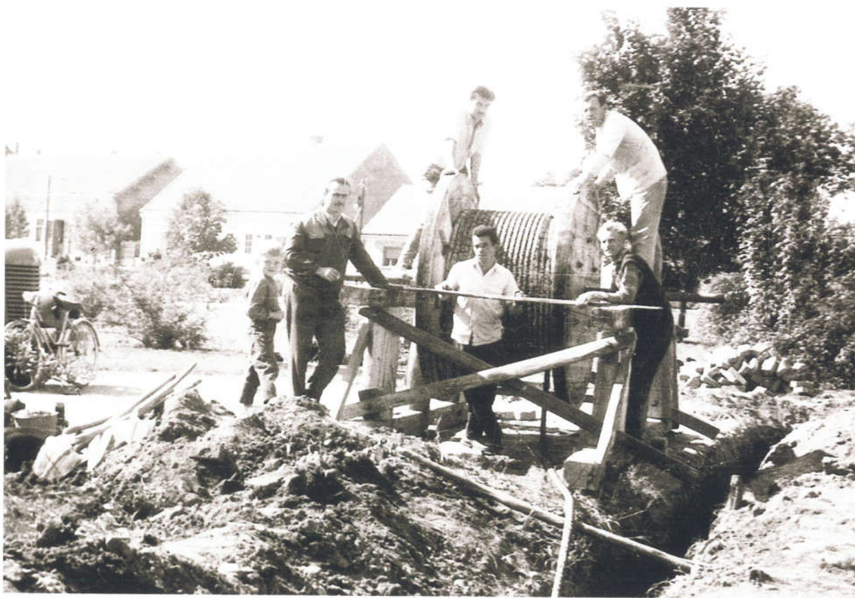
Polaganje kabela u središtu Koprivnice 1960. godine
