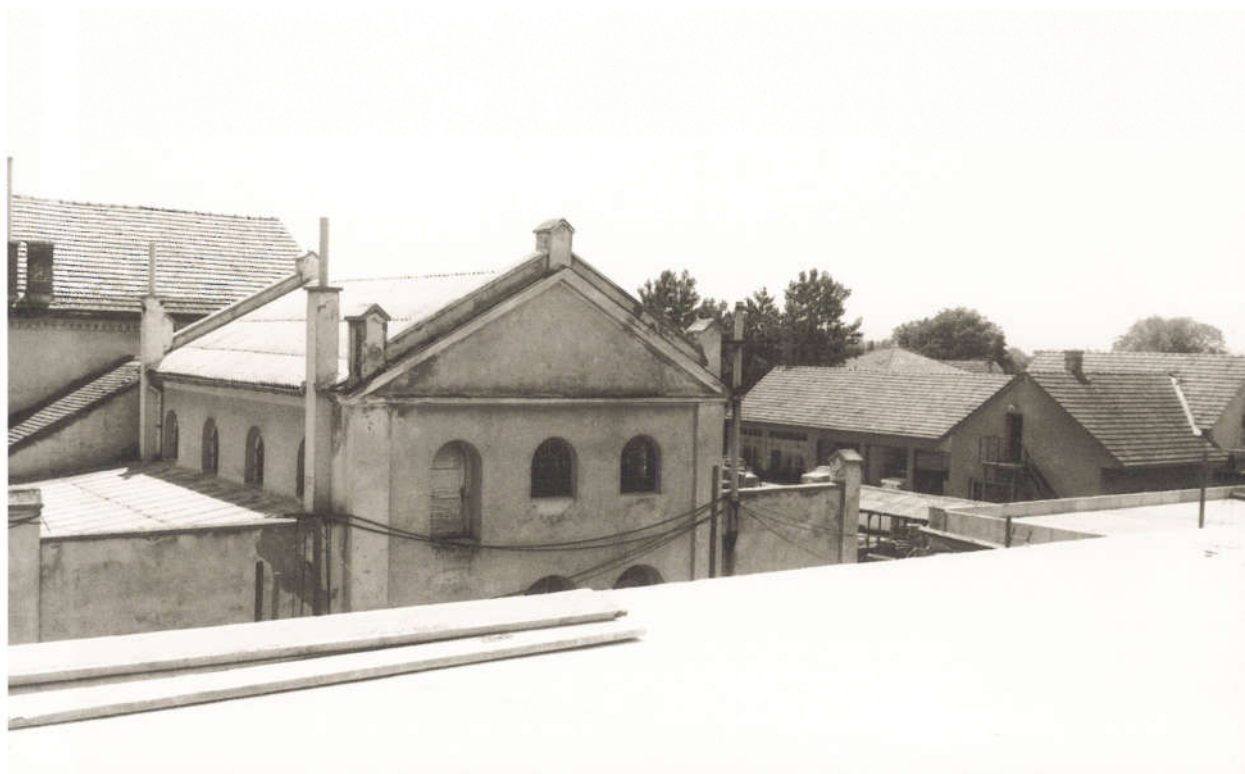
Ostaci zgrada nekadašnje munjare snimljeni u sklopu koprivničke Elektre sedamdesetih godina 20. stoljeća
