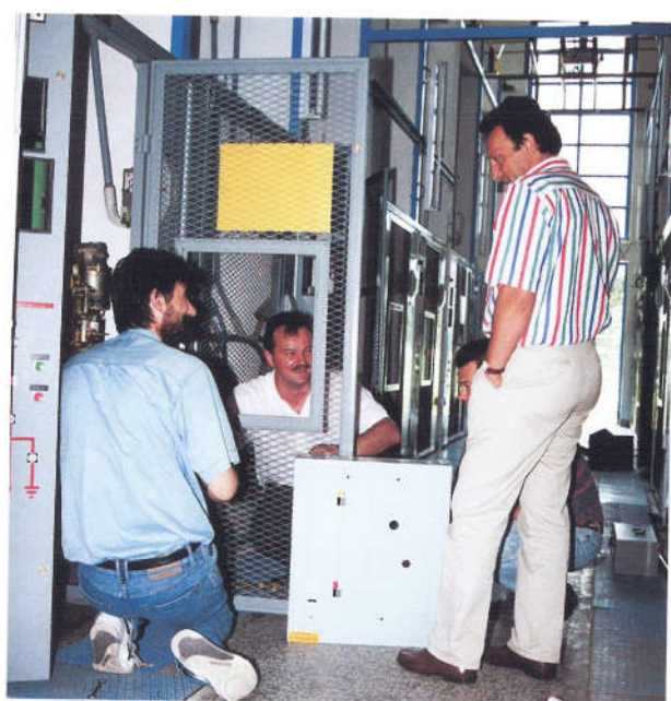
Montaža i kontrola unutrašnjeg postrojenja u TS 35/10 kV u Novigradu Podravskom
