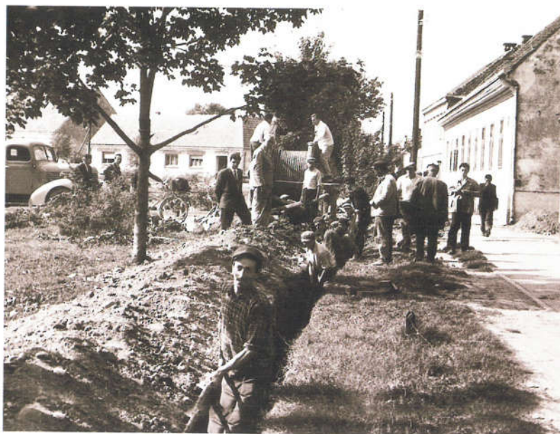
Polaganje jednog od prvih električnih kabela u središtu Koprivnice 1959. godine
