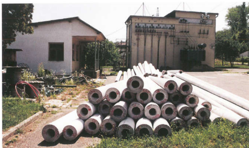
Dvorište i stara TS 35/10 kV u Ludbregu prvi je put otvorena još 1948. godine i spojena 35 kV dalekovodom na drvenim stupovima s trafostanicom u Nedeljancu
