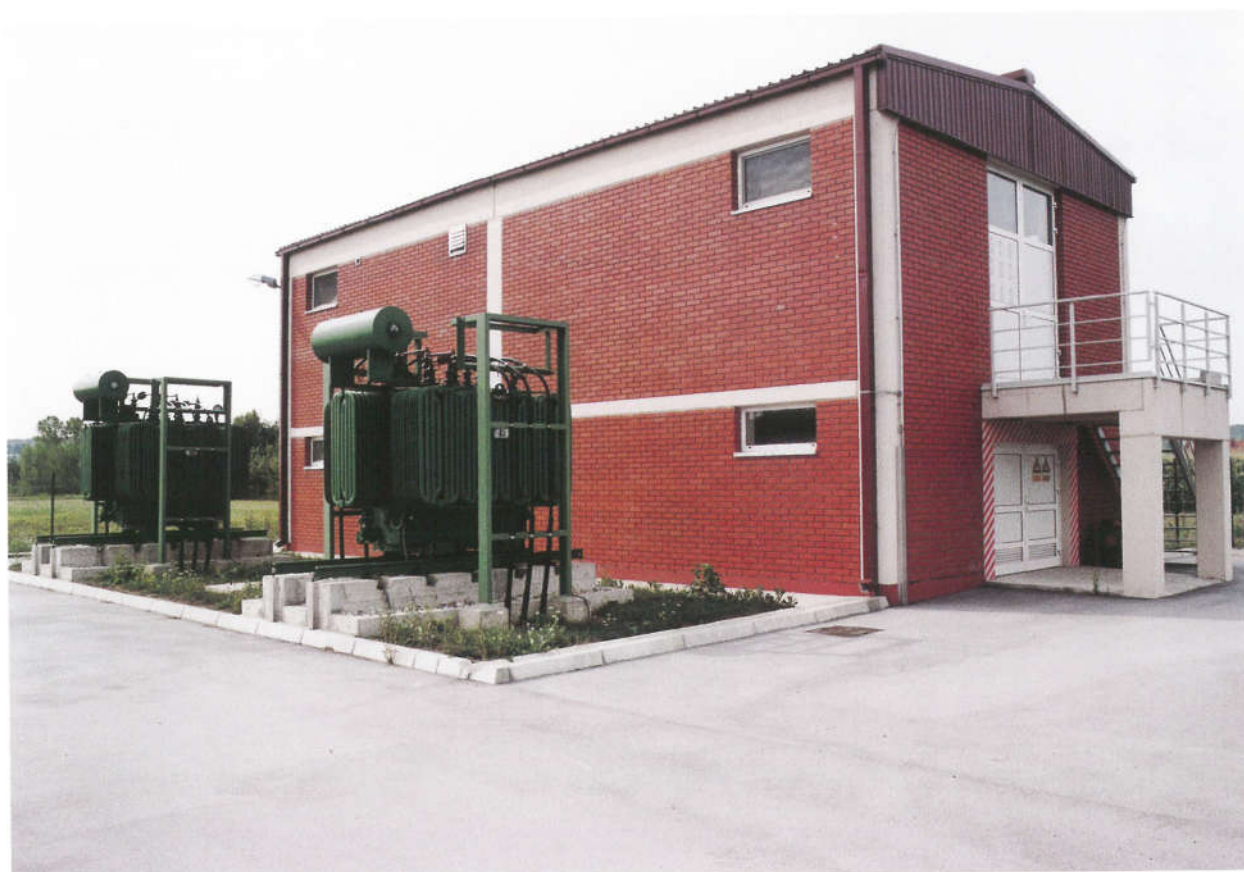
Suvremeno zdanje TS 35/10 kV u Rasinji
