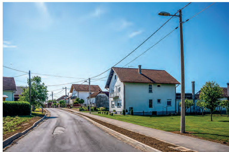
Niskonaponska mreža u Koprivničkom Ivancu
