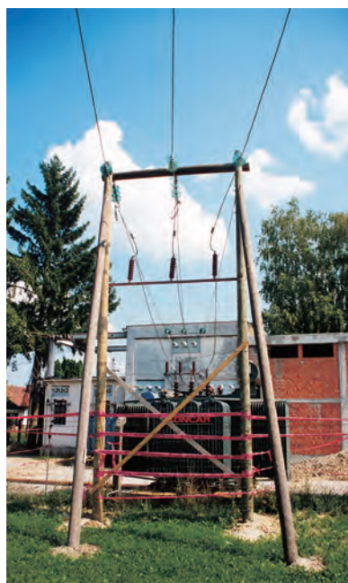
Dalekovod i transformatorsko postrojenje u TS 35/10 kV u Đurđevcu - pomoćno postrojenje tijekom rekonstrukcije
