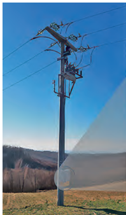
Siemens Recloser (prekidač sa zaštitnim uređajem)
