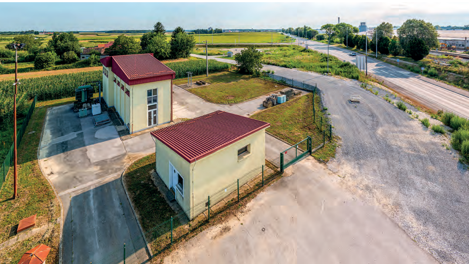
Današnji izgled modernizirane TS 35/10 kV Koprivnica II.
