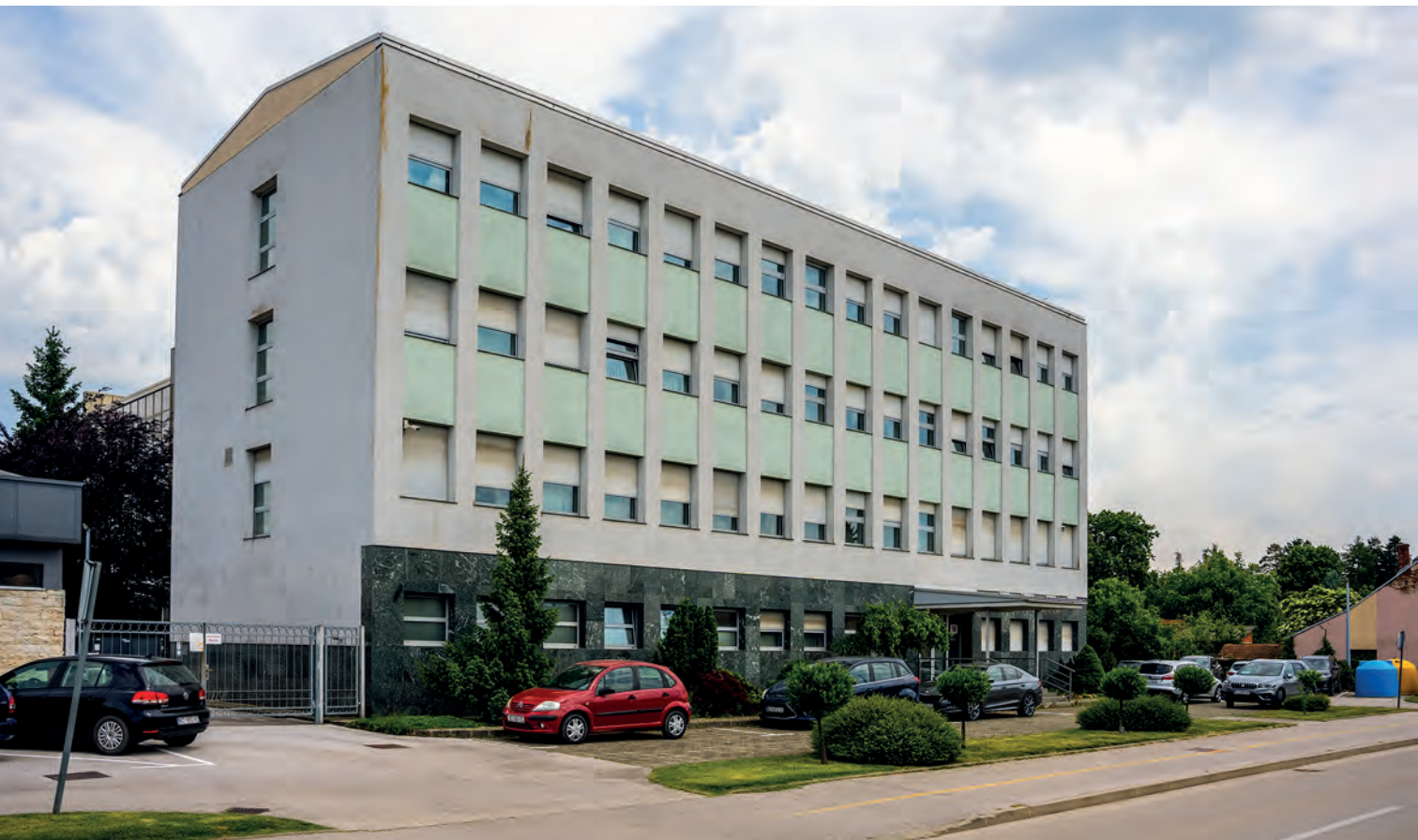
Obnovljena stara dispečersko-poslovna zgrada Elektre u Koprivnici
