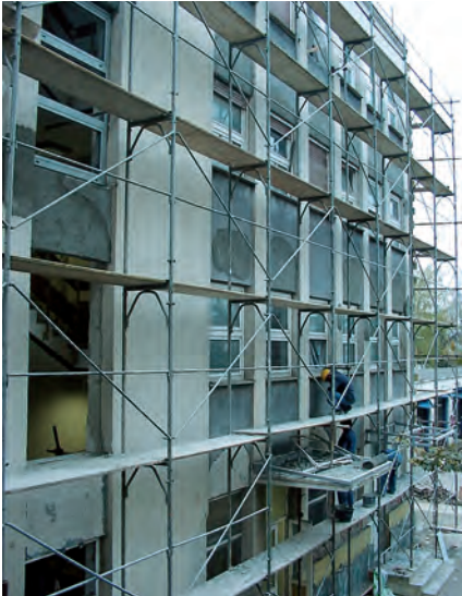
Adaptacija starog dispečerskog centra, sa suvremenom termoizolacijom, izvedena je tijekom 2005. godine
