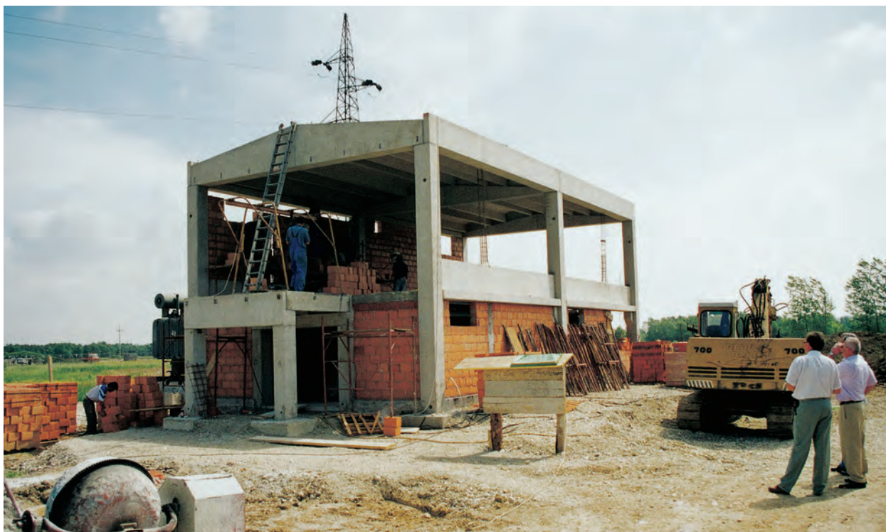
Gradnja TS 35/10 kV Rasinja 2000. godine
