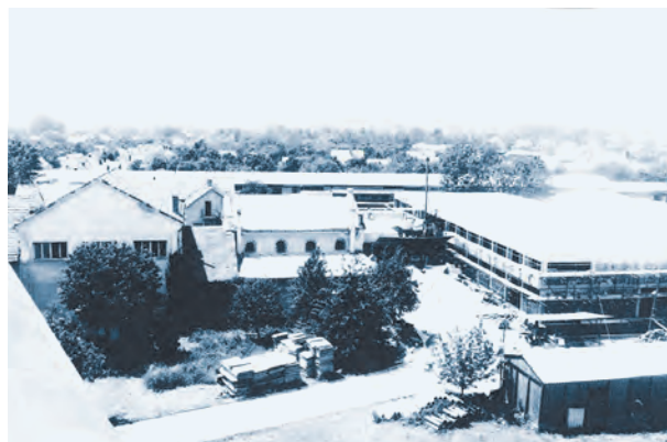
Radionice koprivničke Elektre i početak gradnje dispečersko-poslovne zgrade 1968. godine (desno)
