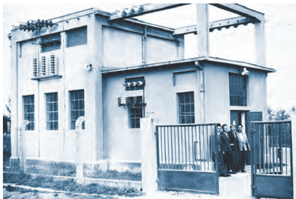
Trafostanica 35/10 kV u Đurđevcu snimljena 1957. godine
