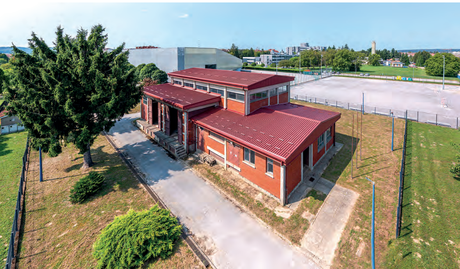
Suvremeno uređena zgrada TS 35/10(20) kV Koprivnica III.
