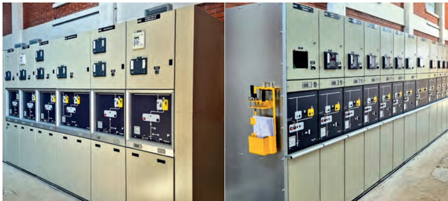
10(20) i 35 kV postrojenje u TS 35/10(20) kV Koprivnica III.
