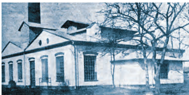
U ovoj zgradi počela je rad prva gradska munjara u Varaždinu 1895. godine
