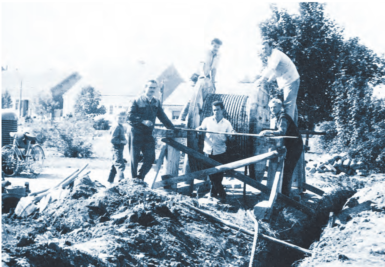
Polaganje kabela u središtu Koprivnice 1960. godine
