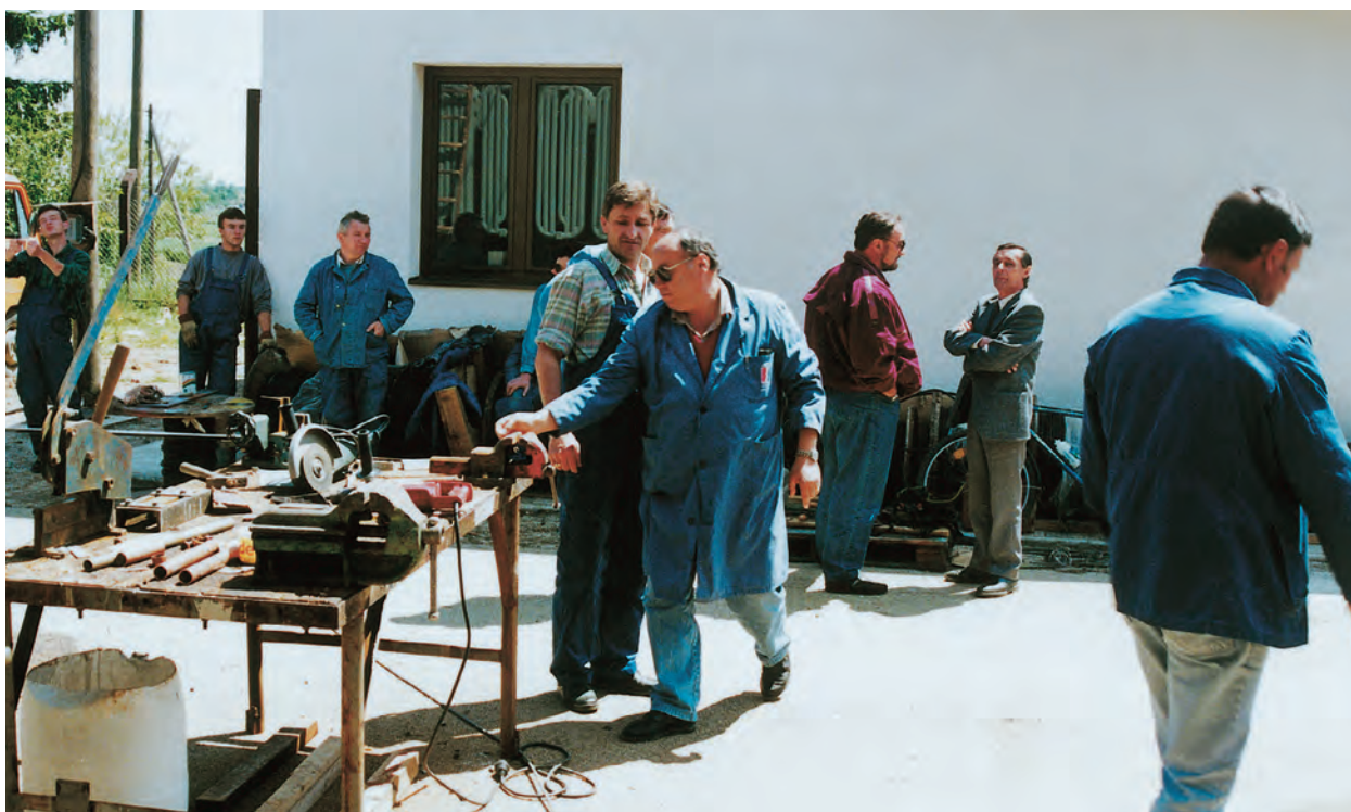
Prizor iz jedne Elektrine radionice na otvorenom - rekonstrukcija TS 35/10 KV Pitomača
