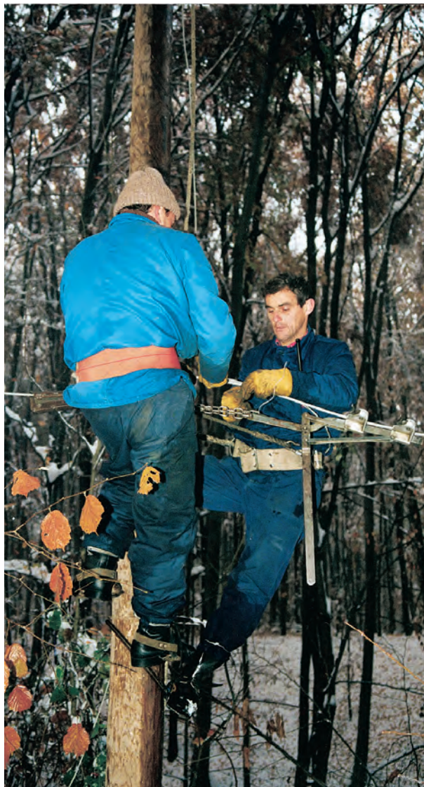
Popravak električnih vodova pokidanih od snijega i leda u šumi kod Paunovca
