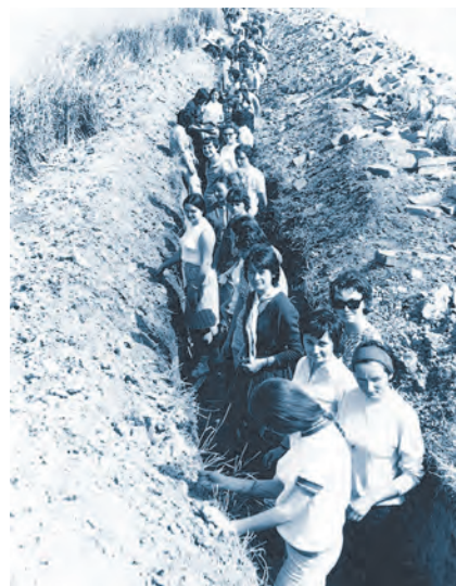
Srednjoškolci pomažu kopanje kanala za polaganje električnog kabela u Koprivnici 1971. godine
