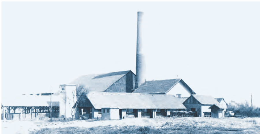
Trafostanica 10/0,4 kV kod koprivničke ciglane
