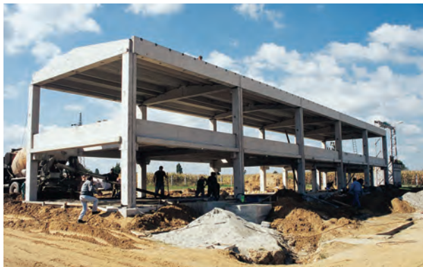
Gradnja TS 110/35/10(20) kV Selnik kraj Ludbrega 1998. godine
