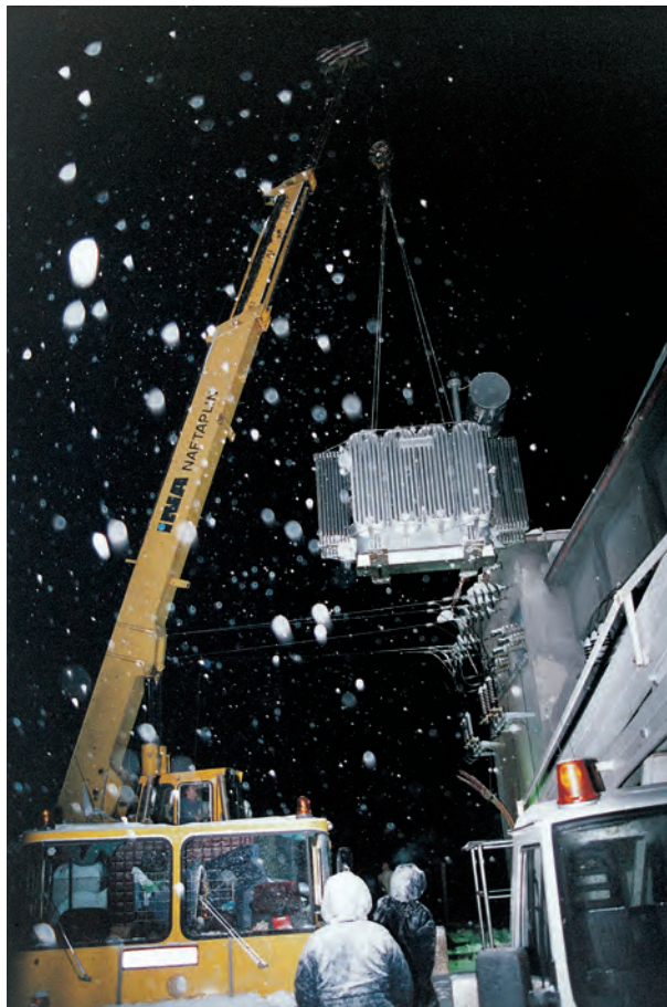
Zimska zamjena transformatora u TS 35/10 kV Koprivnica II.
