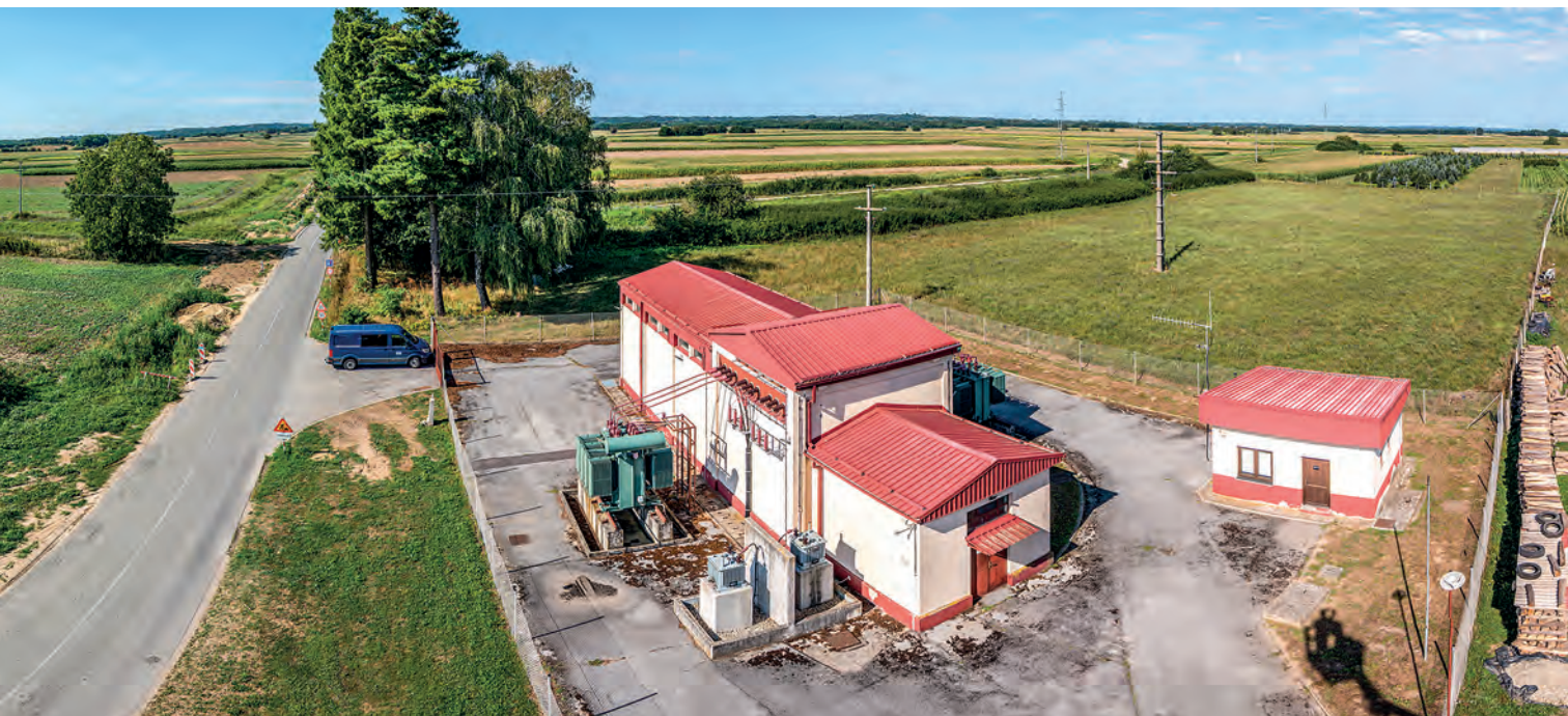
Pogled na TS 35/10 kV u Đurđevcu
