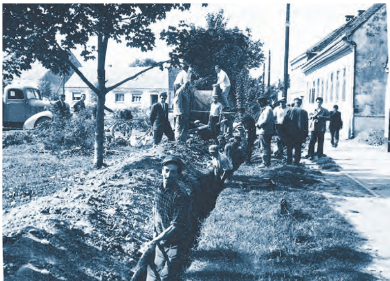
Polaganje jednog od prvih električnih kabela u središtu Koprivnice 1959. godine
