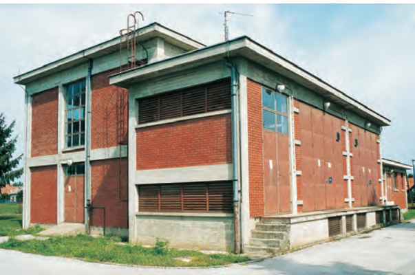
Pogled na TS 35/10(20) kV Koprivnica III.
