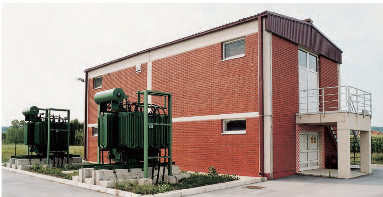
Suvremeno zdanje TS 35/10 kV Rasinja
