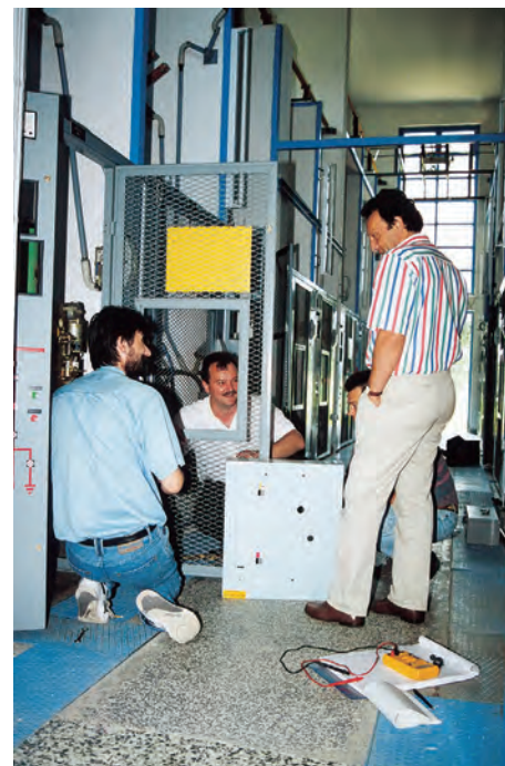
Montaža i kontrola unutrašnjeg postrojenja u TS 35/10 kV Novigrad Podravski
