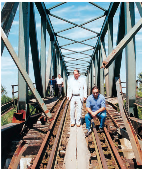
Članovi koprivničke Elektre na mostu preko Save kod Jasenovca
