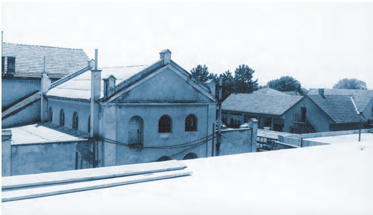
Ostaci zgrada nekadašnje munjare snimljeni u sklopu koprivničke Elektre sedamdesetih godina 20. stoljeća
