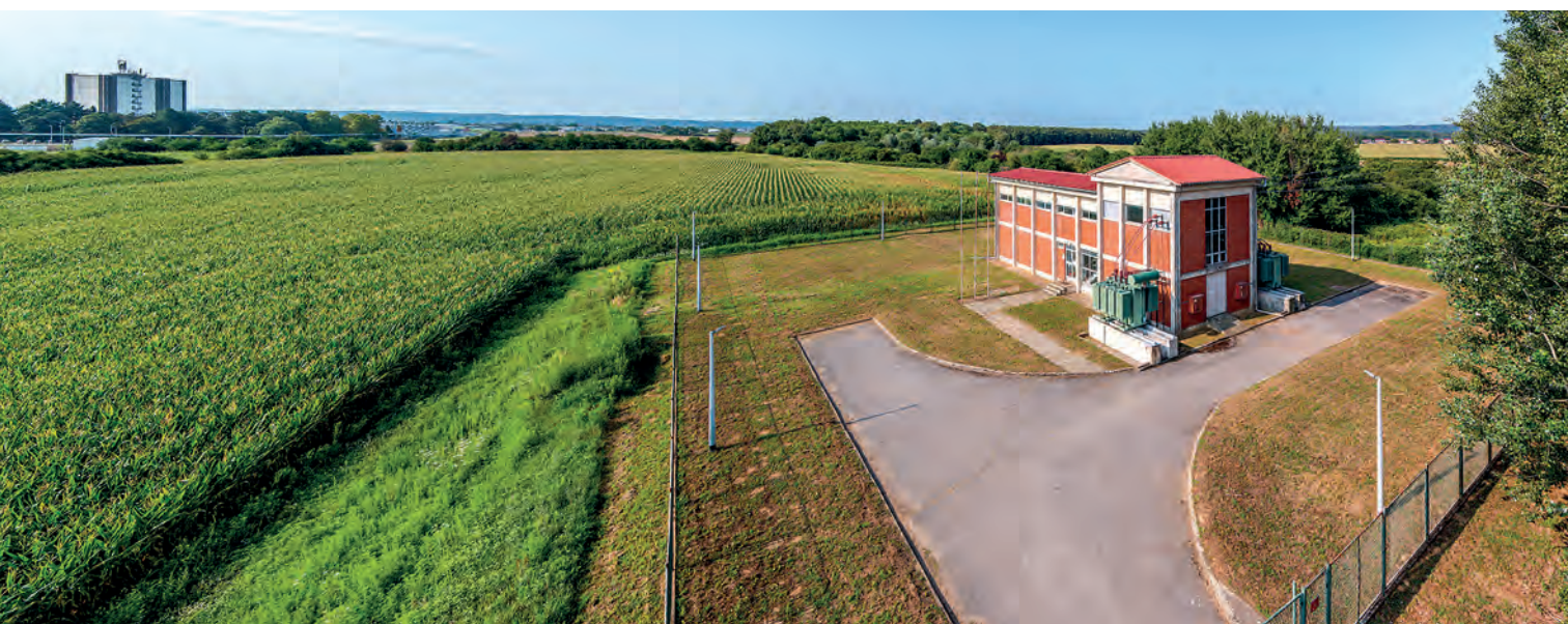
Pogled na TS 35/10 kV u industrijskoj zoni Danica u Koprivnici - otvorena 1981. godine
