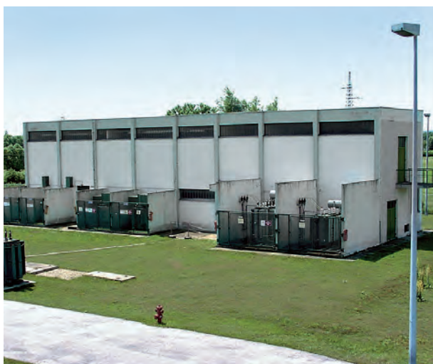
TS 35/10 kV za potrebe naftovoda JANAFT sagrađena je 1980. godine
