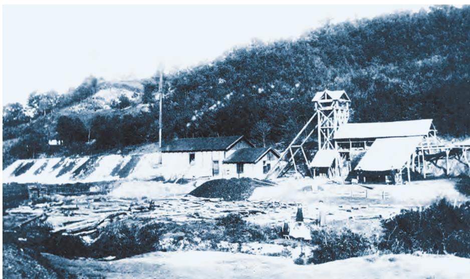
Rudnik smeđeg ugljena u Žlebicu kraj Koprivnice na prijelazu iz 19. u 20. stoljeće držala je jedna francuska kompanija. Veći bilogorski, ali i kalnički ugljenokopi imali su vlastite generatore za pridobivanje električne energije
