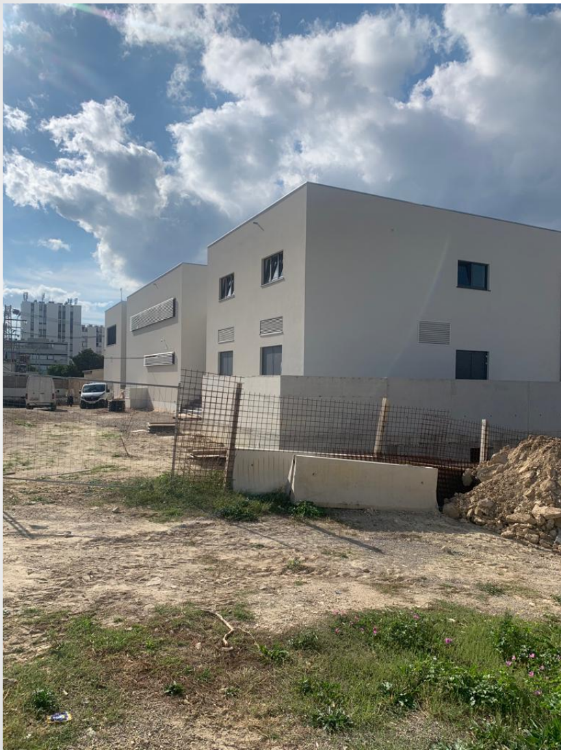
TS 110/20(10) kV Sućidar
