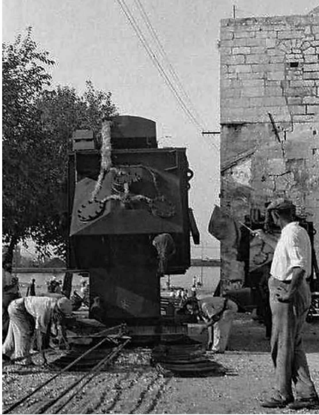
Prijevoz transformatora iz gradske luke do TS Dujmovača gradskim ulicama u lipnju 1945. godine
