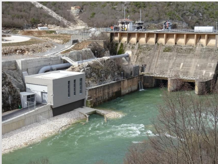
mHE Prančevići 1,6 MVA
