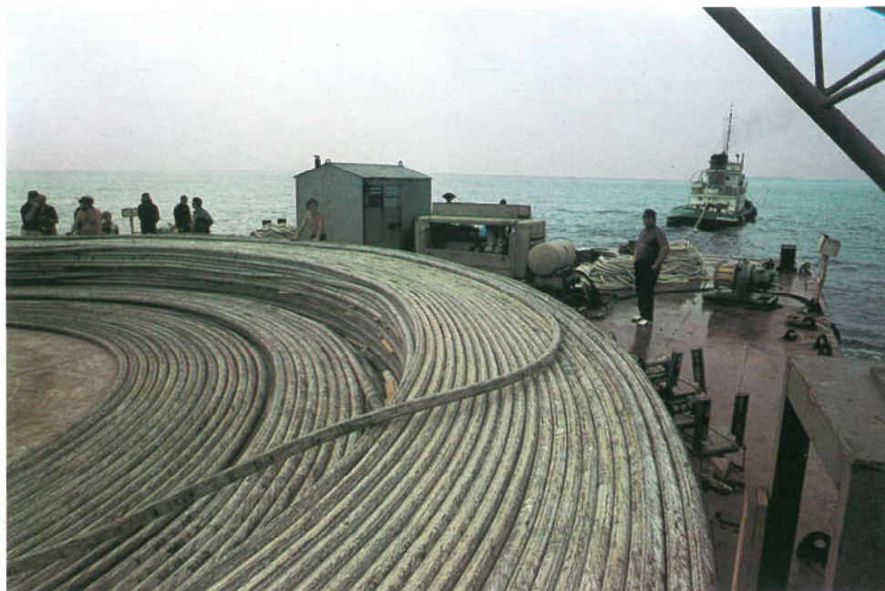
Polaganje podmorskog kabela pomoću maone koju vuče remarker
