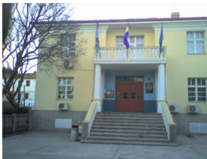
Ilustracija 61 – Upravna zgrada Općine Punat
