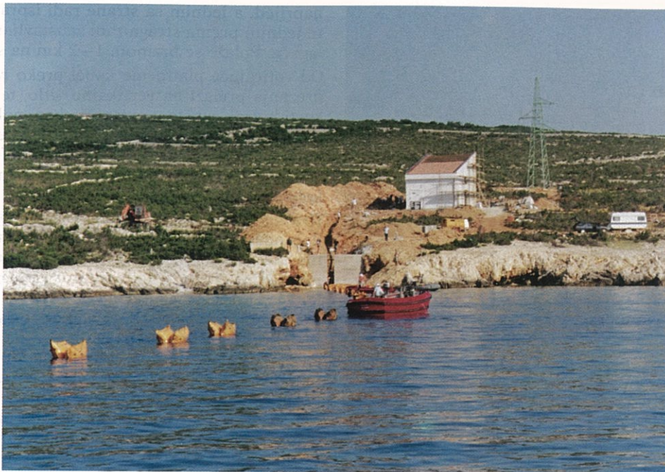
Slika 5. Izvlačenje kabela na obalu
