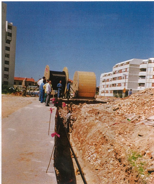
Slika 1. Detalj polaganja kabela
