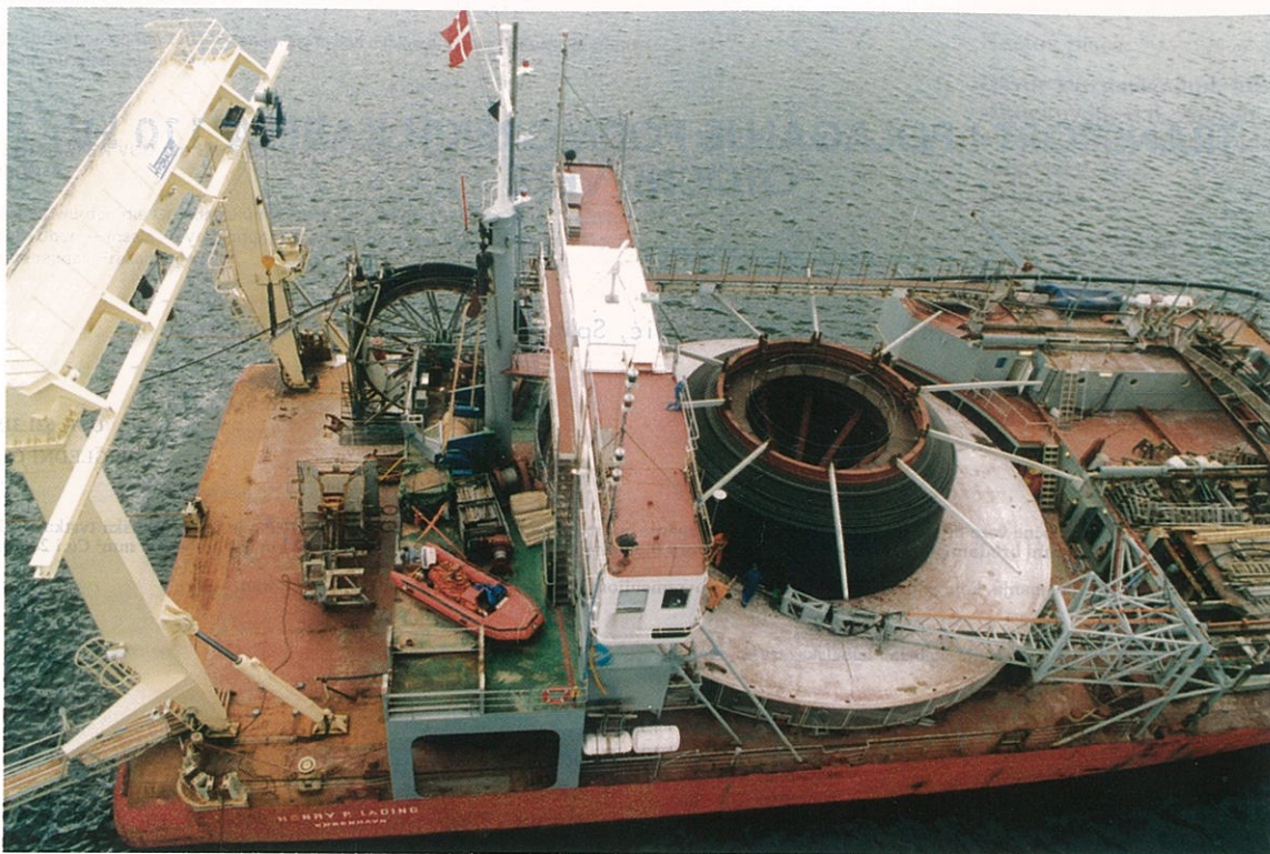
Slika 1. Utovar kabela na brod polagač
