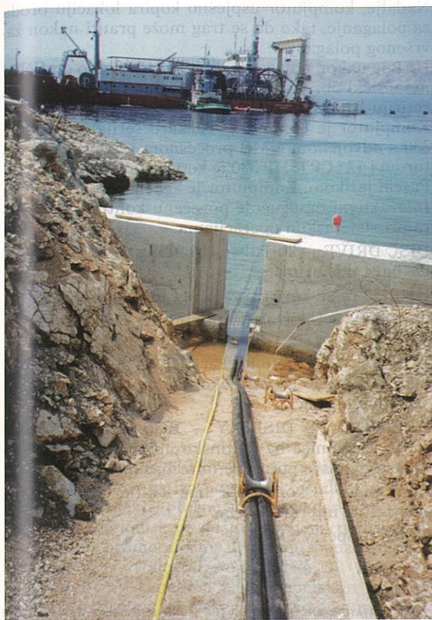
Slika 7. Izvlačenje kabela
