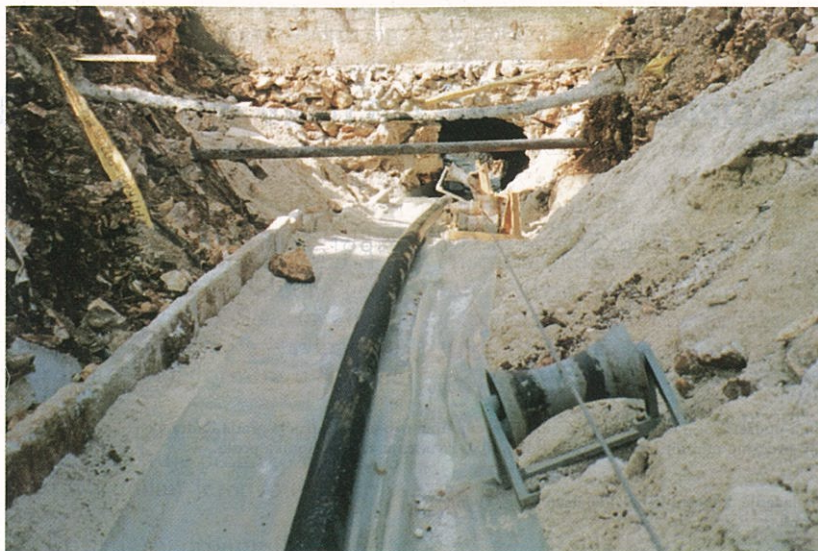
Slika 2. Detalj polaganja kabela
