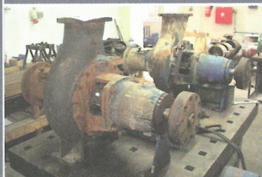
Rekonstrukcija procesnih centrifugalnih pumpi
