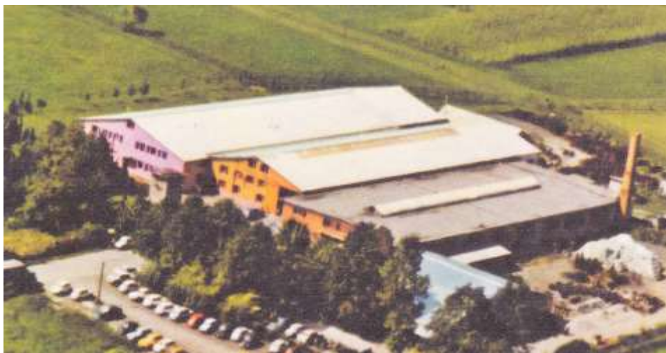
Sl. 3.: Tvoronica 1972. godine: desna hala izgrađena je 1960. godine, lijeva hala izgrađena je 1970. godine vlastitim sredstvima, pročelje zgrade uređeno je kao kancelarijski prostor veličine oko 200 četvornih metara, a iza je proizvodnja. Srednja hala izgrađena je 1971. godine kao skladište repromaterijala i gotovih proizvoda [1].
