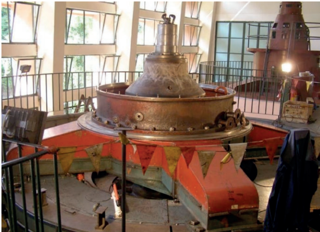
Stator... rotor... gornji nosač sa sklopom GKL generatora C
