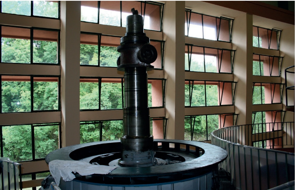
Generator je demontiran i rotor je izvađen iz statora
