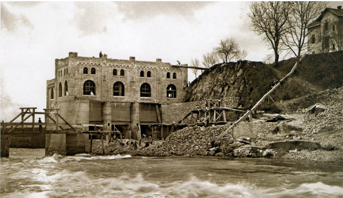
Munjara grada Karlovca, HE Ozalj, tijekom izgradnje: električnu energiju za javnu potrošnju započela je proizvoditi 18. kolovoza 1908.
