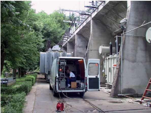
Zamjena transformatora
