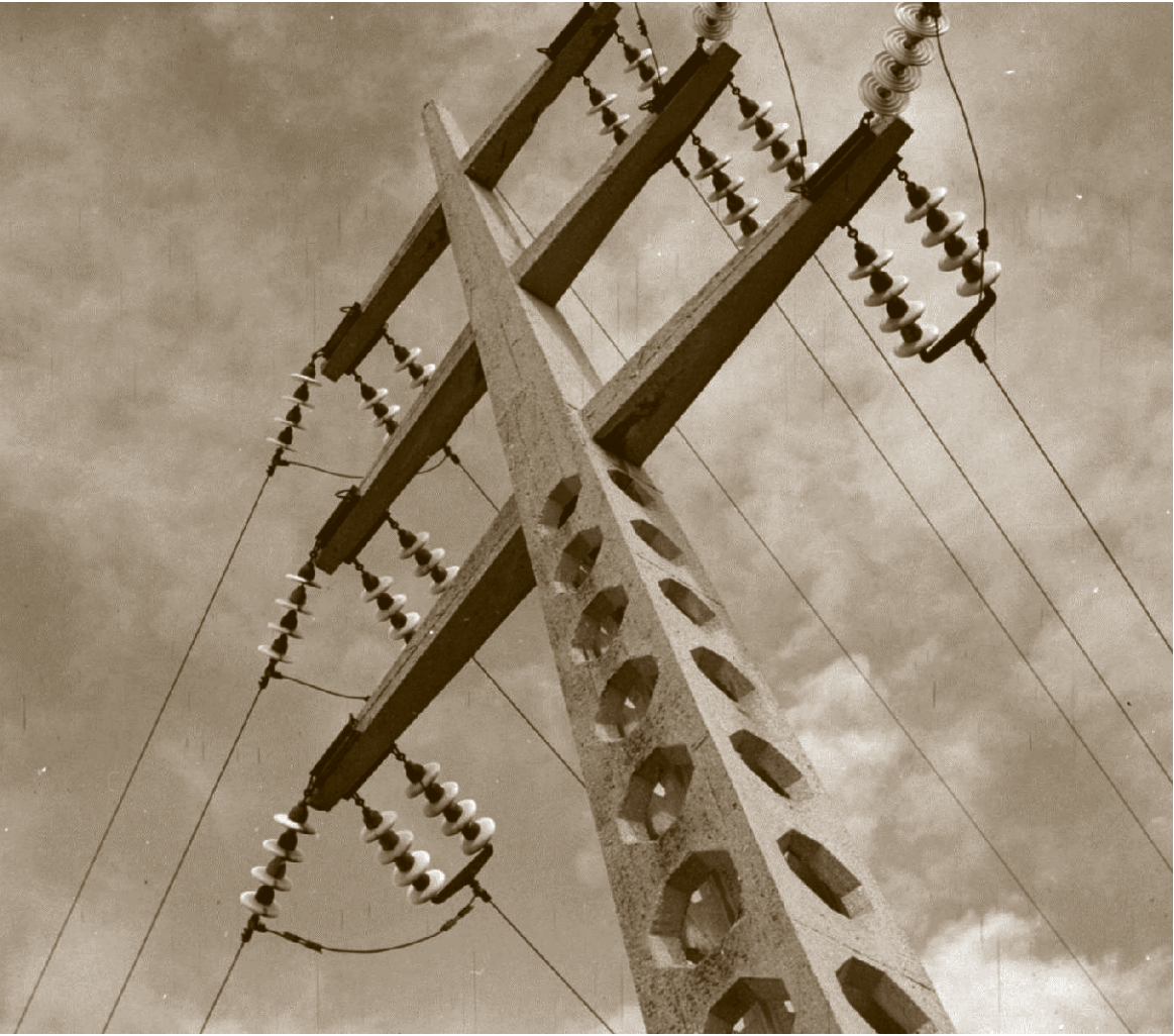
Stup dalekovoda 30 kV, prve i iznimno važne interkonekcije za veće potrošačko područje
