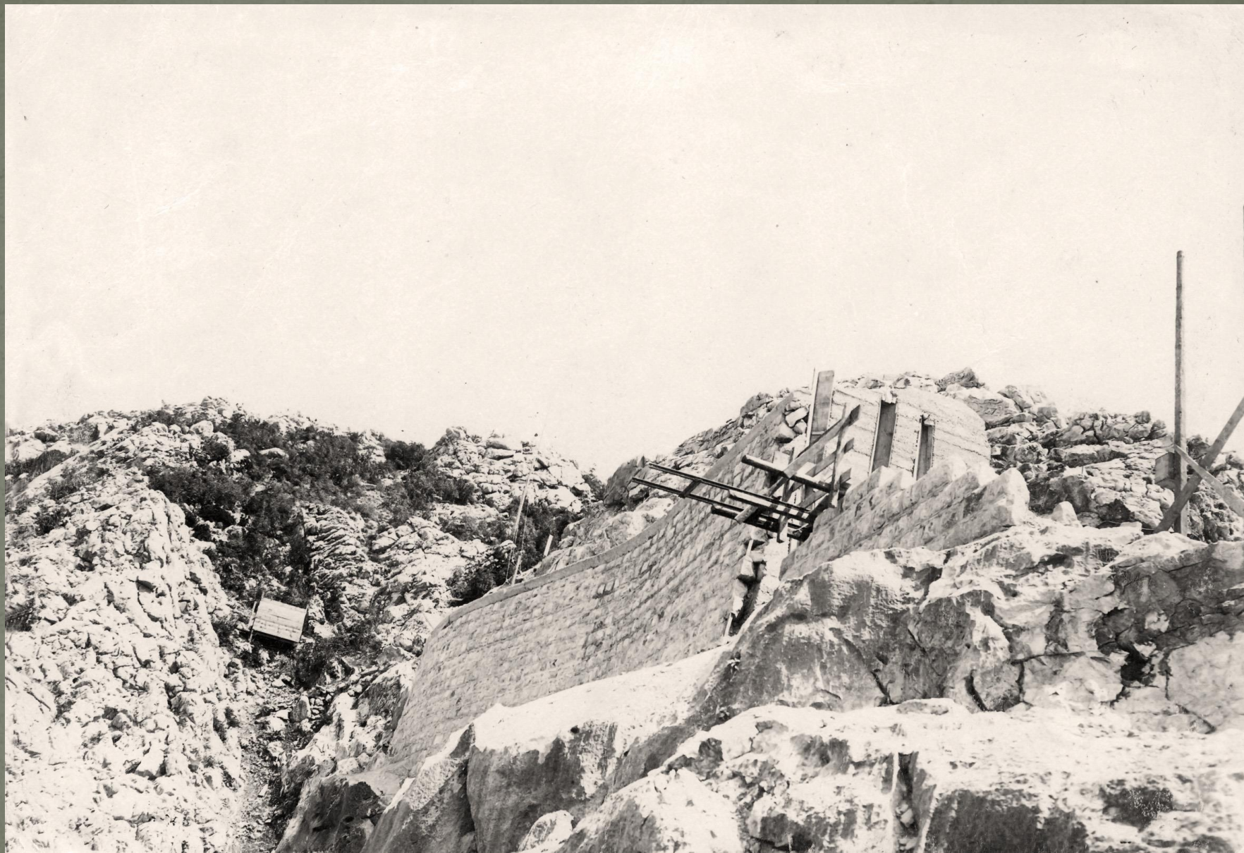
Izgradnja preljevnog zida vodne komore
