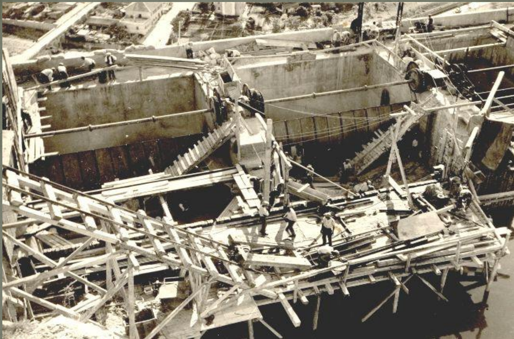
Radovi uređenja vodne komore druge etape
