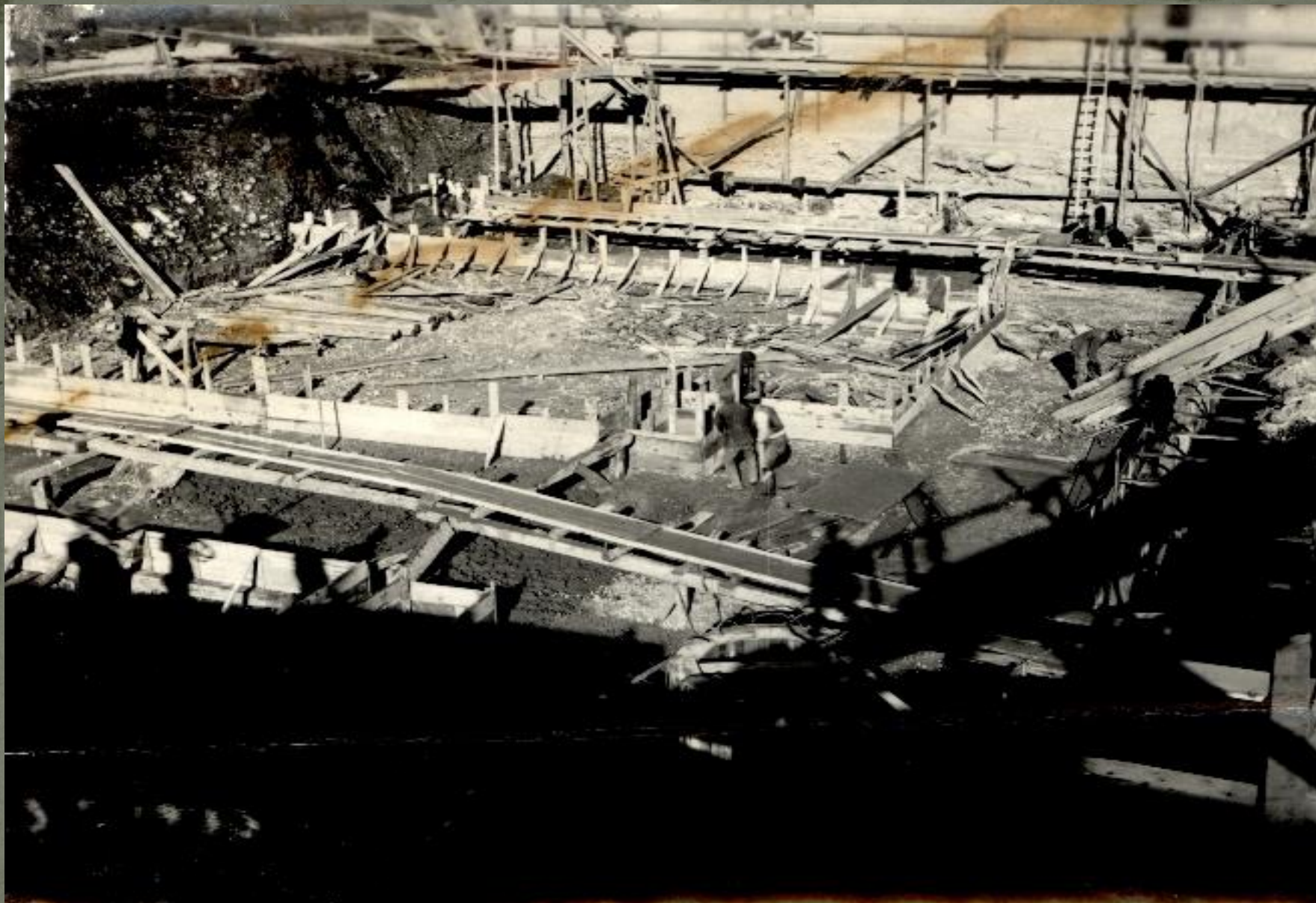
Iskop temelja za proširenje strojarnice
