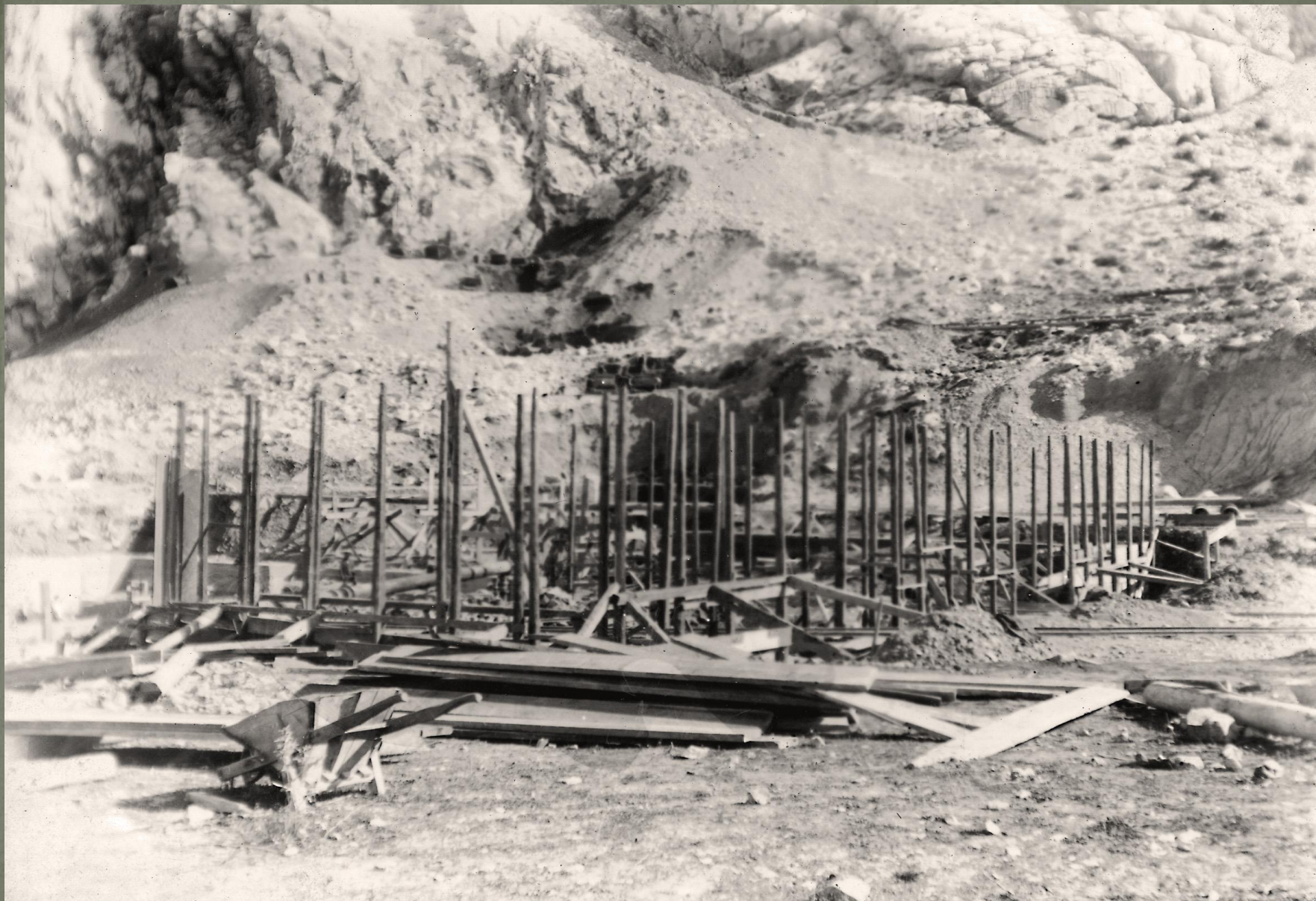
Početak radova na izgradnji strojarnice
