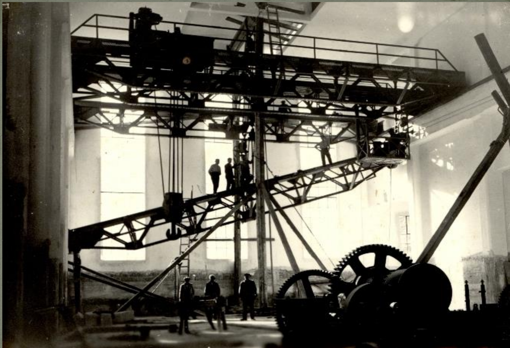
Radovi montaže mosne dizalice
