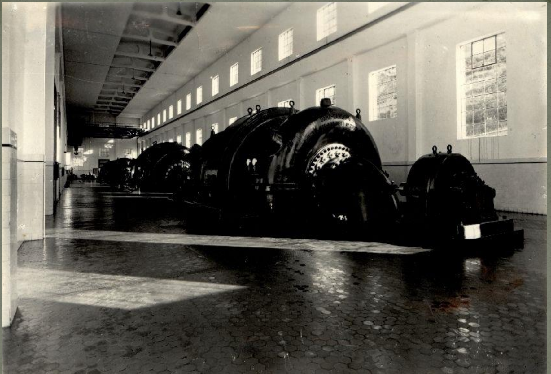
Završeni radovi montaže agregata
