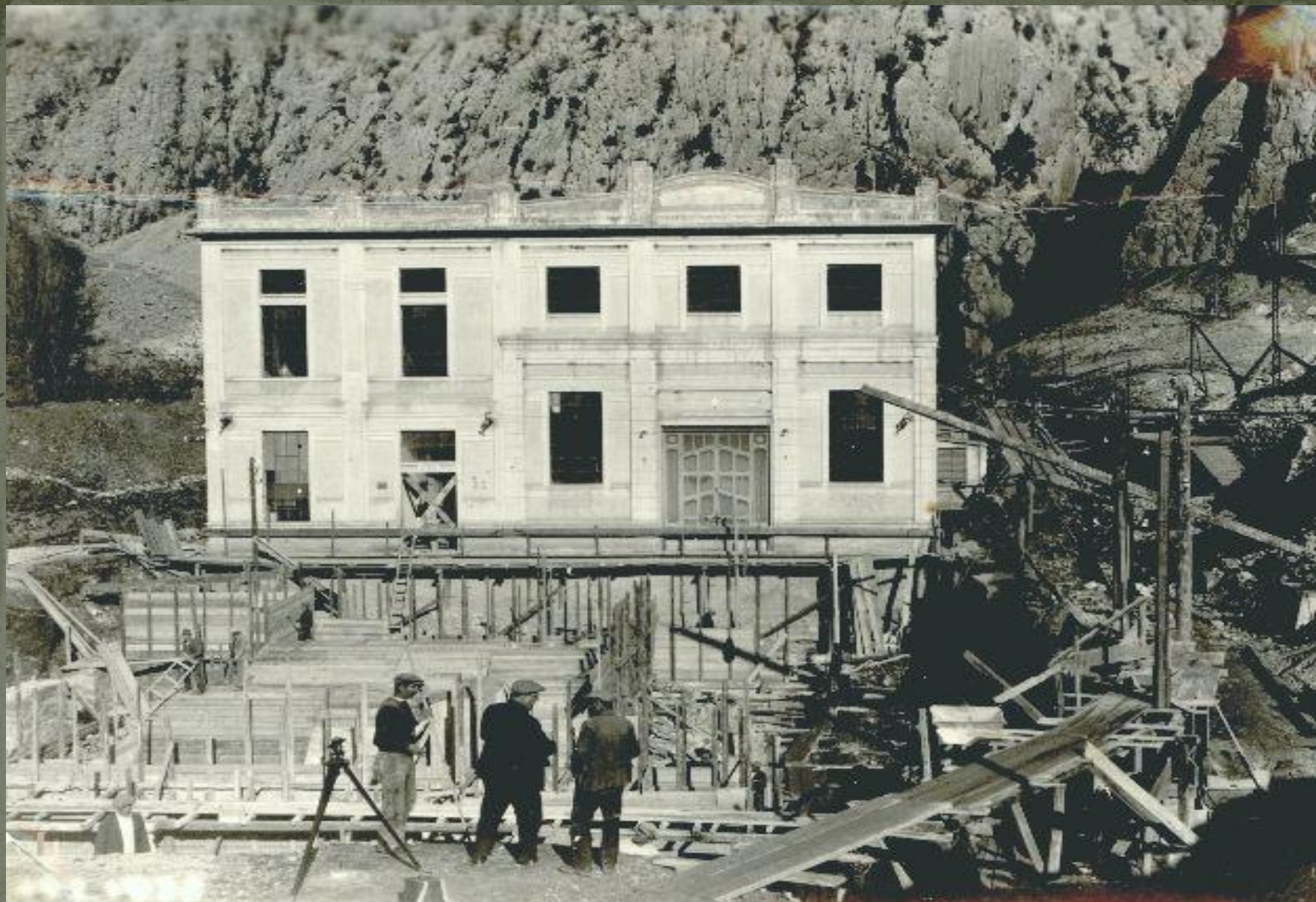
Radovi na proširenju strojarnice
