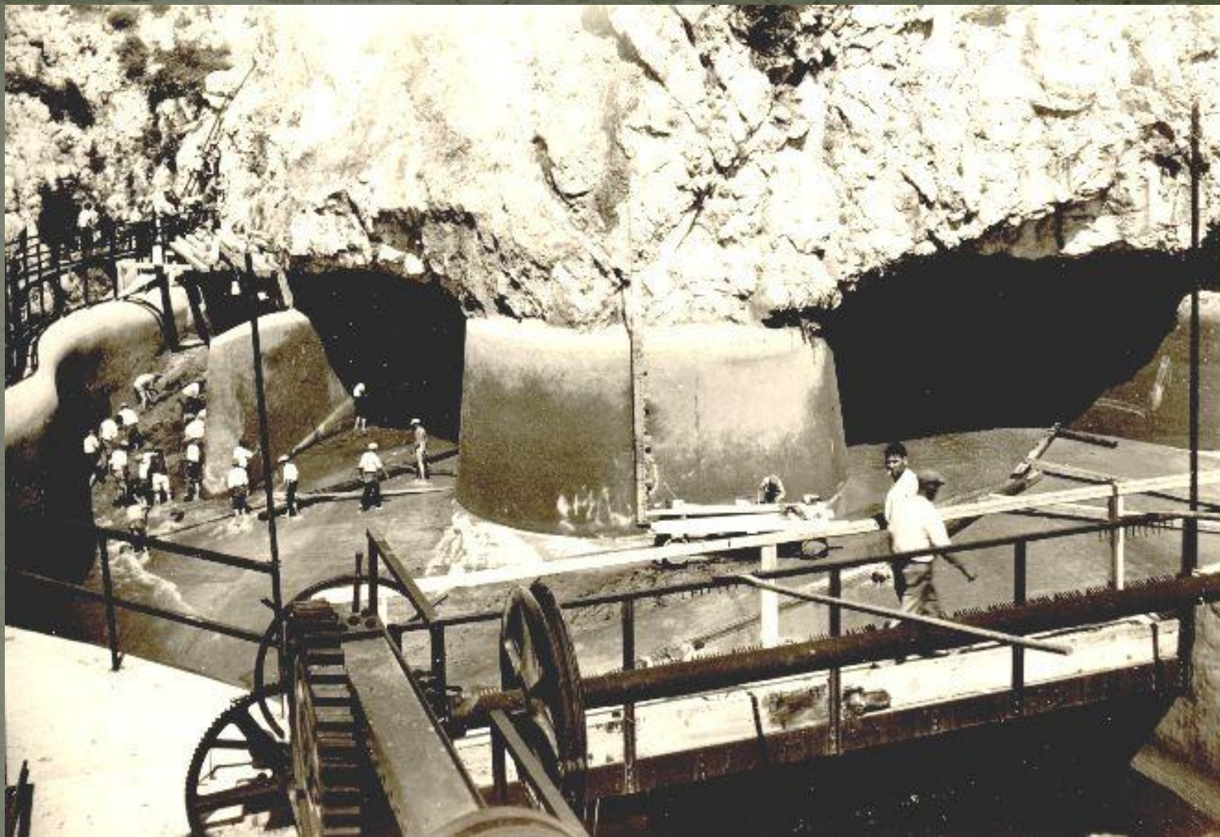
Radovi uređenja vodne komore druge etape
