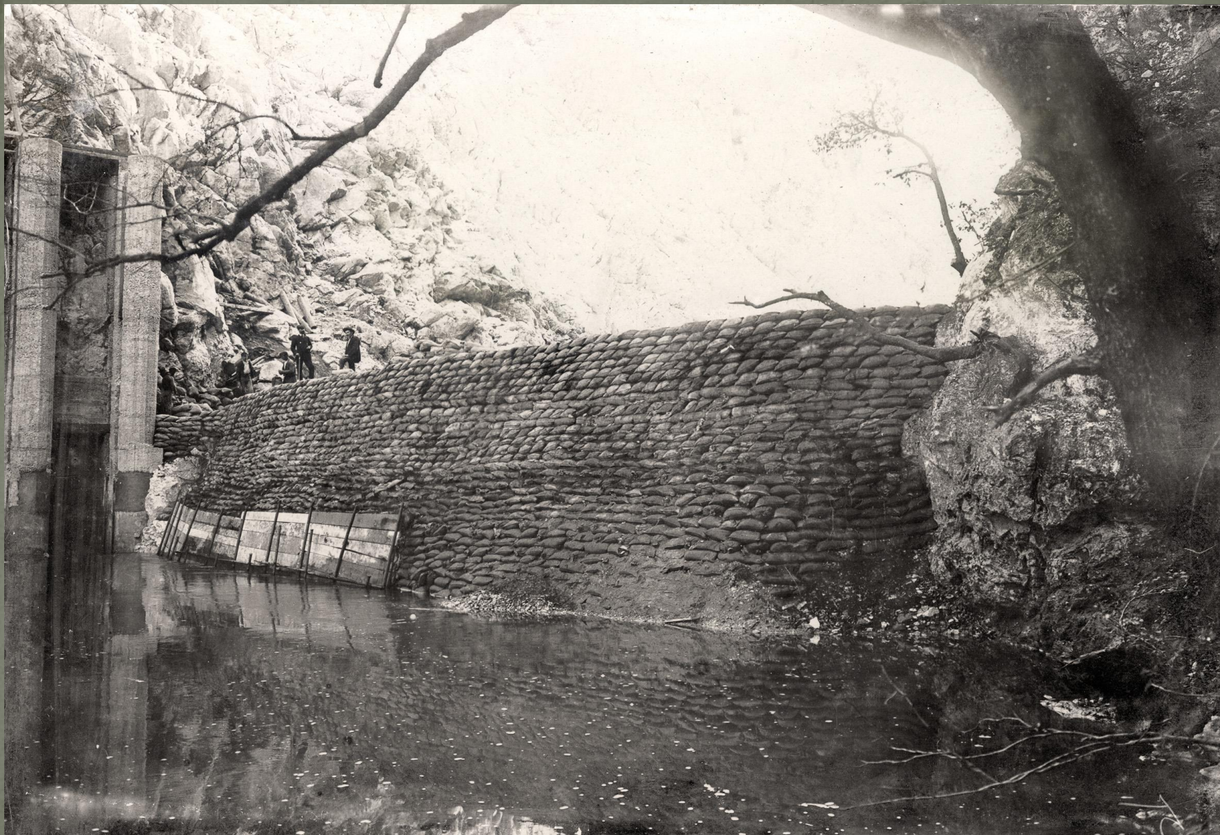
Provizorna brana izgrađena od 20.000 vreća pijeska
