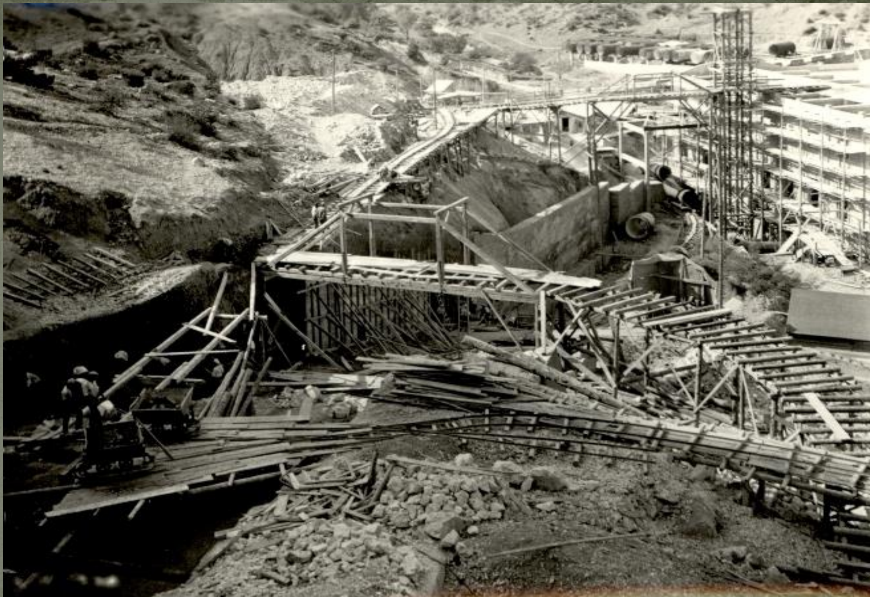
Radovi proširenja strojarnice i izgradnje tlačnih cjevovoda 3 i 4
