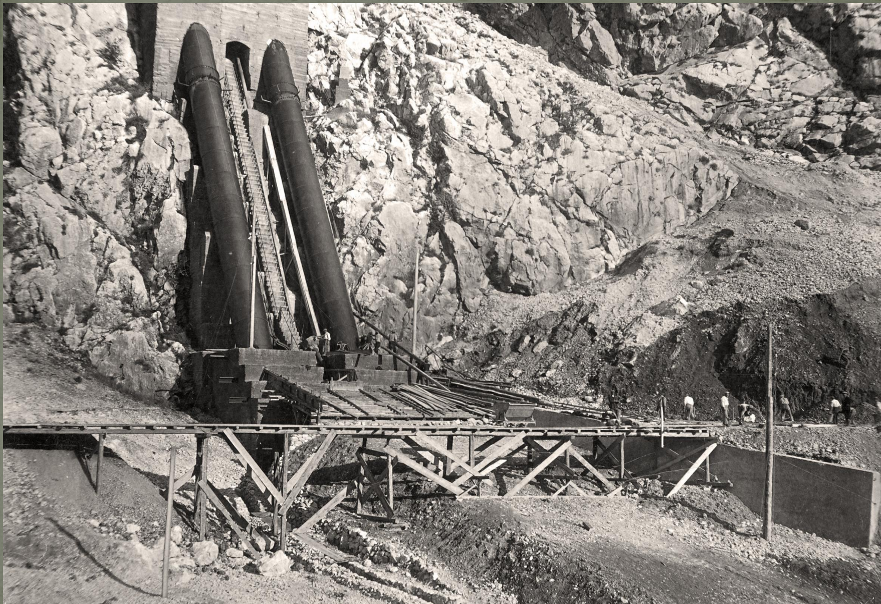
Radovi na izgradnji prva dva tlačna cjevovoda
