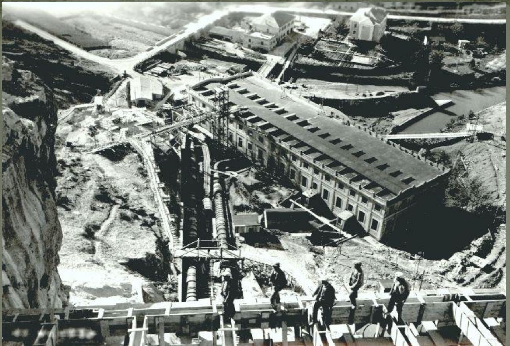
Završetak radova na izgradnji tlačnih cjevovoda 3 i 4
