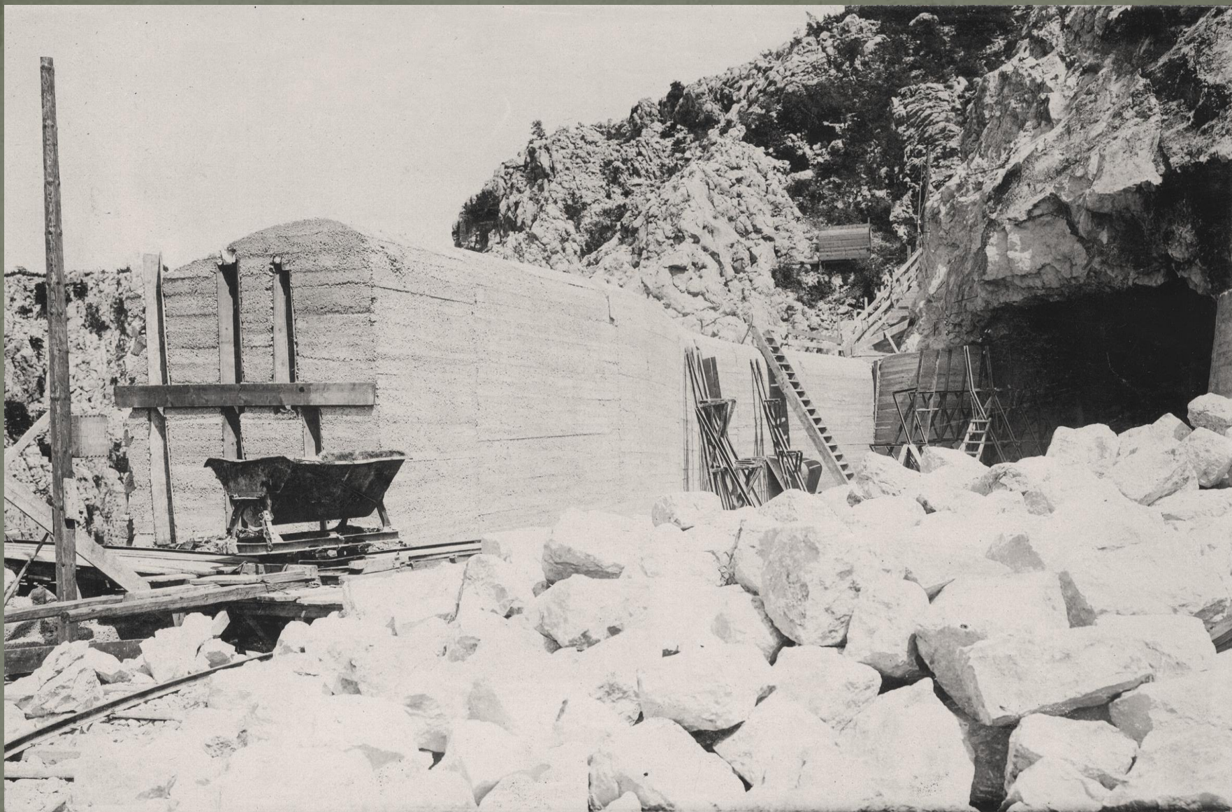
Lijevi izlaz iz tunela na vodnu komoru
