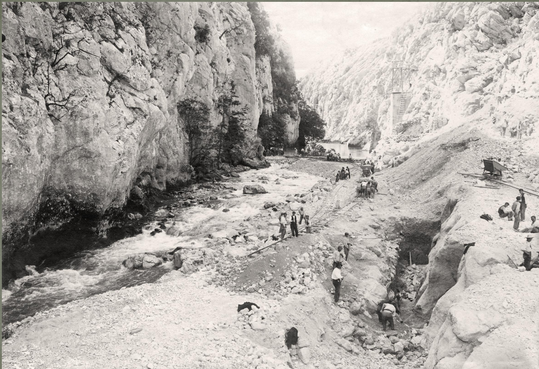
Izgradnja brane 1909. godine
