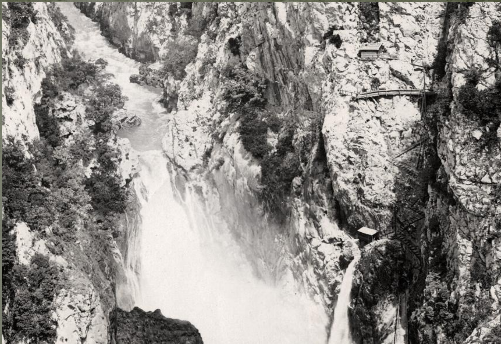
Od 1907-1909 u podnožju slapa Velika Gubavica ugrađena mala pomoćna hidroelektrana "Centralina", Pelton turbina s generatorom snage 130 KW
