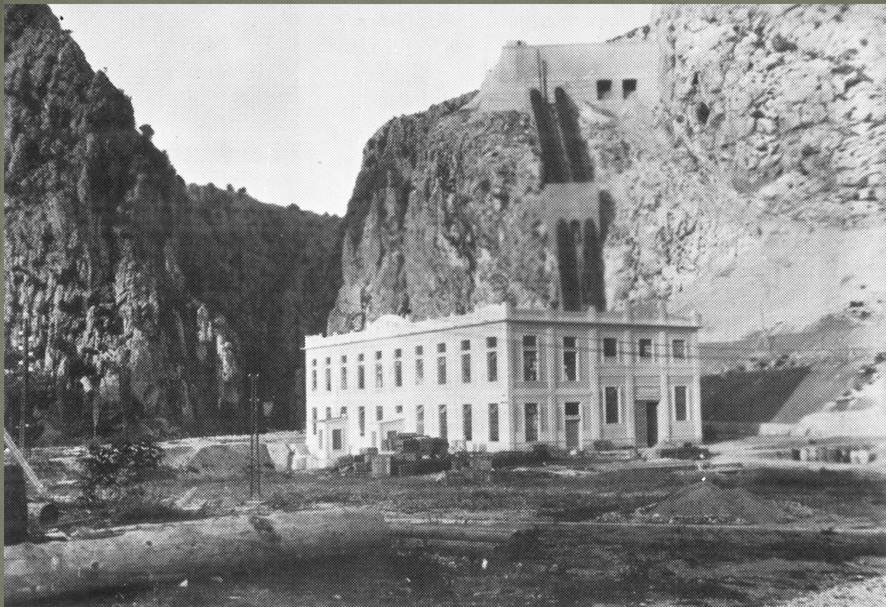
Završeni radovi prve faze izgradnje
