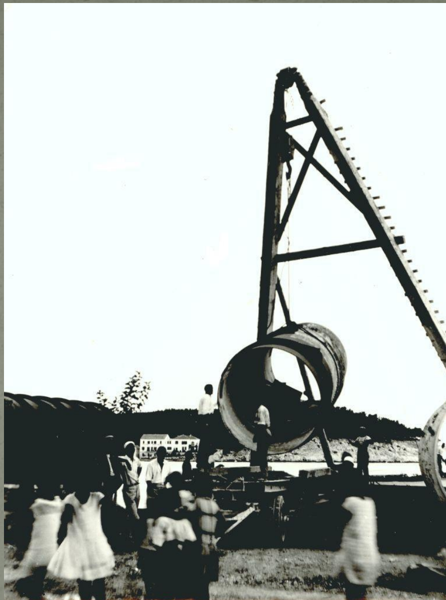
Iskrcaj dijelova tlačnih cjevovoda u Makarskoj
