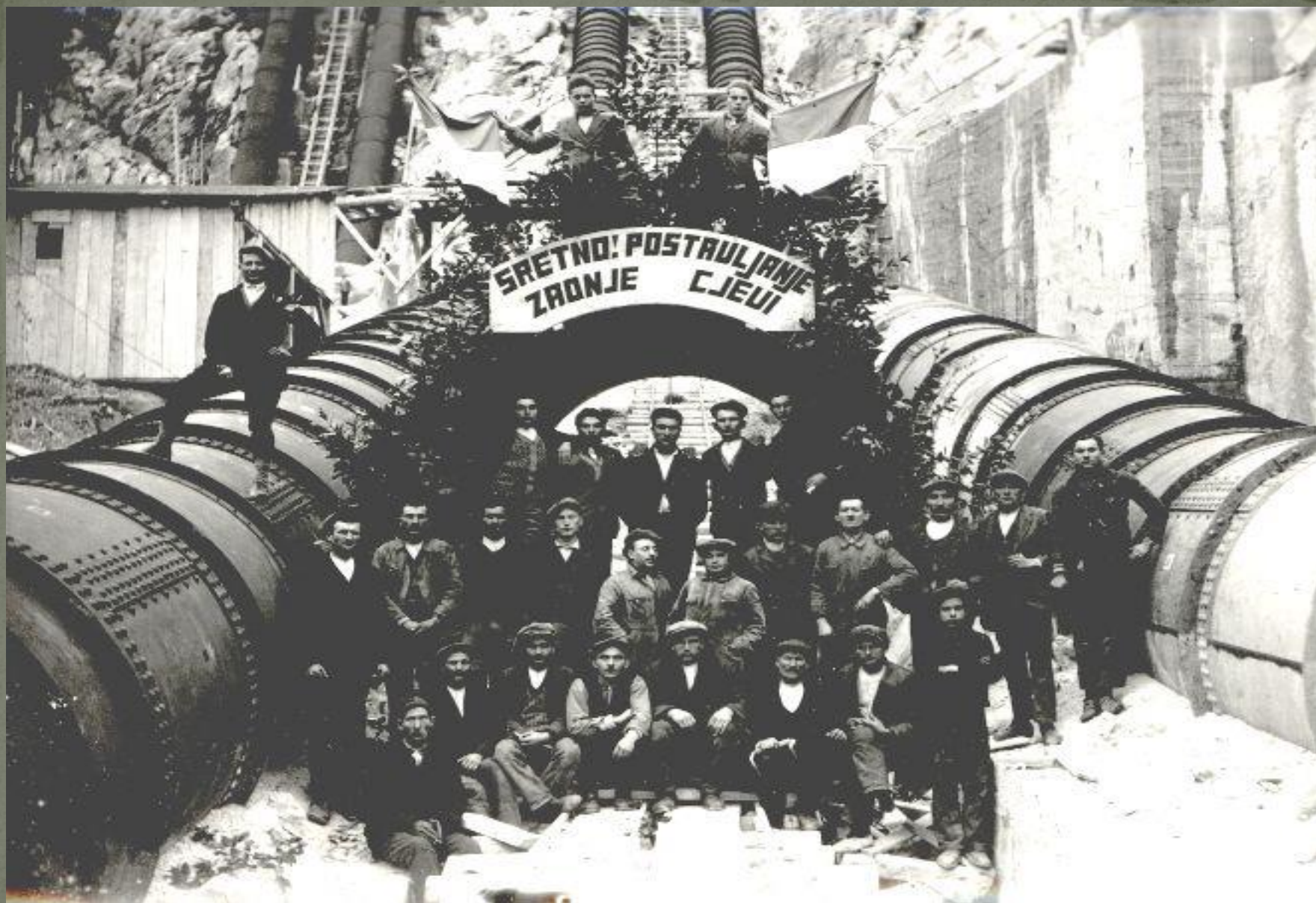
Završetak radova na izgradnji tlačnih cjevovoda 3 i 4
