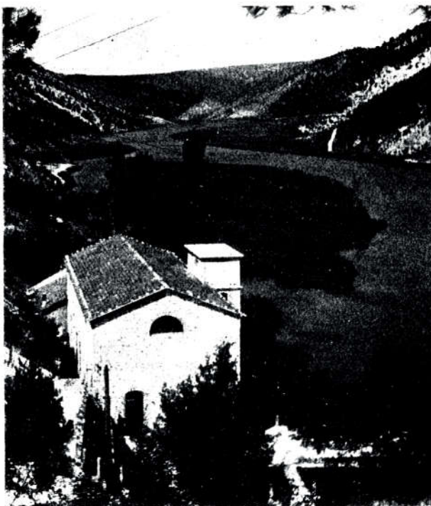
Hidroelektrana Jaruga na Krki
