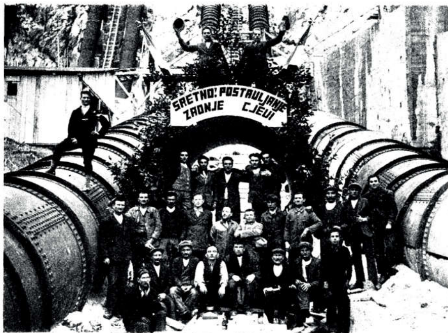
Cjevovodi su izgrađeni!
