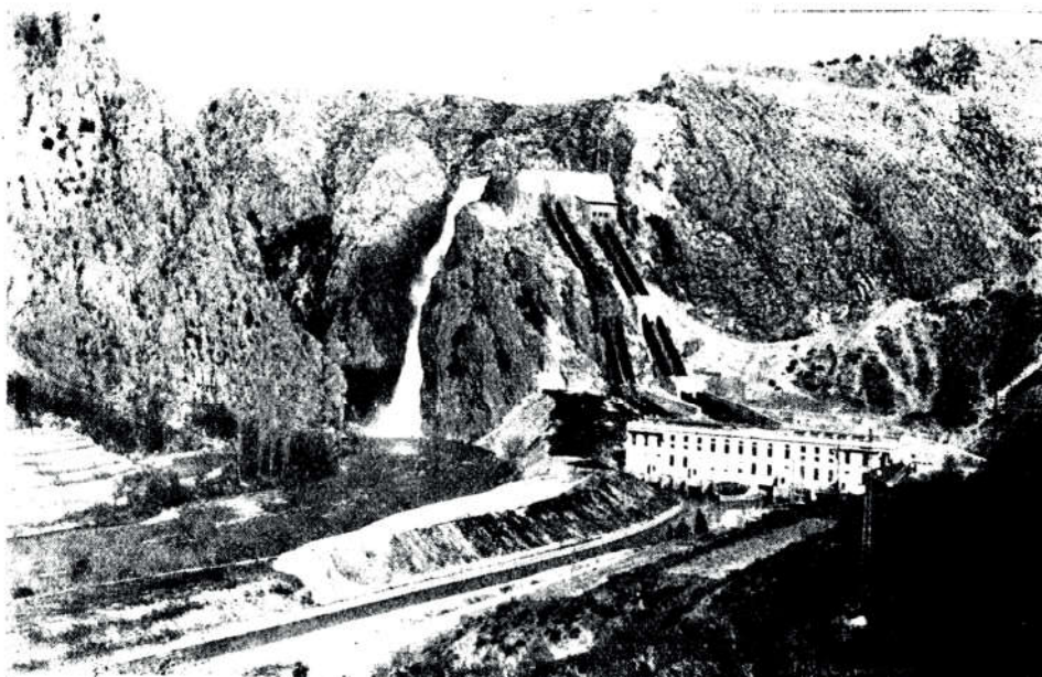
Pogled na hidroelektranu, preljevni slap i odvodni kanal
