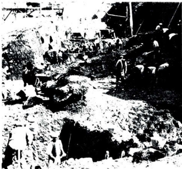
Pripremni radovi za proširenje elektrane
