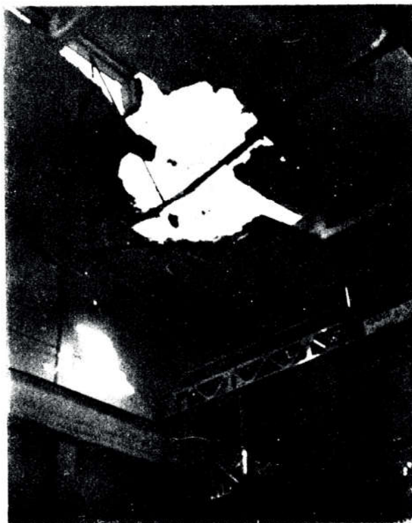
Krov oštećen tokom rata
