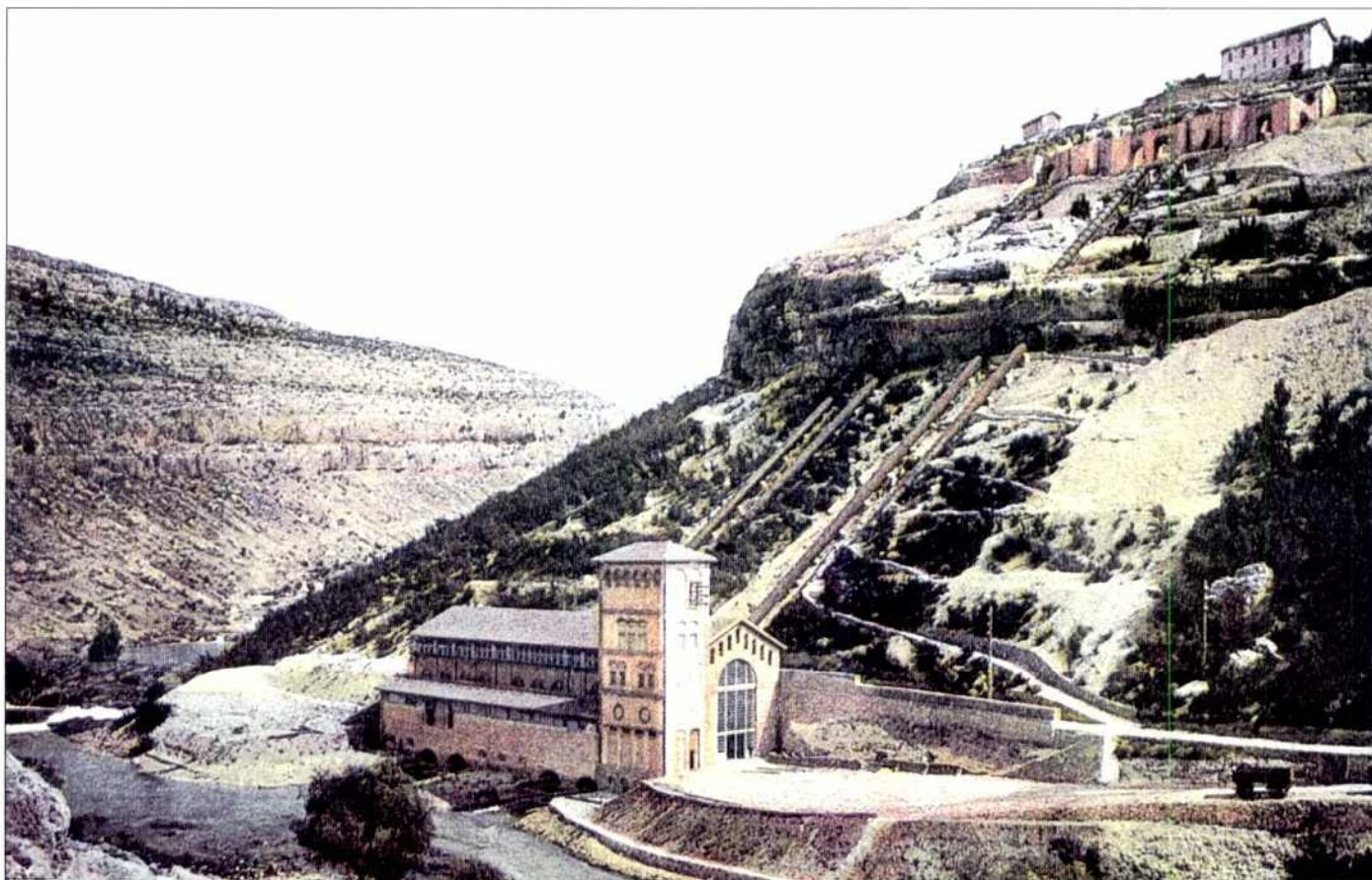
HE MILJACKA NEPOSREDNO NAKON IZGRADNJE
