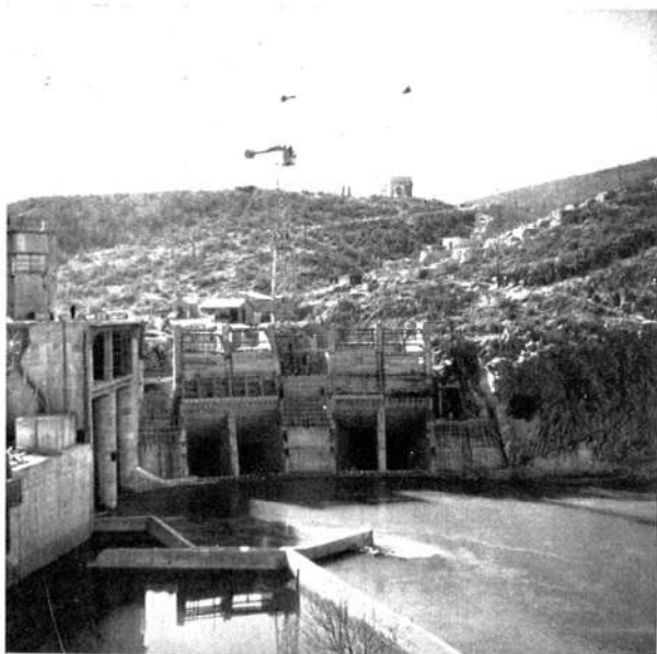
Ulazni uređaji u završnoj fazi građenja
