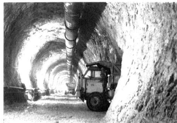
Dovodni tunel u fazi iskopa
