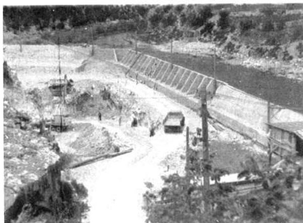
Zagat i građevinska jama prve etape
