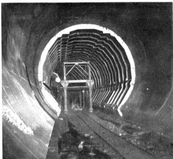
Teleskopska oplata u tunelu
