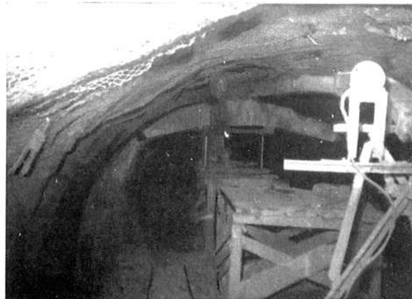
Ugrađivanje betona topom
