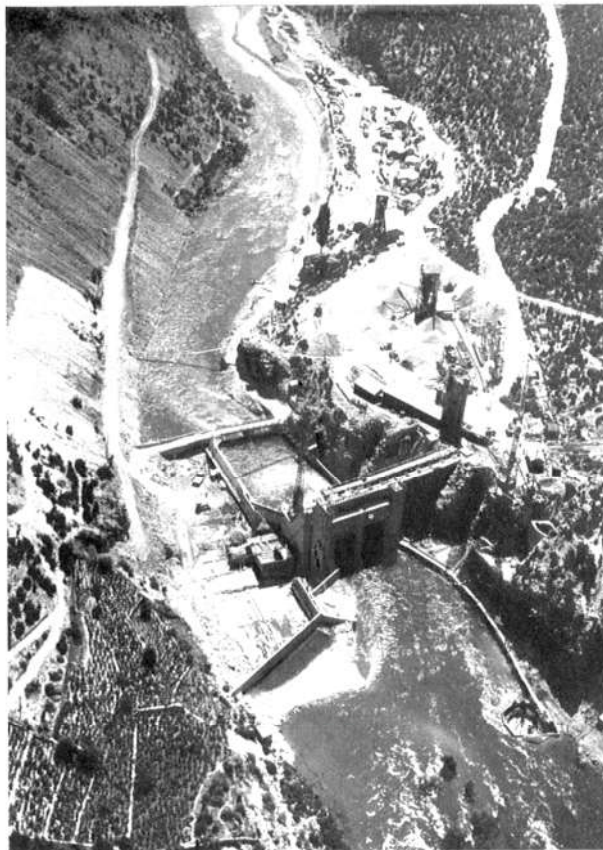
Građevinska jama brane druge etape
