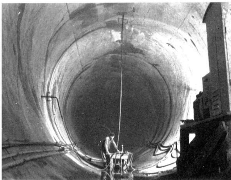
Injektiranje dovodnog tunela
