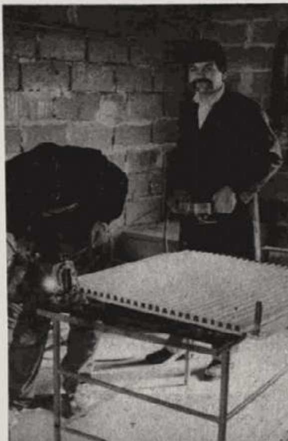
Ante Džepina u svojoj radionici prilikom izrade kolektora, za koje ističe da su isključivo od domaćih materijala.
