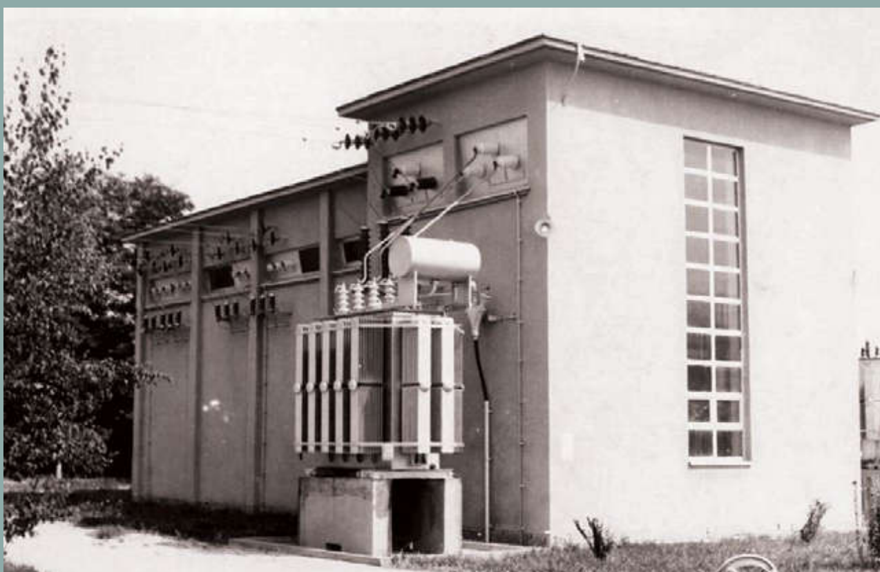
Trafostanica „Trokut“ u Čakovcu
