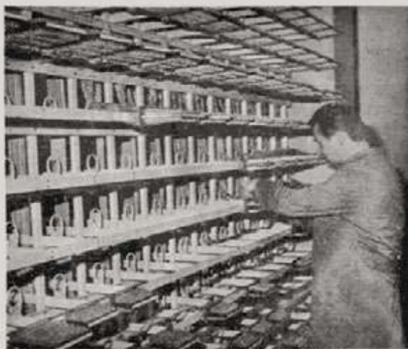
Montaža nove automatske telefonske centrale u Čakovcu za 4000 novih telefonskih pretplatnika
