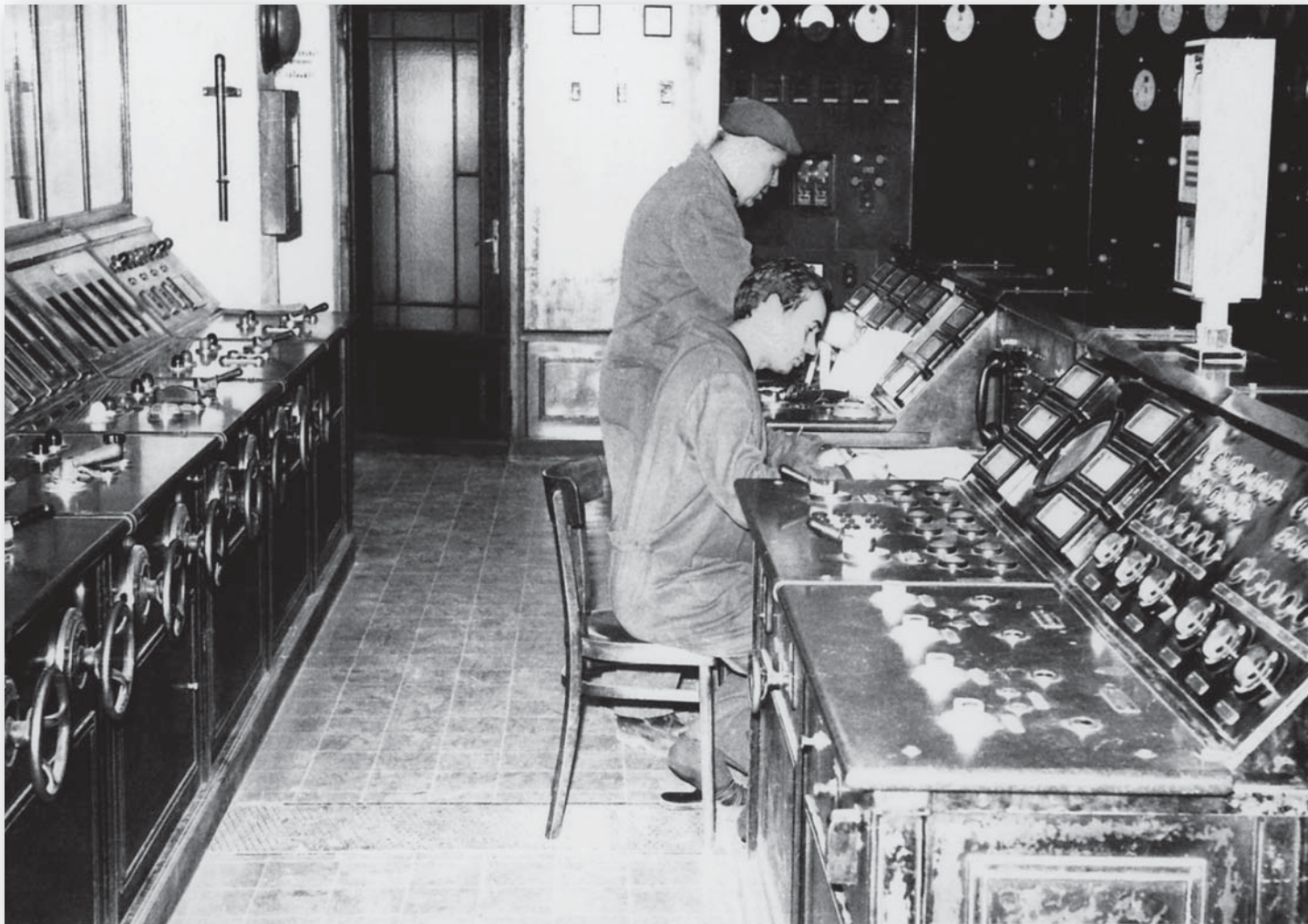
Upravljačnica Električne centrale
