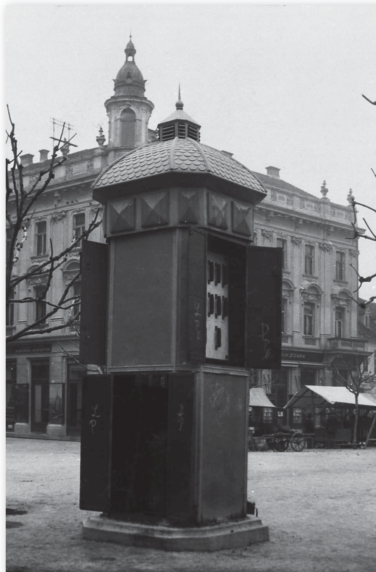
Limena transformatorska stanica 5/0,4 kV „Ganz“ iz 1907. godine na Preradovićevu trgu
