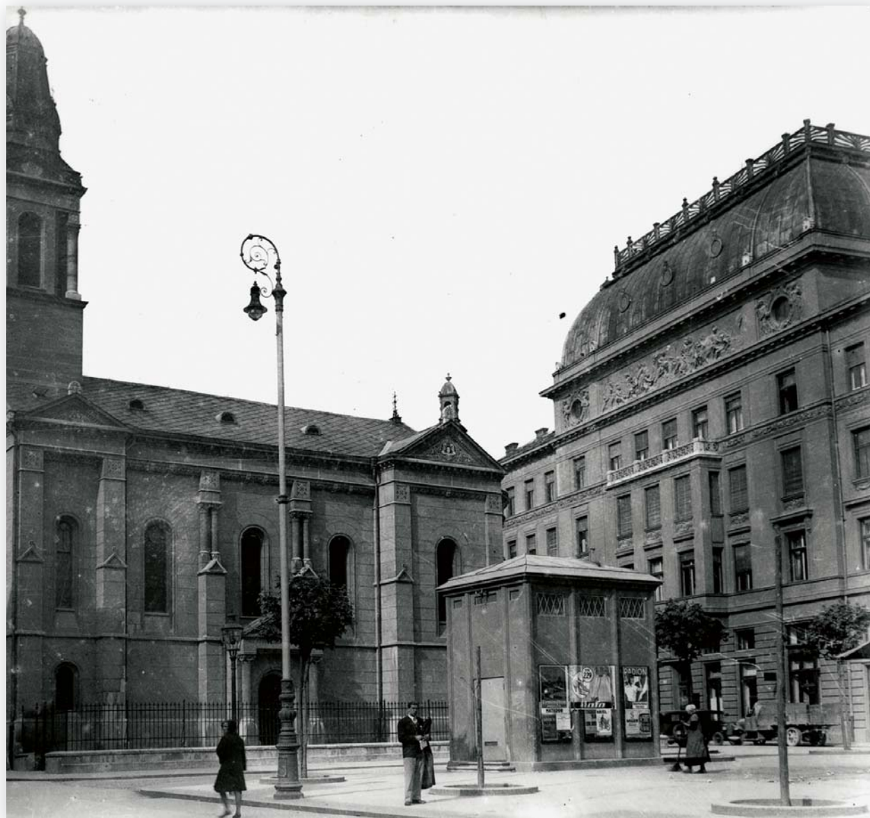
Tipska transformatorska stanica 5/0,5 kV u zagrebačkom središtu, 1918. godine
