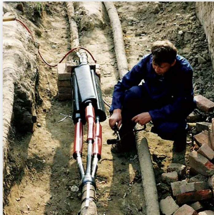
Popravak kvara na 30 kV kabelu
