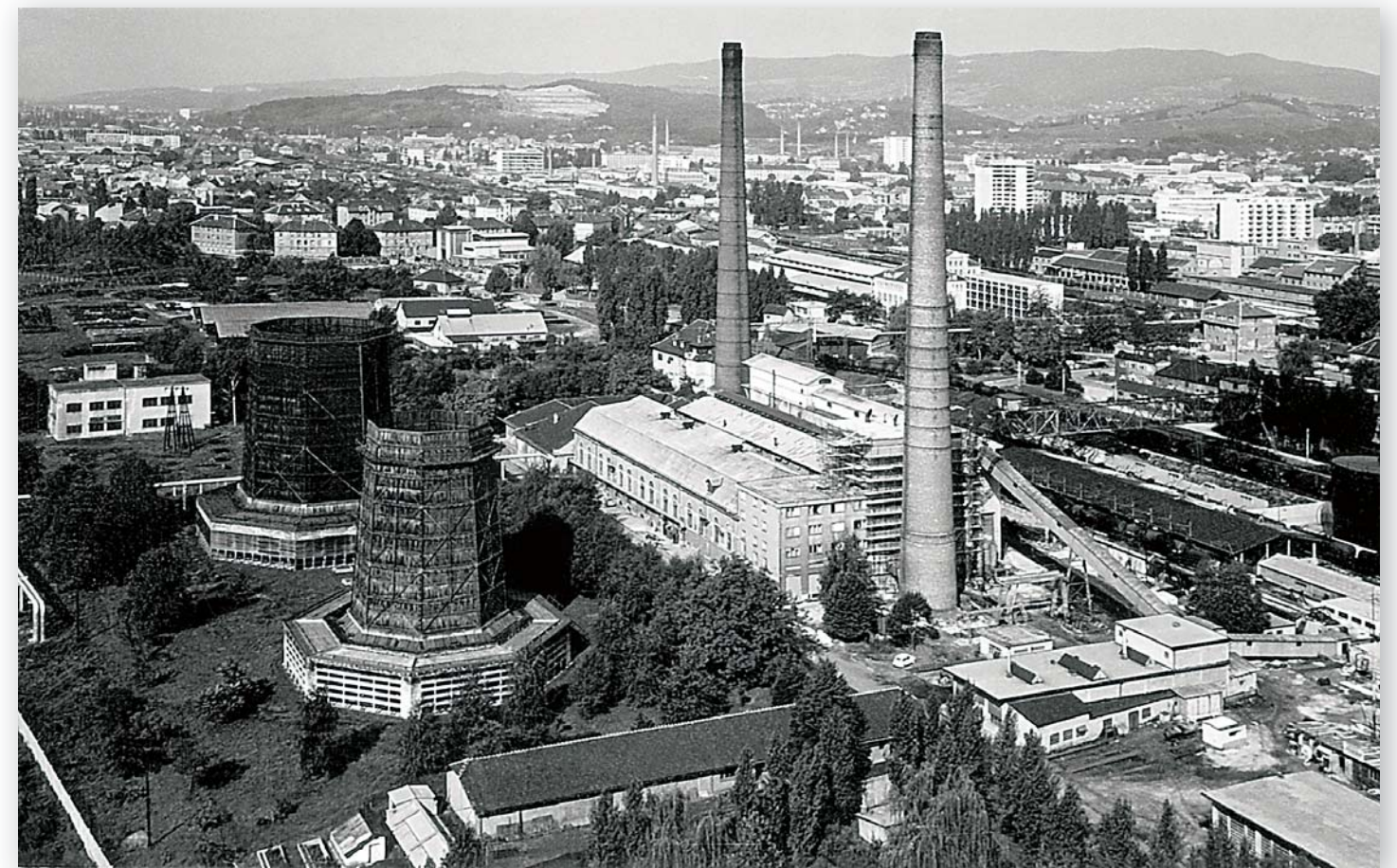
Elektrana - toplana s rashladnim tornjevima
