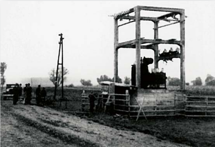
Transformatorska stanica 30/10 kV Kerestinec 1930. godine
