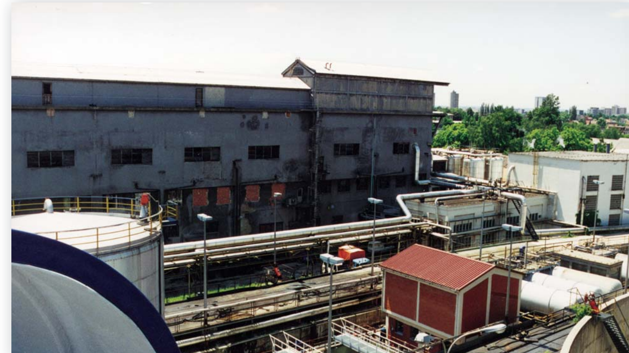
Izgradnja postrojenja za predobradu otpadnih voda
