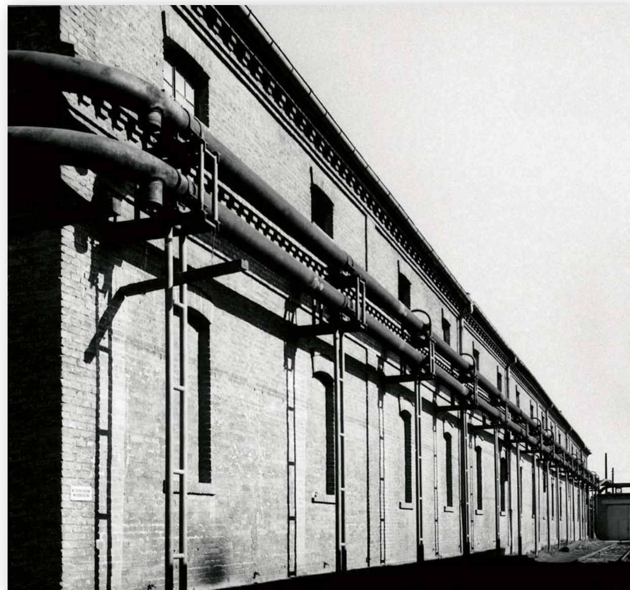
Zgrada strojarnice Električne centrale
