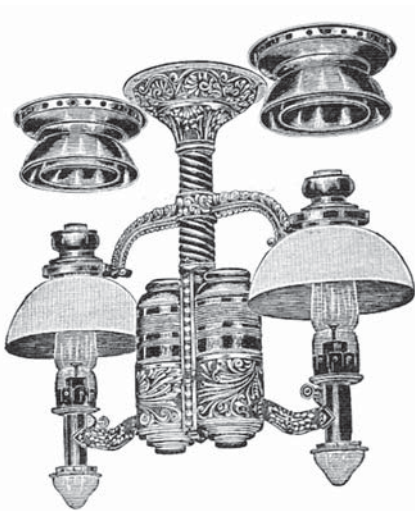
Plinska rasvjeta u Zagrebu početkom 20. stoljeća.
