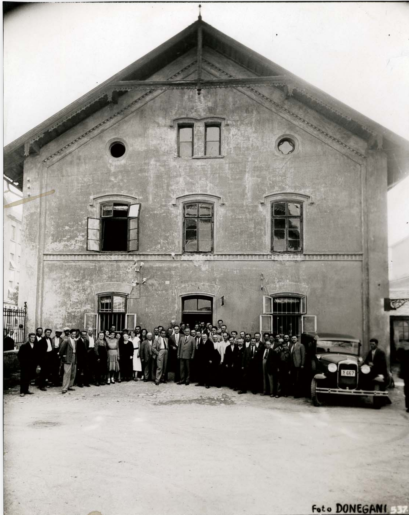
Negdašnja zgrada i osoblje Plinare u Gundulićevoj ulici, na čijem je mjestu izgrađena poslovna zgrada sjedišta Elektre Zagreb
