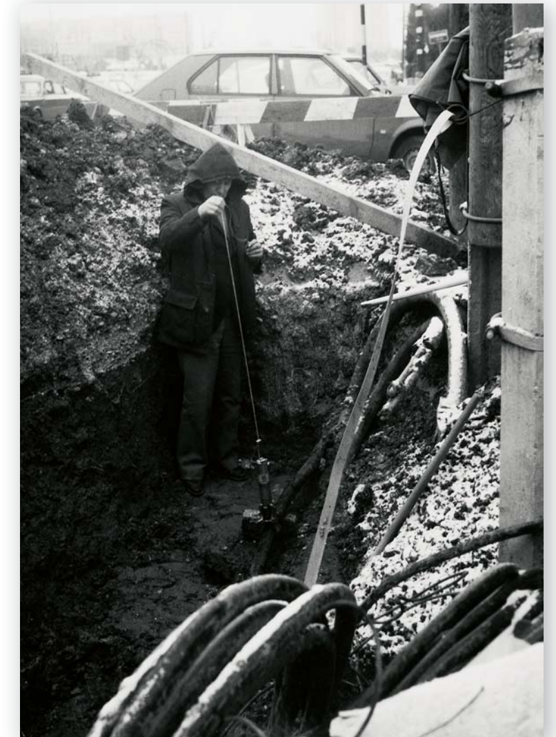
Izgradnja kabelske mreže
