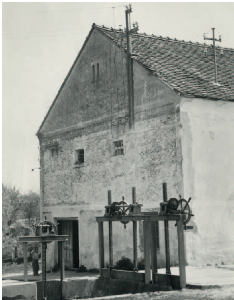
Požeška Električna centrala preuzela je malu hidroelektranu u Mihaljevcima
