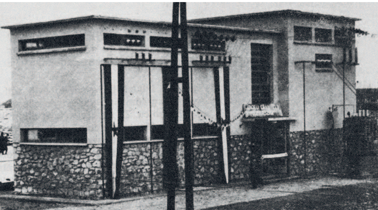
Trafostanica 30/6 kV Požega I. u pokusni je rad puštena 13. siječnja 1957., kao i dalekovod 30 kV Slavonski Brod – Slavonska Požega
