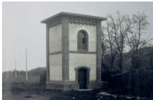
Trafostanica 6 kV s dalekovodom na betonskim stupovima, na gradskoj livadi u Trumbičevoj ulici (izgrađena 1912.)
