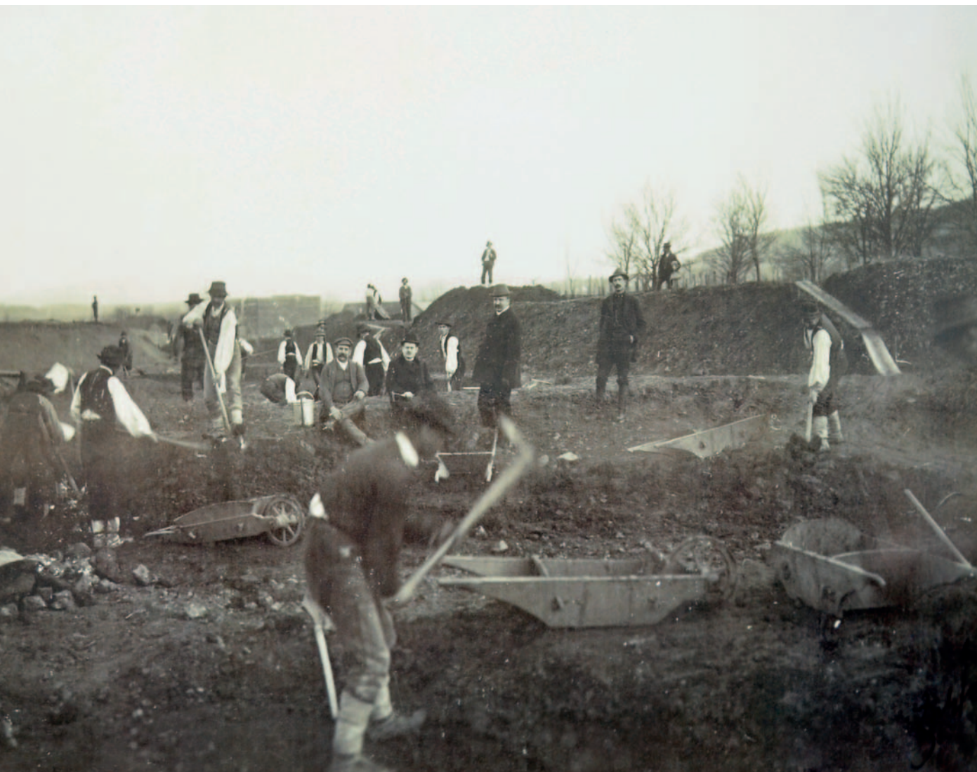
Početak izgradnje zgrade strojarnice
