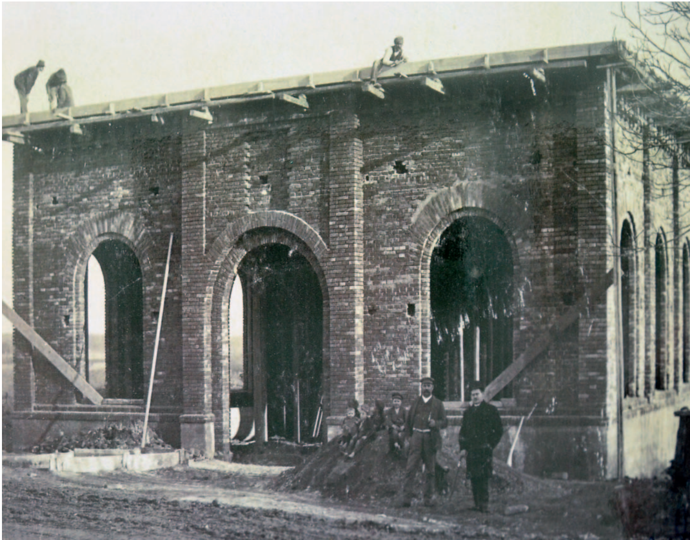
Faza izgradnje u kojoj se prepoznaju obrisi buduće strojarnice Elektrane Kuzmica
