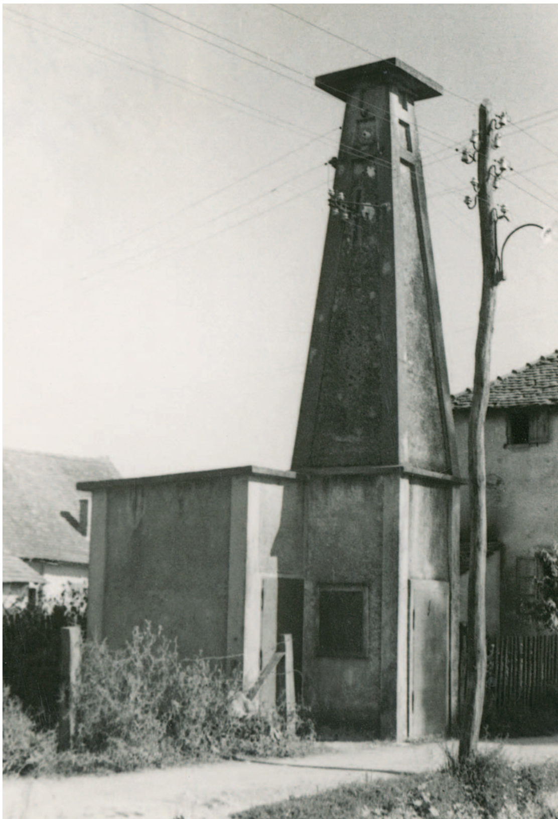
Trafostanica 6/0,11 kV na Ljubici, (izgrađena 1912.)
