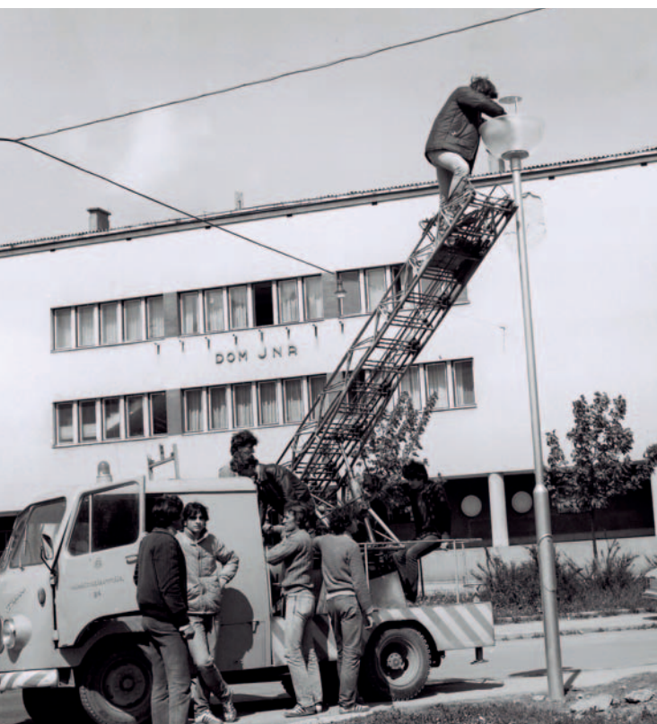
Izgradnja požeške javne rasvjete
