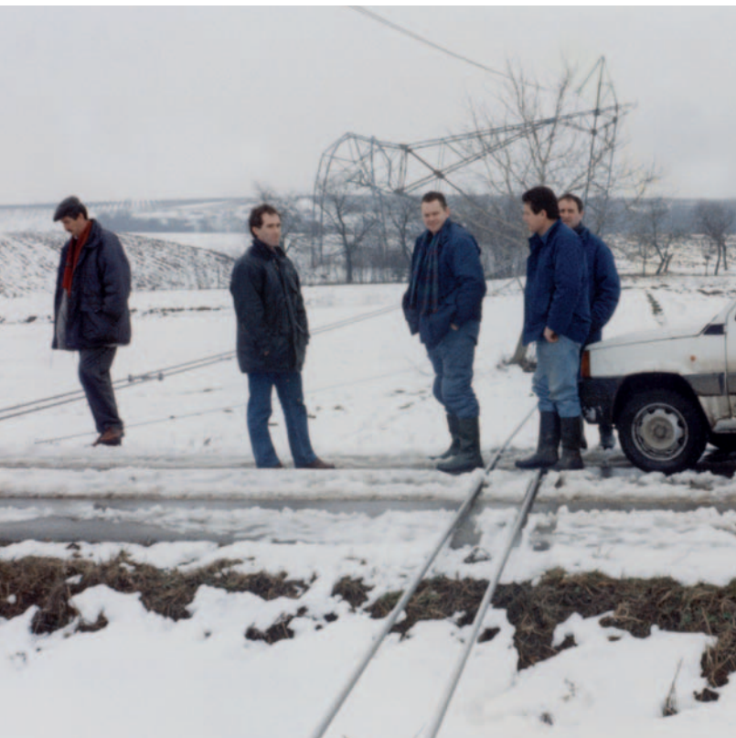
U Hrnjevcu, gdje je radila požeška ekipa, čeličnorešetkasti stup u neprirodnom položaju, vodovi 400 kV na tlu
