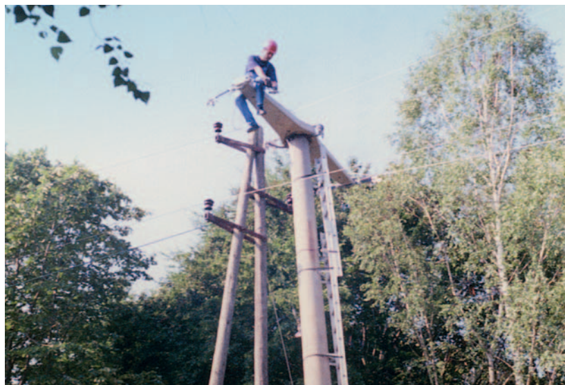
Priprema stupa za montažu izolatora sa žljebovima
