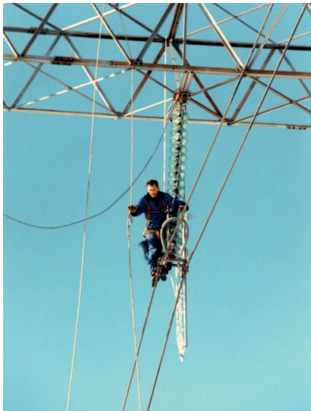
Priprema se montiranje izolatora i vodiča
