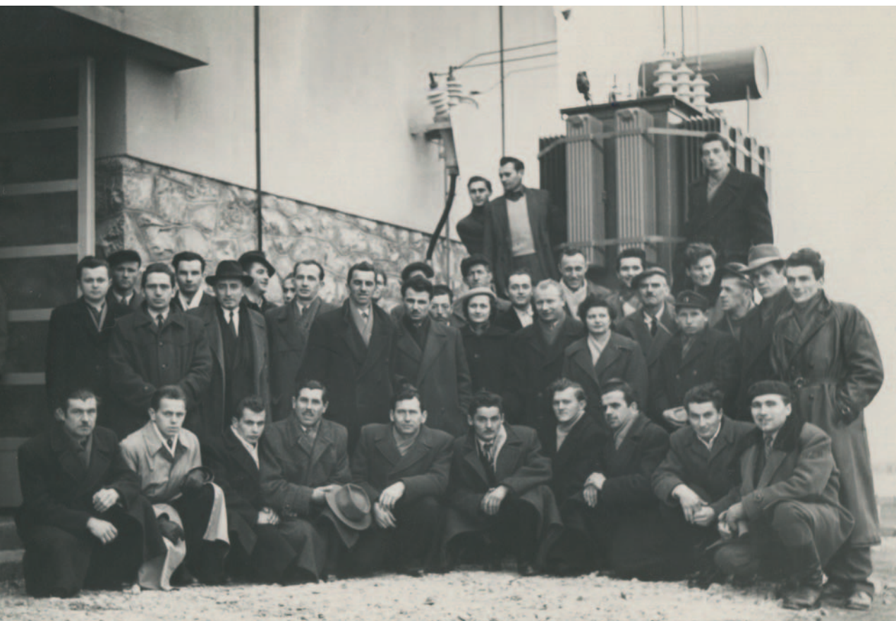
Zaposlenici požeškog Područnog ureda prigodom puštanja u rad trafostanice 30/6 kV Požega I.
