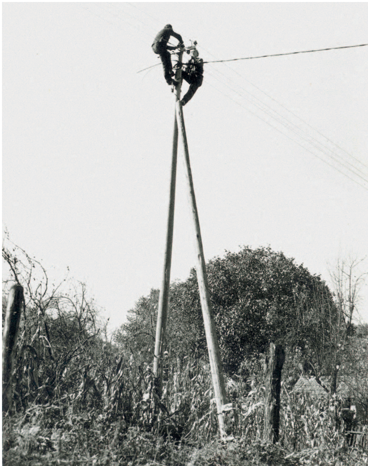
Monteri na vrhu A drvenog stupa
