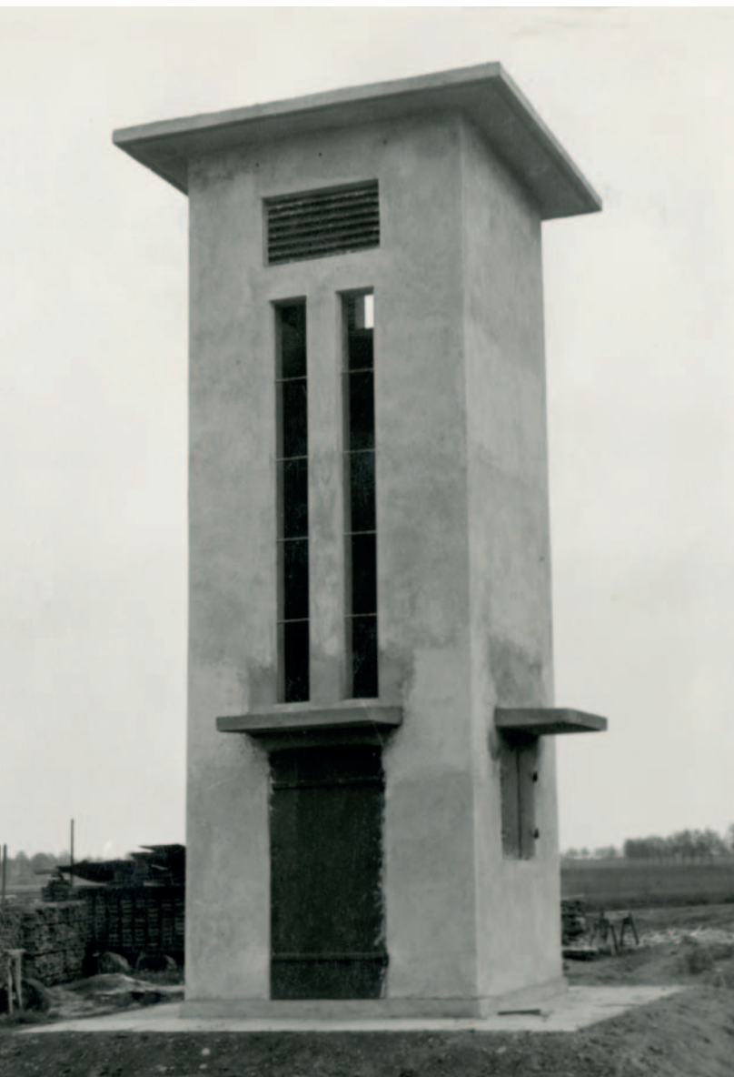
Industrijska trafostanica Lipa...
