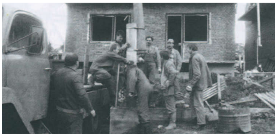
Ekipa Zračne mreže Elektre Zagreba na crti bojišnice pomaže kolegama u selu Gorice pokraj Nove Gradiške
