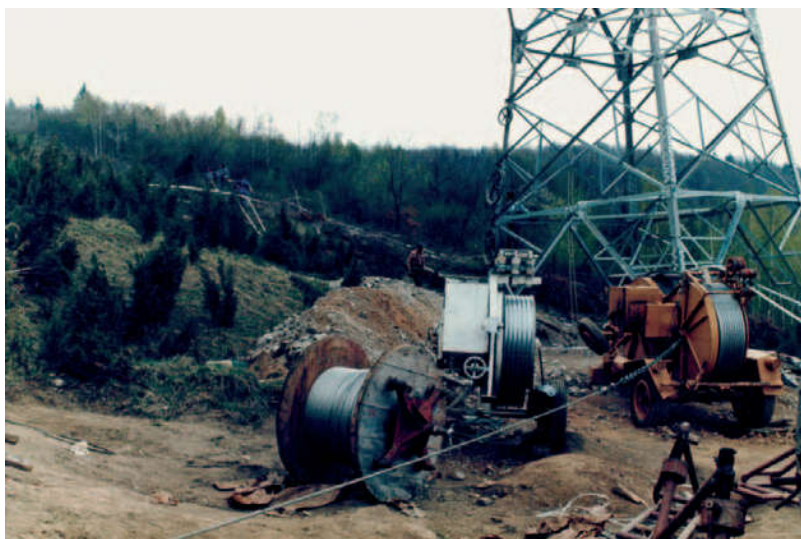
Trasa dalekovoda u Bosiljevu prolazila je neposredno uz crtu razdvajanja pa su zbog zračnih opasnosti i raketiranja zaposlenici izvođača (Dalekovod) često morali prekidati montažne radove
