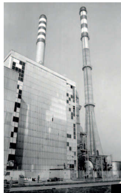
Na zgradi strojarnice, razbijena stakla zamijenio je lim
