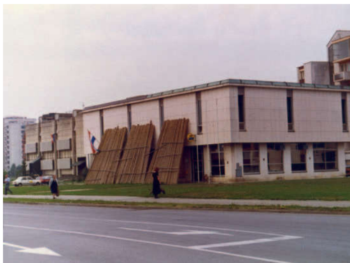
Poslovna zgrada Elektro Karlovac zaštićena na najkritičnijim mjestima
