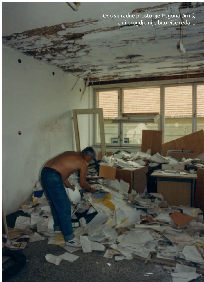
Unutrašnjost zgrade Područnog ureda Petrinja
