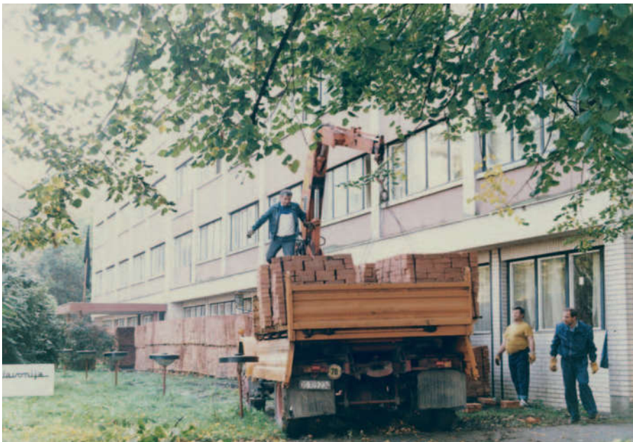
Prizemlje poslovne zgrade na Šetalištu kardinala Šepera, kao i ostalih poslovno-pogonskih zgrada, bile su obložene paletama opeka
