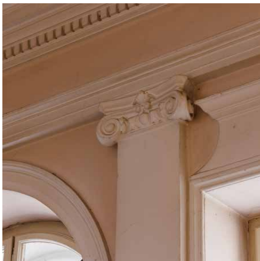
Zrcalni strop iznad stubišta
