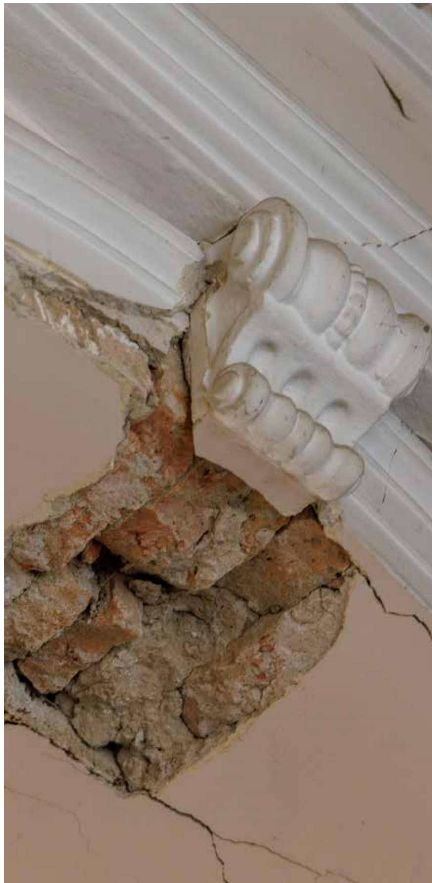
Oštećenja od potresa u interijeru
