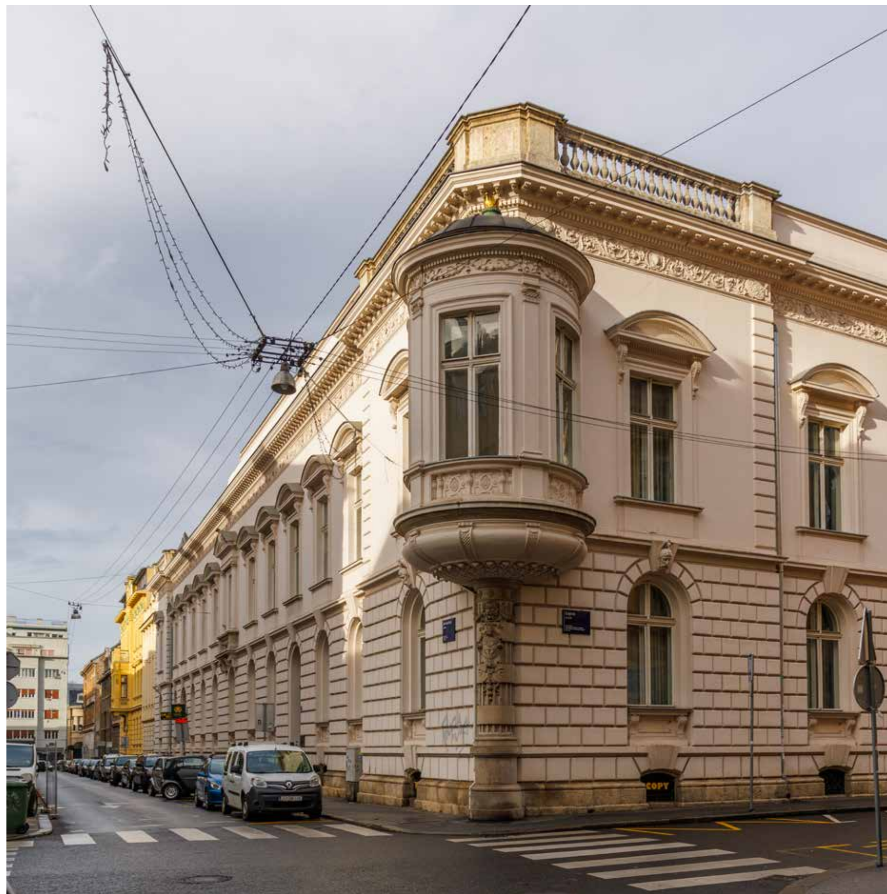
Južno i istočno pročelje s ugaonim erkerom
