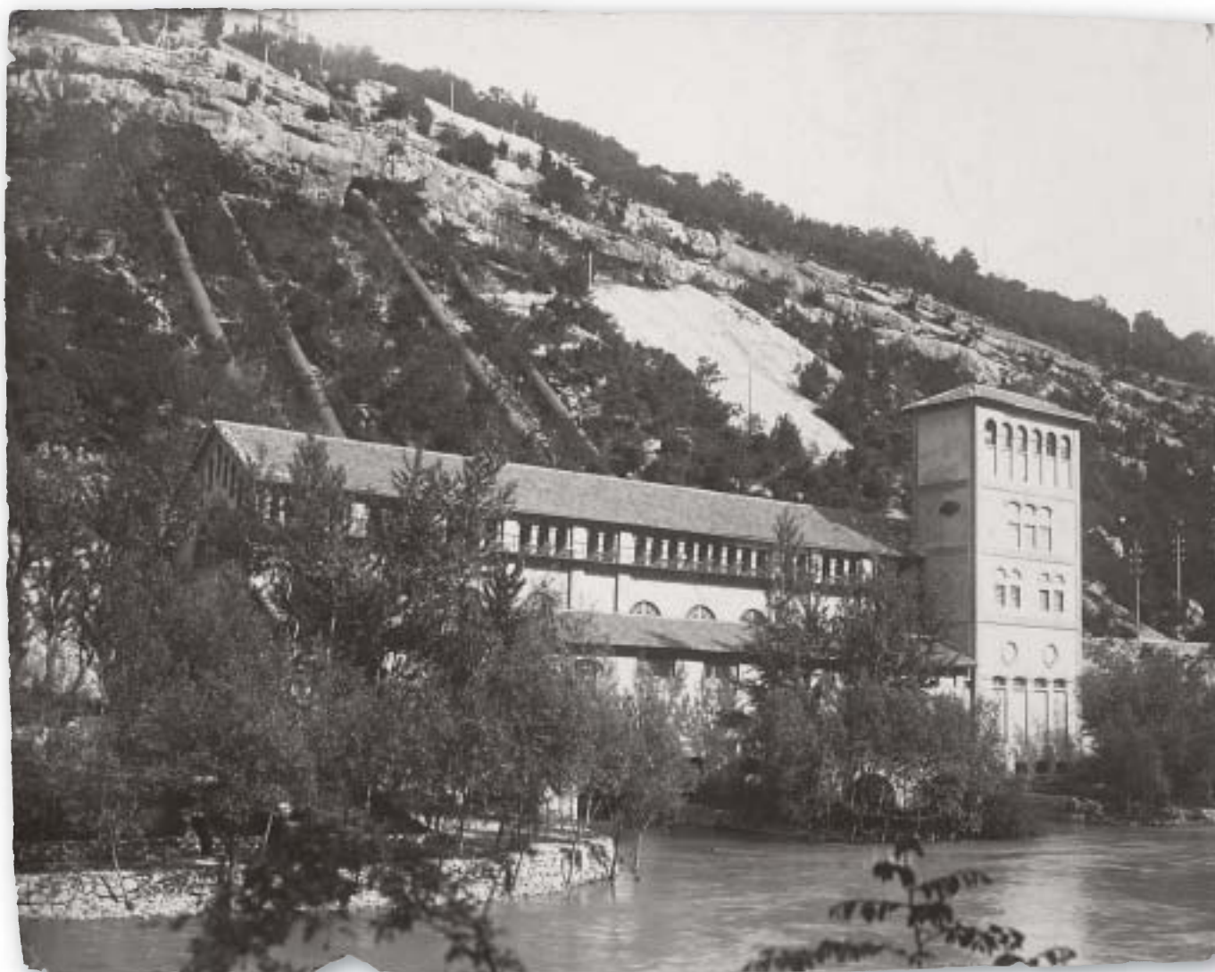
Hidroelektrana Krka na slapovima rijeke Krke u blizini grada Šibenika
