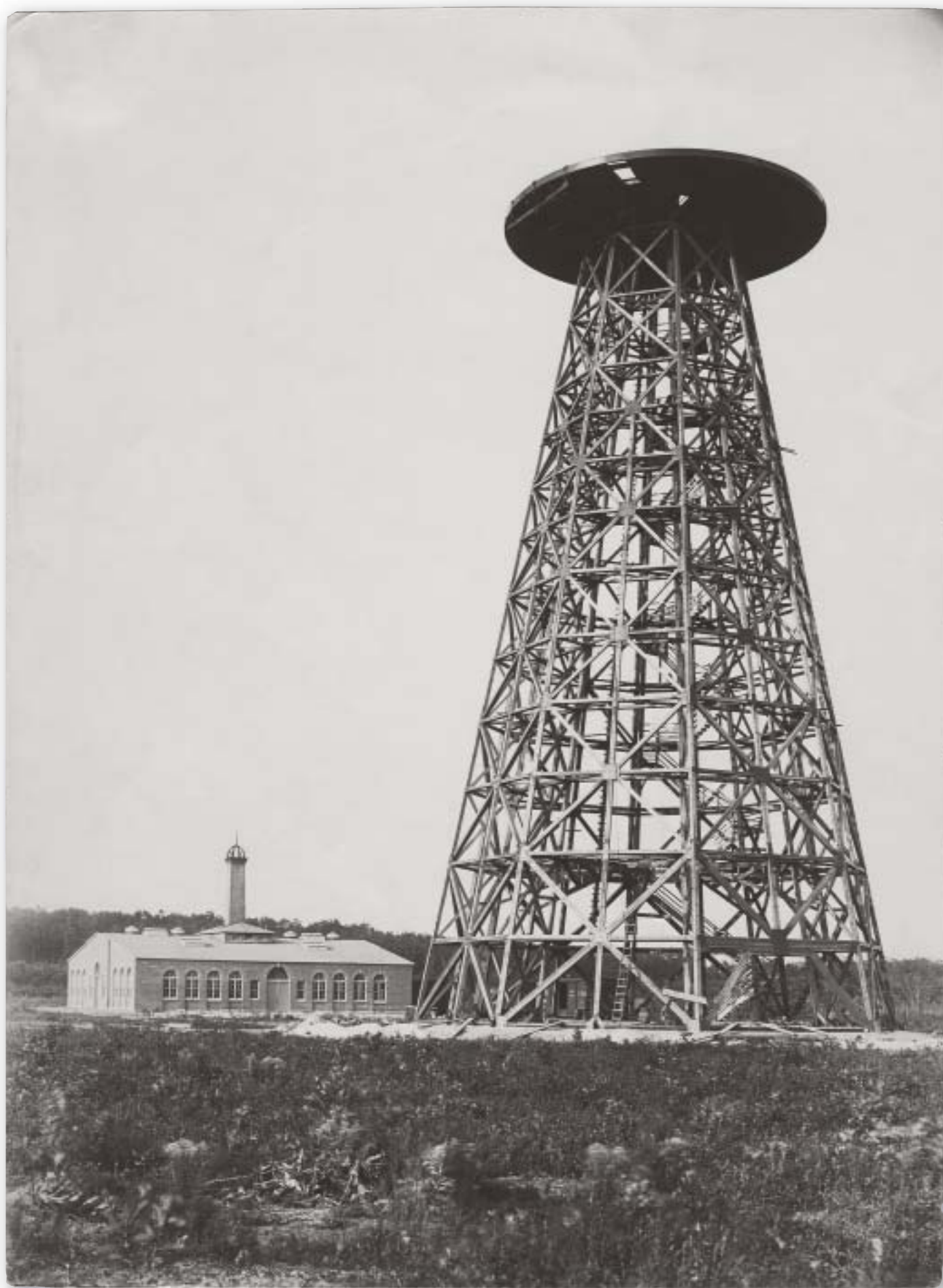
Odašiljač s centralom i laboratorijem za Svjetski sustav u fazi izgradnje (Wardenclyffe, Long Island u blizini New Yorka)
