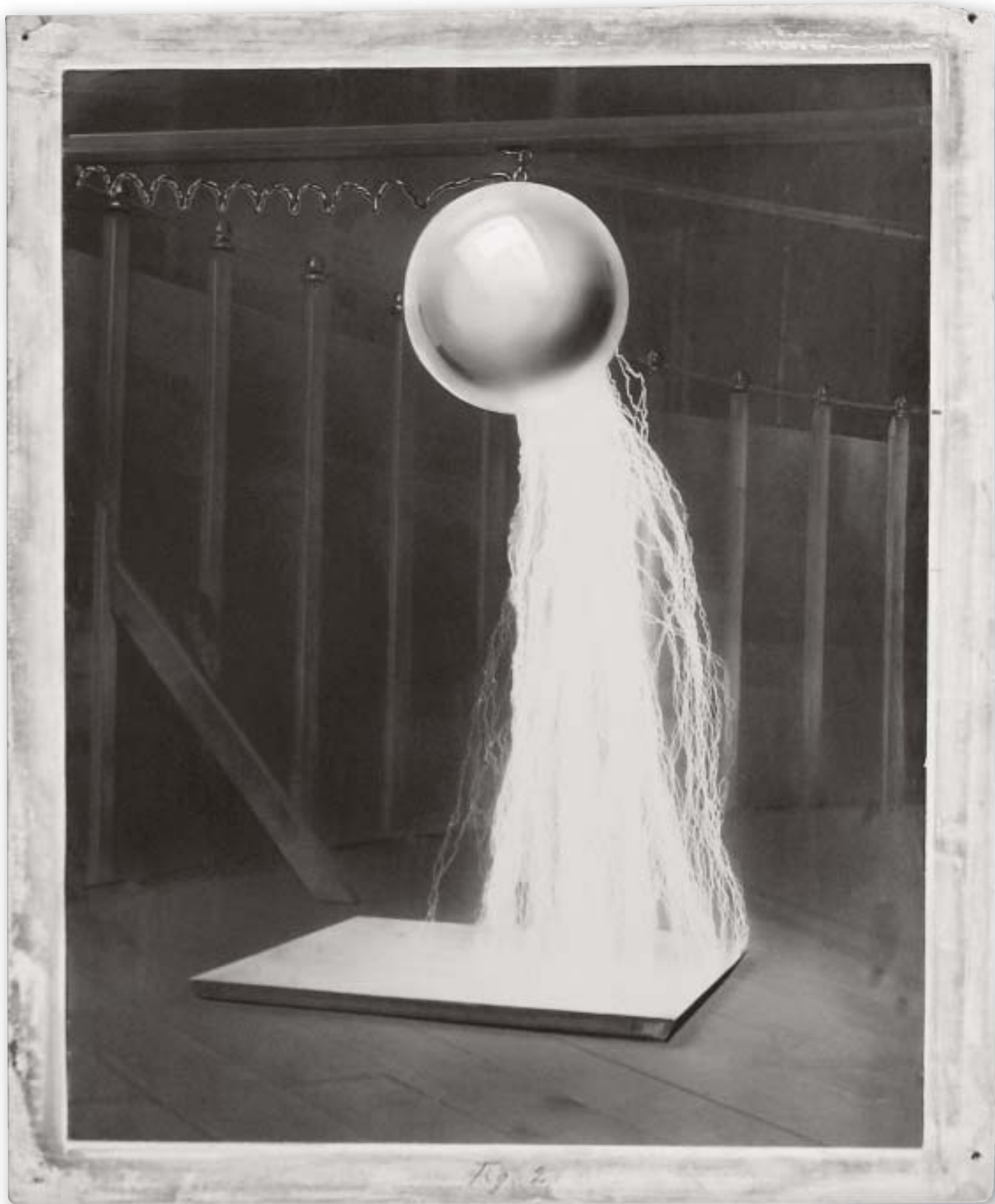
Ispitivanje pražnjenja između kugle promjera 40 cm i zemlje (Colorado Springs, 1899)
