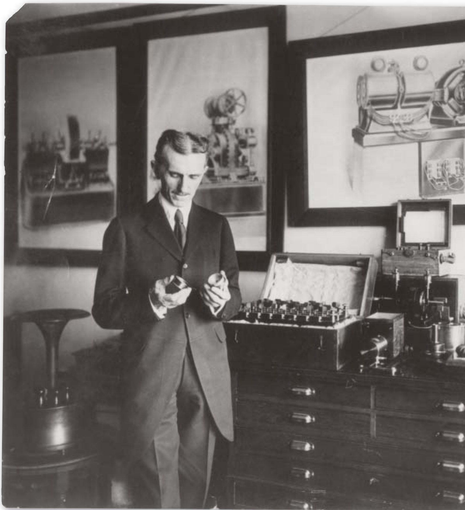
Tesla (u šezdesetim godinama života) pokazuje dio kabela s hidrocentrale na Niagari. Na fotografiji na zidu vidi se jedan od njegovih elektromehaničkih oscilatora napravljen oko 1890.
