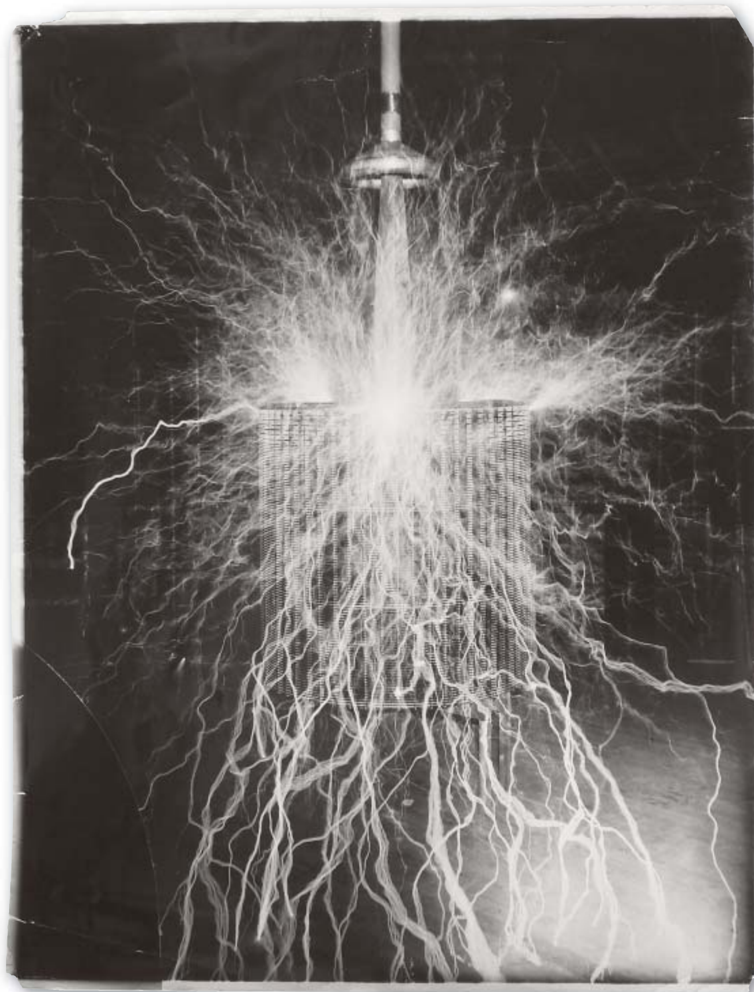
Eksperiment koji ilustrira rad oscilatora koji oslobađa impulsnu snagu od 75.000 kW. Napon iznosi preko dvanaest milijuna volti, a struja titra sto trideset tisuća puta u sekundi (Colorado Springs, 1899)
