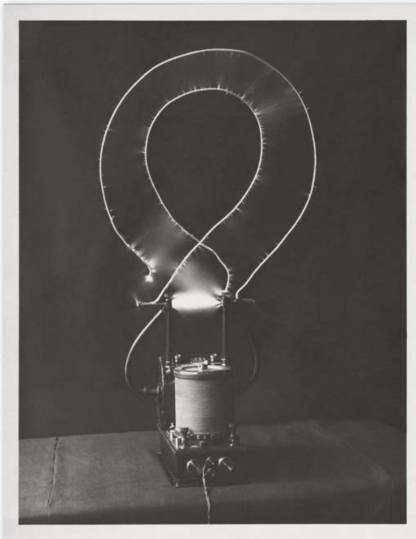
Sustav prvotnog Teslinog transformatora. Blještave iskre prekrivaju površinu od oko 0,2 m 2 . Instrument generira neprigušene oscilacije iz izvora od 110 V. Ovaj je Teslin transformator lord Kevin predstavio Britanskom udruženju u kolovozu 1897.
