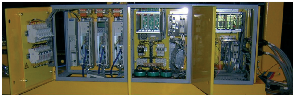
Sl. 15.: Razdjelnik s tri servofrekvencijska pretvarača i CNC upravljačkom jedinicom
