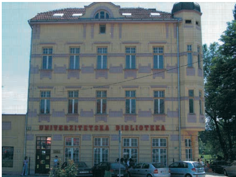
Slika 29.: Zgrada univerzitetske biblioteke
