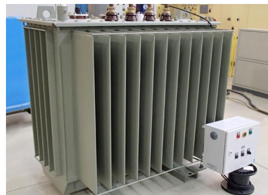
Trofazni uljem izolirani regulacioni transformator
