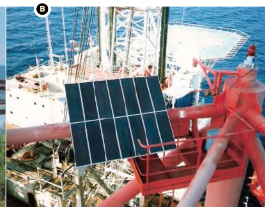
Solarno postrojenje za grijanje vode u kampu u Rovinju pušteno u rad 1984. (A) i fotonaponski sustav za napajanje signalizacije na bušećoj platformi nafte Labin u podmorju Jadrana izgrađen 1989. (B)
