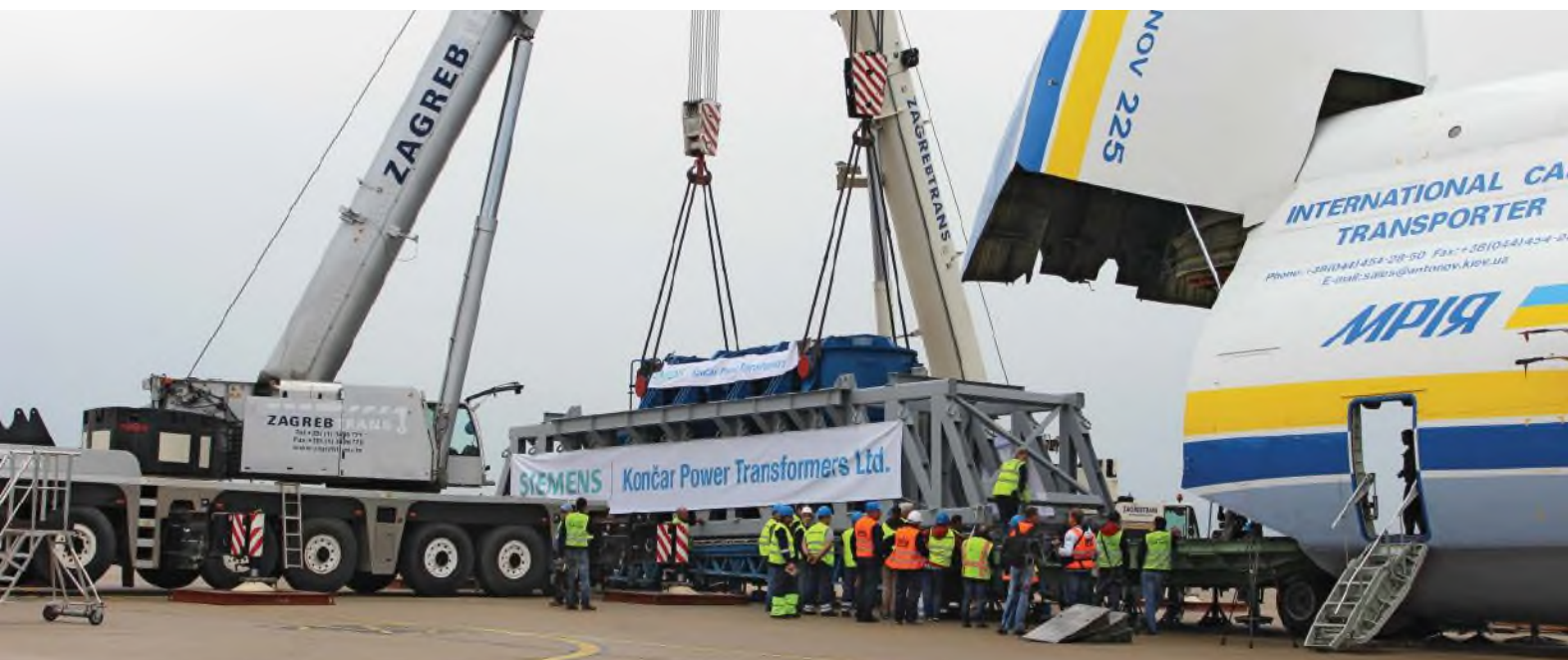
Utovar energetskog transformatora 318 MVA, 240 / 16,5 kV u najveći zrakoplov na svijetu An-225 ukrajinske tvrtke Antonov Airlines u Zagrebu za transport kupcu na Filipinima 2013.
