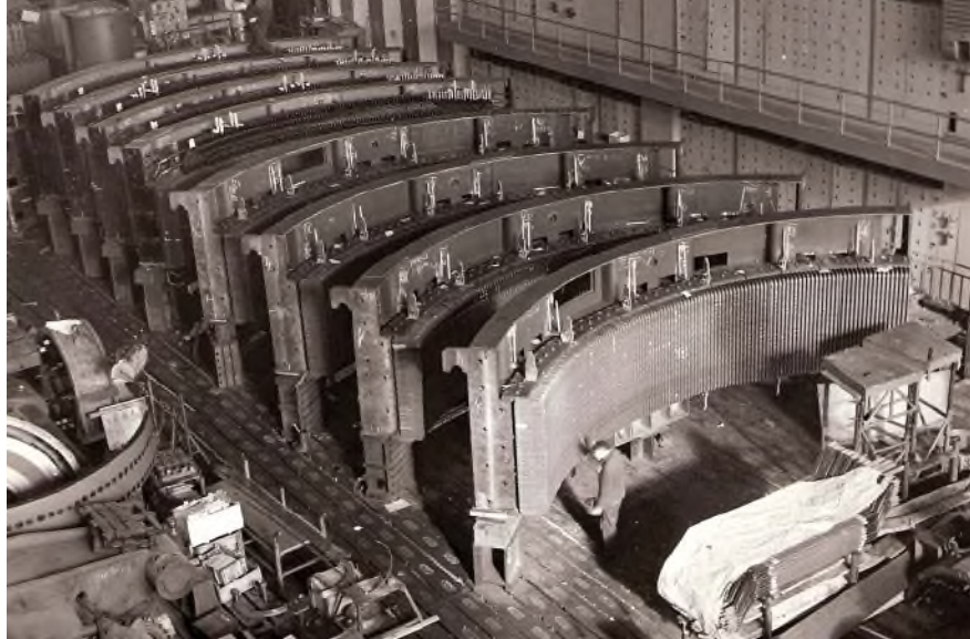
Segmenti dvaju statora generatora 100 MVA, 15,65 kV, 136,4 1/min za HE Bajina Bašta na Drini u Srbiji, puštena u rad 1966.
