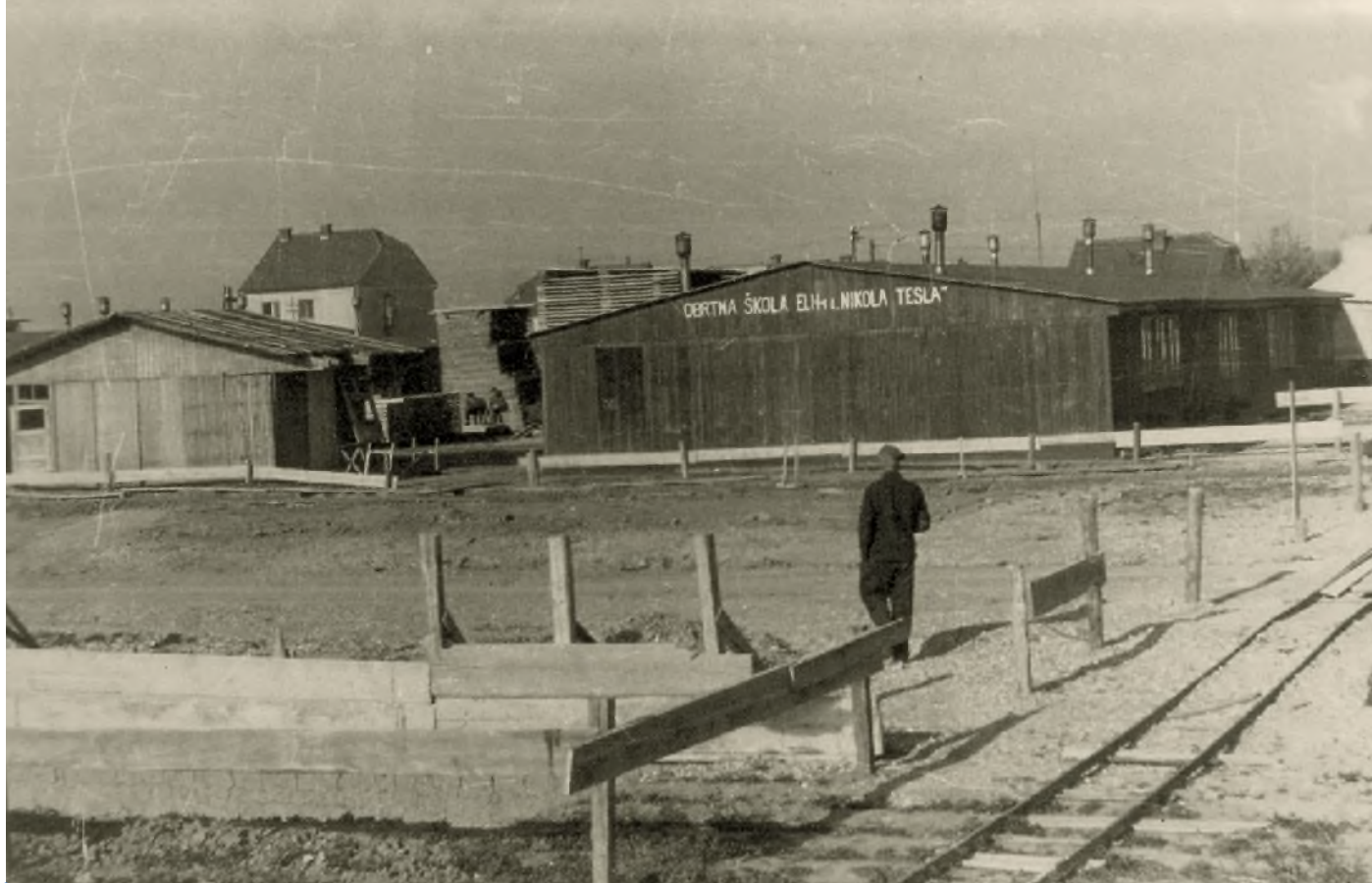
Baraka Obrtne škole Nikola Tesla na lokaciji Trešnjevka iz 1945.
