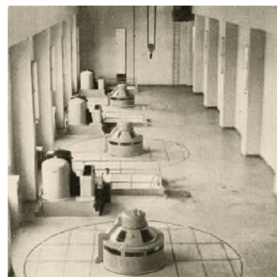
Strojarnica HE Chichoki Mallian u Pakistanu snage 3x5,5 MVA iz 1959.
