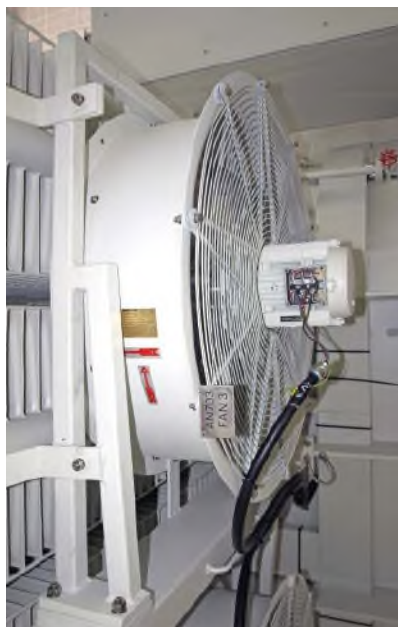
Ventilator s ugrađenim motorom za hlađenje energetskog transformatora za izvoz u Katar, 2010.
