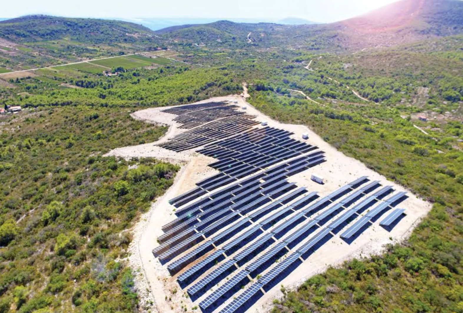
Sunčana elektrana na otoku Visu snage 3,5 MW, puštena u rad u rujnu 2020.
