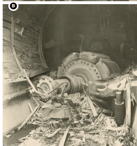
Vertikalna vitlaona u hali E i horizontalna vitlaona s havarijom rotora uz halu E
