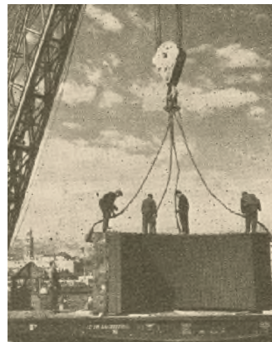
Utovar segmenata statora generatora 120 MVA, 16 kV, 300 1/min za HE Split (danas HE Zakučac) na ploveću dizalicu, 1961.
