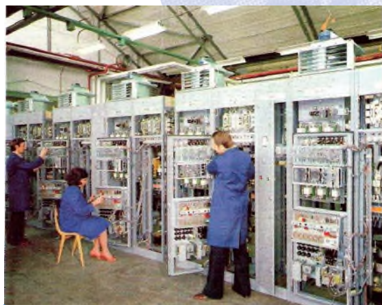
Tiristorski ispravljači za Čeličanu u Tripoliju u Libiji, 1979.
