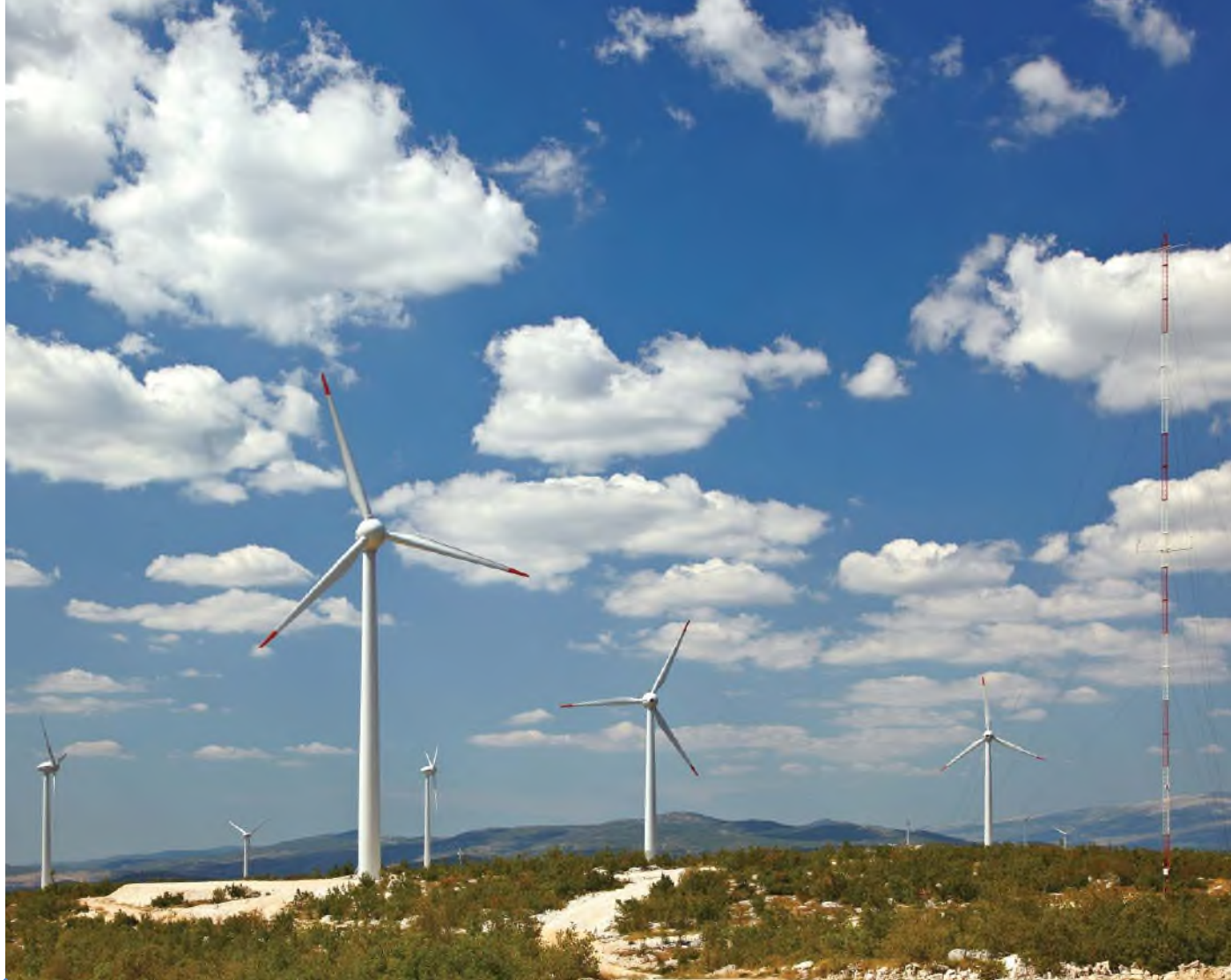
Vjetroelektrana snage 20 MW s vjetroagregatima 1 i 2,5 MW na lokaciji Pometeno Brdo u općini Klis, 2012.
