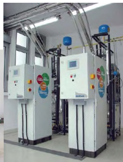
Kogeneracijsko postrojenje na prirodni plin s gorivnim člancima kao dio Laboratorija za obnovljive izvore, 2008.
