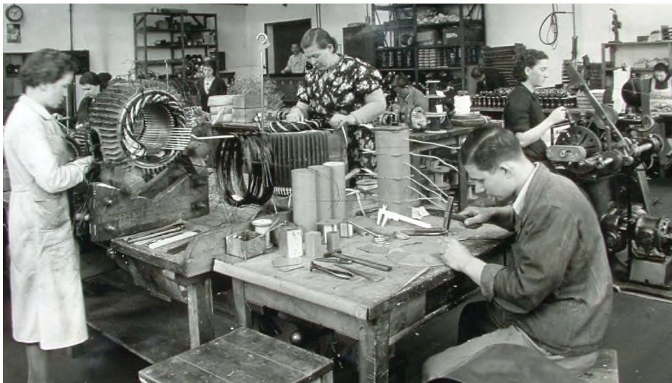
Ručno namatanje asinkronih motora u Jugoslavensko Siemens d.d. , 1936.
