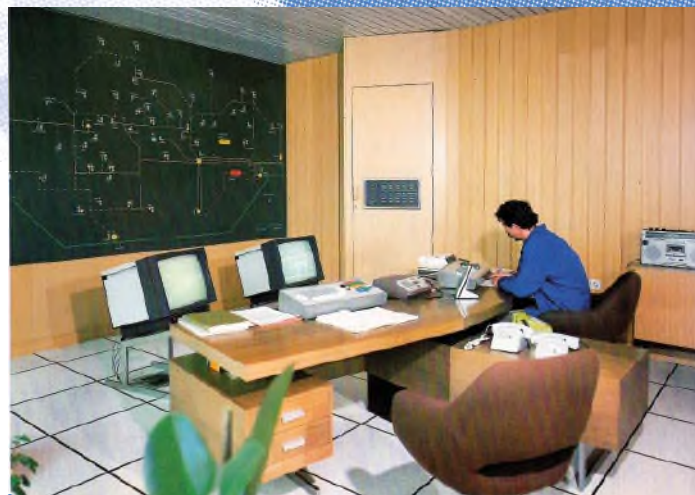
Informacijski sustav za mjerenje, upravljanje i vođenje transporta plina u INA - Naftaplenu, 1985.
