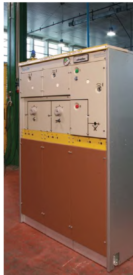
Distribucijska sklopna aparatura Šigma 24, 2007.
