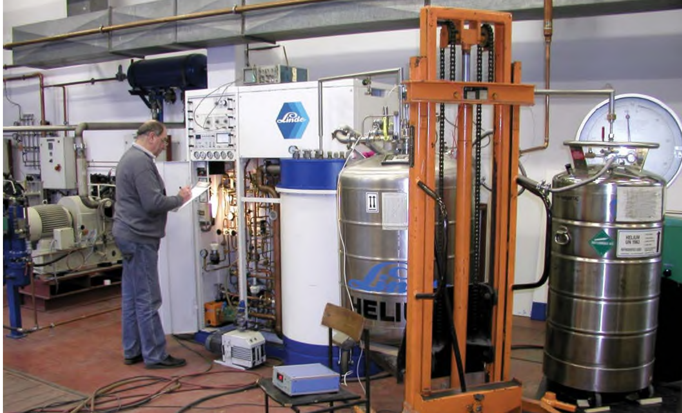
Ukapljivanje plinovitog helija i pretakanje tekućeg helija u transportne spremnike u KONČAR - Institutu za elektrotehniku d.d., 2004.
