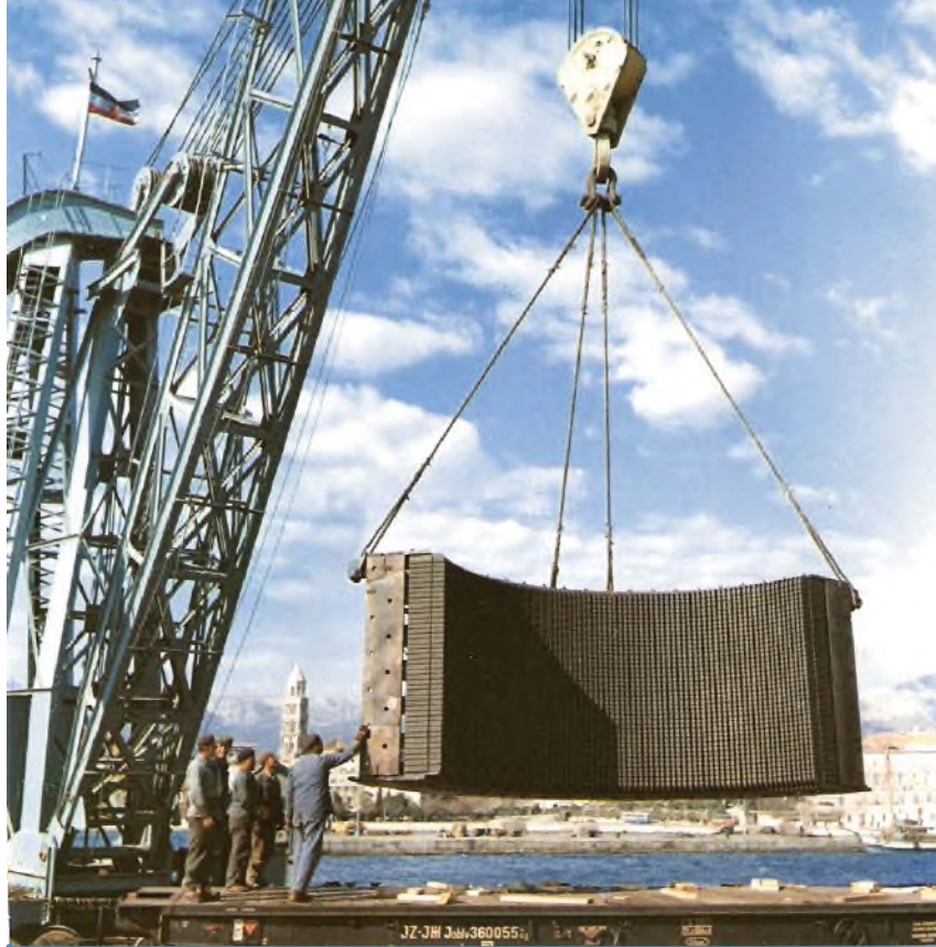
Prijevoz dijela statorskog paketa generatora 120 MW, 16 kV, 300 1/min za HE Split (danas HE Zakučac), 1962.
