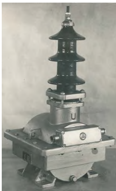
Maloulni naponski mjerni transformator za 30 kV iz 1950-ih
