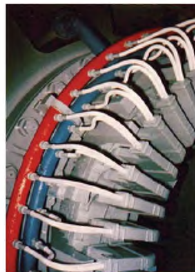
Detalj glave namota i kolektori rashladne vode direktnog hlađenja namota turbogenerators TE Gacko 353 MVA, 20 kV, 3000 1/min
