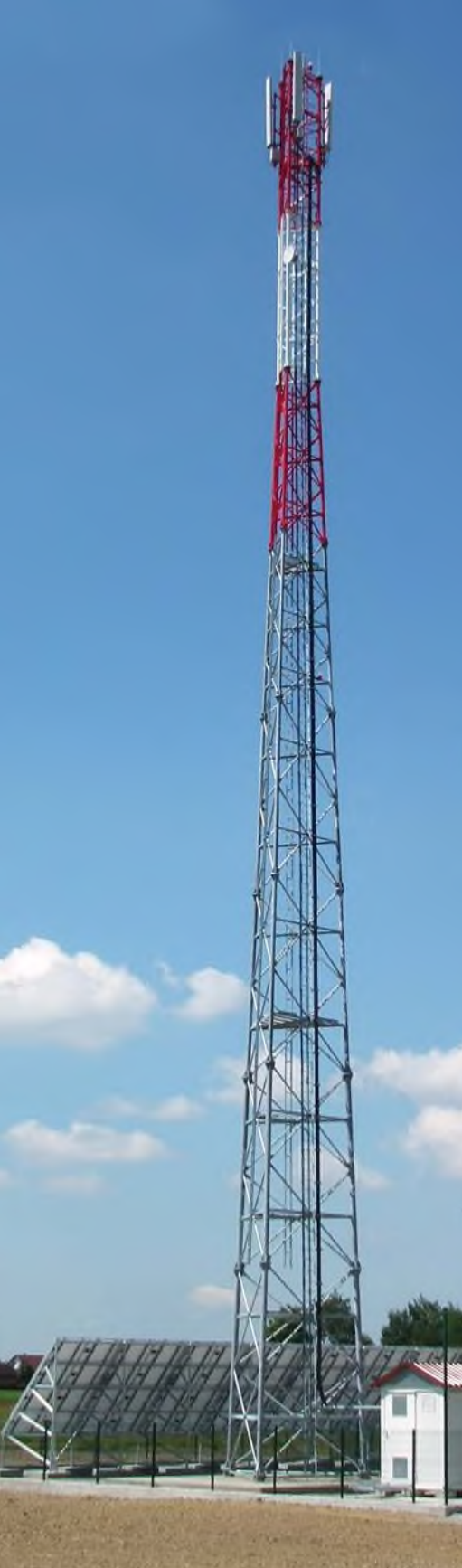
Bazna stanica u Ladimircima u Slavoniji napajana iz autonomnog izvora energije Hybrid Box®, koji se sastoji od male fotonaponske elektrane, dvaju vjetroagregata, baterija i gorivnih članaka sa spremištem vodika, puštena u rad 2011.
