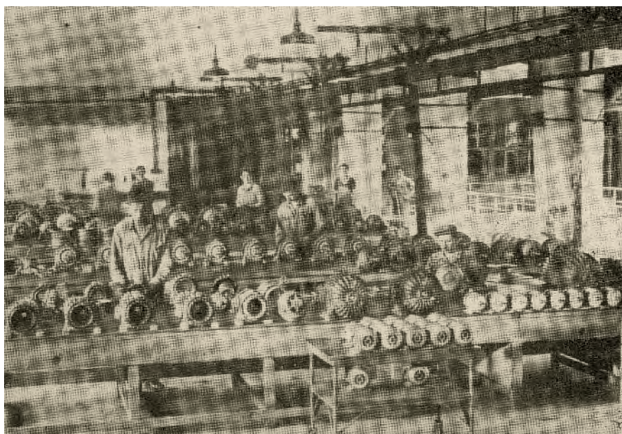
Montaža malih asinkronnih motora iz 1957.
