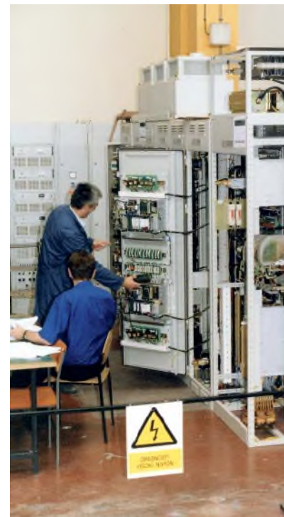
Dvokanalni digitalni sustav uzbude za HE Senj, 2000.
