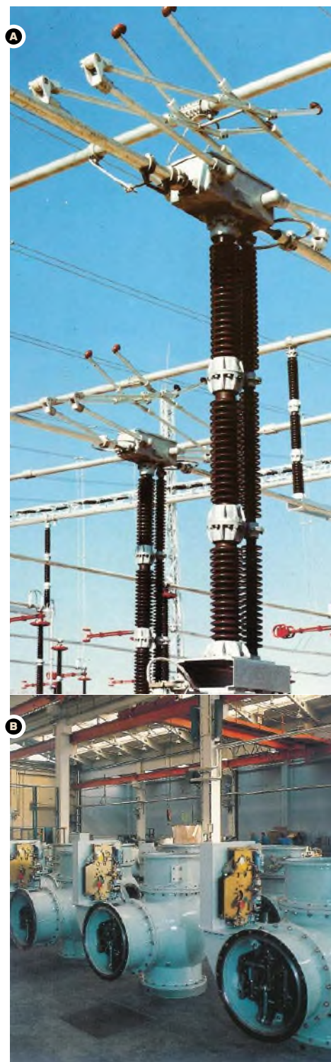
Vlastitim snagama razvijen je 1979. pantografski rastavljač (A) i prvo metalom oklopljeno SF 6 postrojenje 123 kV za TS 110 / 20 kV Zagreb sjever, proizvedeno 1982. (B)
