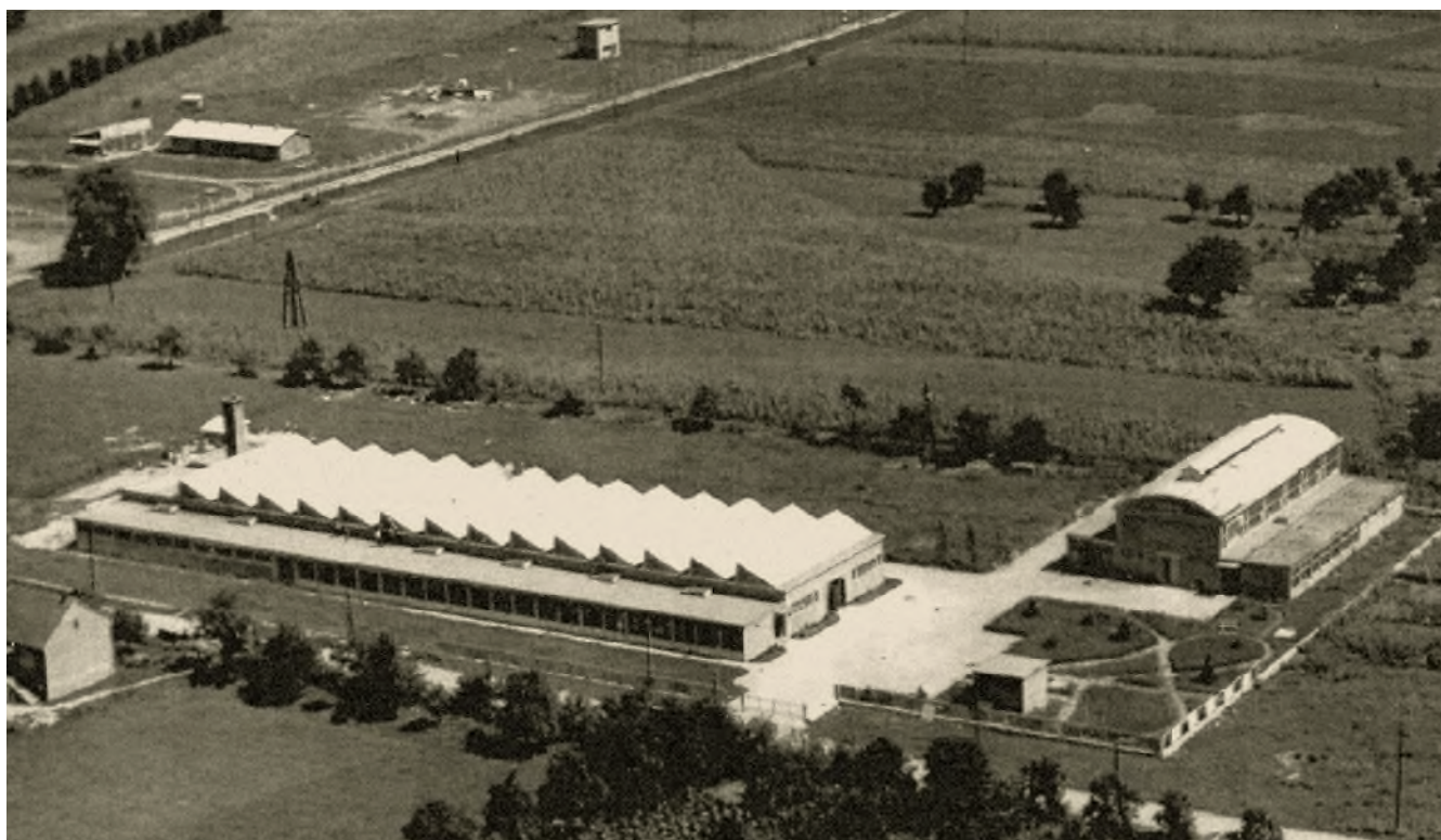
RADE KONČAR - Tvornica grijačnih elemenata za kućanske aparate u Slavonskoj Požegi, puštena u rad 1962.
