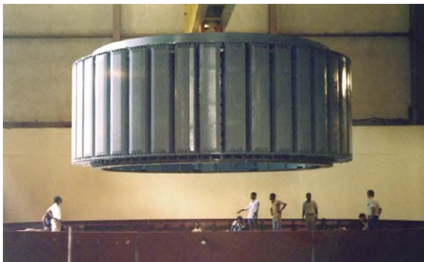
Spuštanje rotora u stator generatora 176,6 MVA u HE Shiroro u Nigeriji godine 1983.
