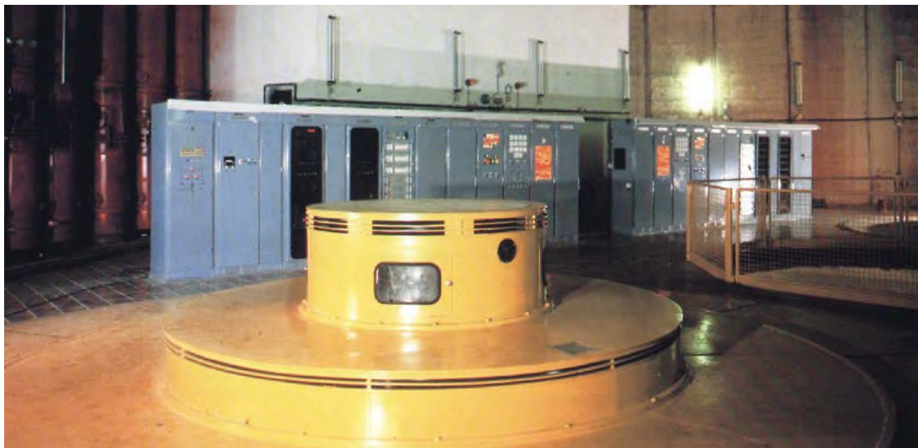
Reverzibilna HE Obrovac , danas Velebit , s generatorima 2 x 155 MVA, 15,75 kV, 600 1/min, puštena u rad 1984.
