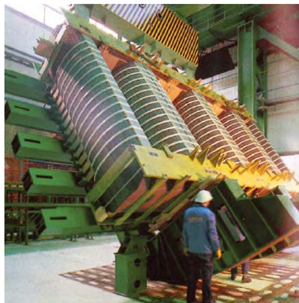
Uspravljanje peterostupne jezgre transformatora 725 MVA za TE Obrenovac, 1983.
