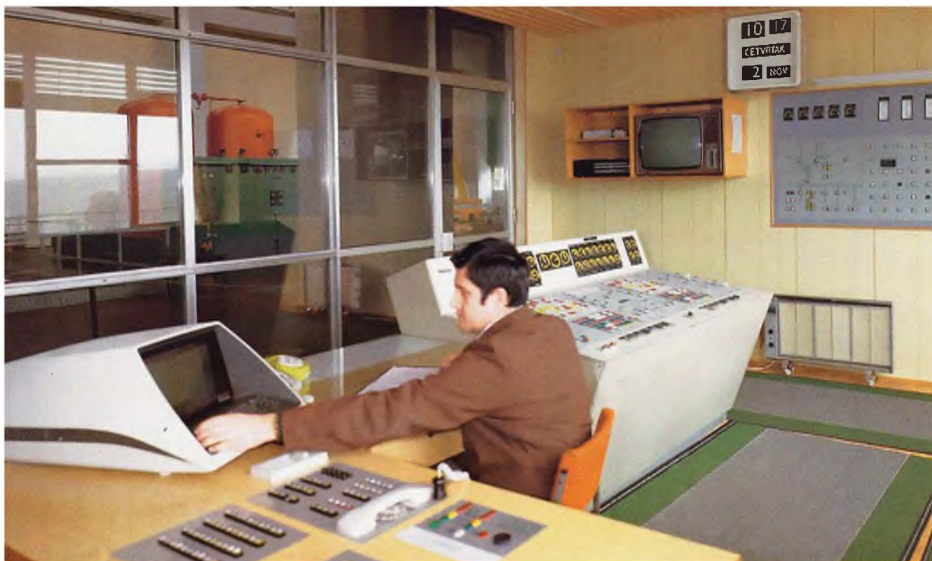
Sustav automatizacije u realnom vremenu s pomoću računala u HE Varaždin, 1974.
