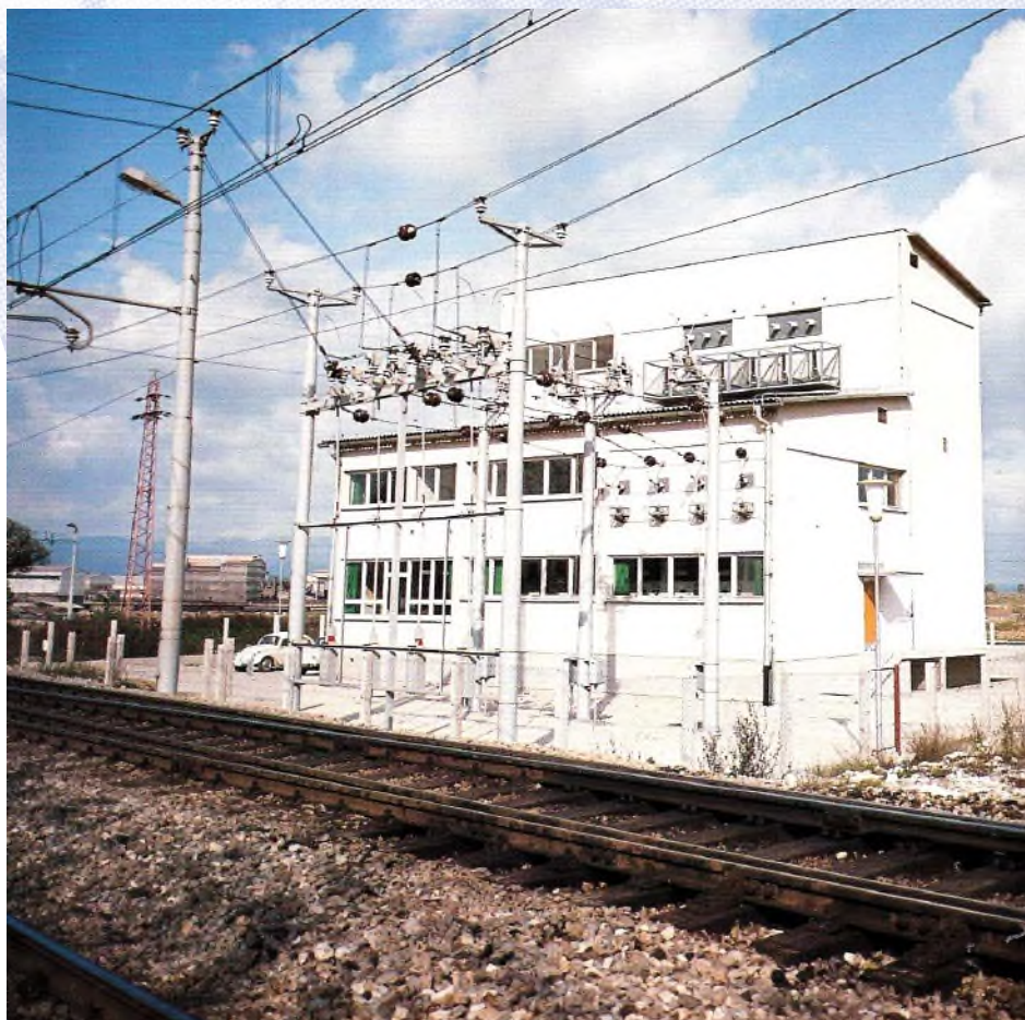
Električna vučna podstanica 3400 V Čret u Sloveniji
