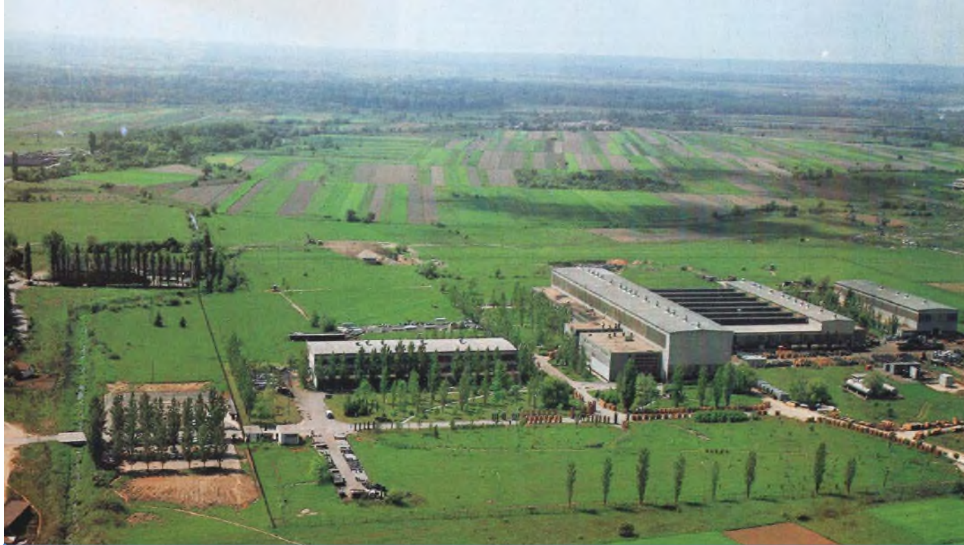
Tvornica transformatora u Jankomiru, Zagreb, izgrađena 1965. s natkrivenom površinom od 23.300 m 2
