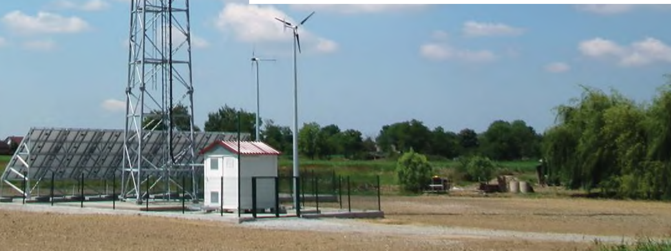
Bazna stanica u Ladimircima u Slavoniji napajana iz autonomnog izvora energije Hybrid Box®, koji se sastoji od male fotonaponske elektrane, dvaju vjetroagregata, baterija i gorivnih članaka sa spremištem vodika, puštena u rad 2011.
