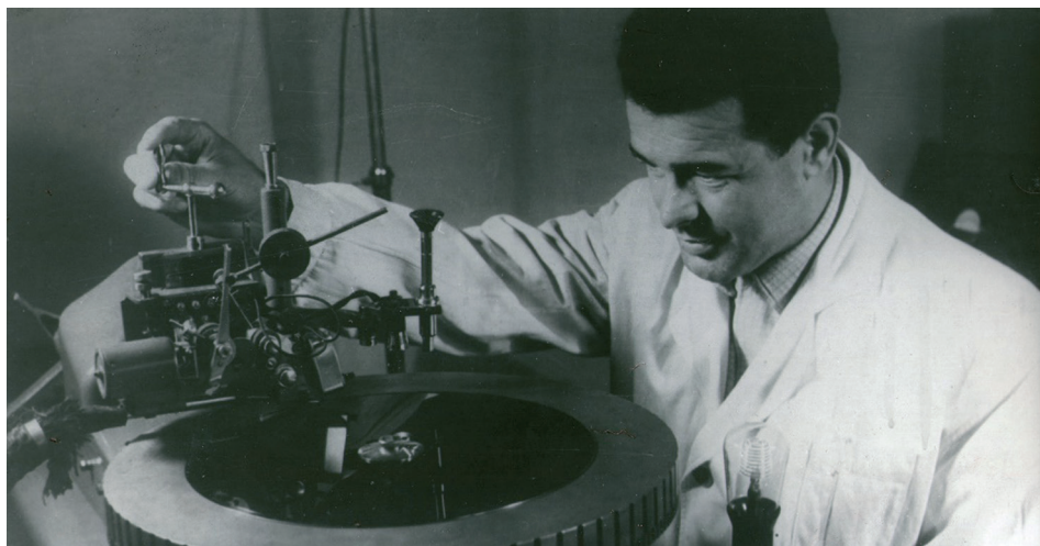
Sl. 13.: Urezivanje u lak-ploču (mađarski uređaj Gamma , 1952.)
