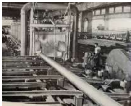
Sl.5. Kalibrir peč valjaonice bešavnih cijevi u Željezari Sisak
