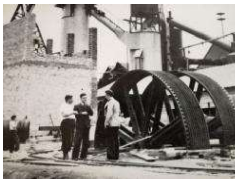
Sl. 1. Izgradnja Talionice Caprag tijekom 1938. godine (ing. M. Tomac u sredini fotografije)
