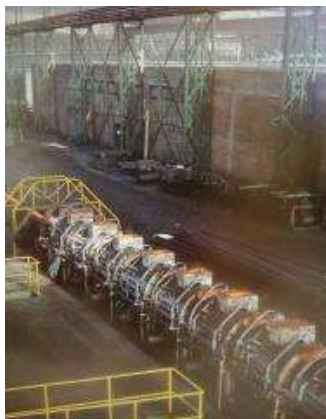
Sl. 8. Selas peći u valjaonici traka i gredica u Željezari Sisak
