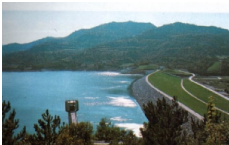
Akumulacija vodovoda Butanega
