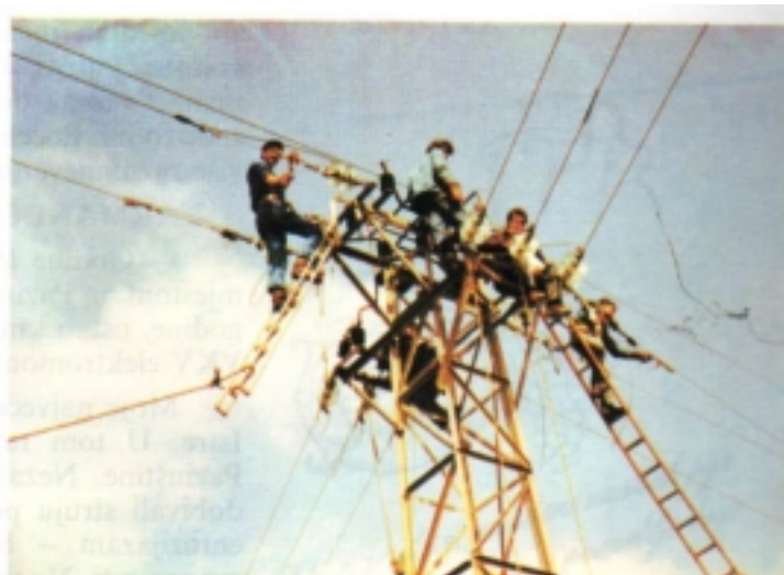
Radovi na otcjepnom slupu
