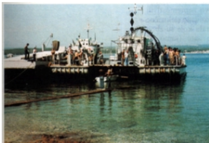
Polaganje 20kV kabela za otočje Brijuni
