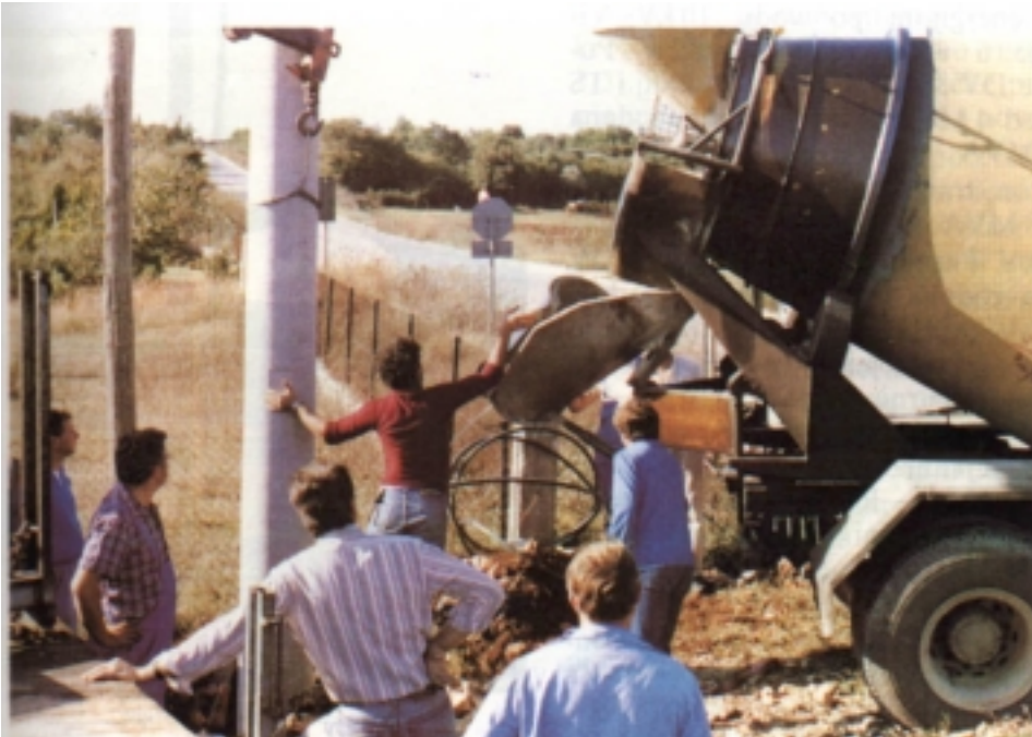
Betoniranje 20 kV betonskog stupa
