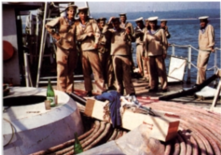
JRM - suradnik u polaganju podmorskih kabela
