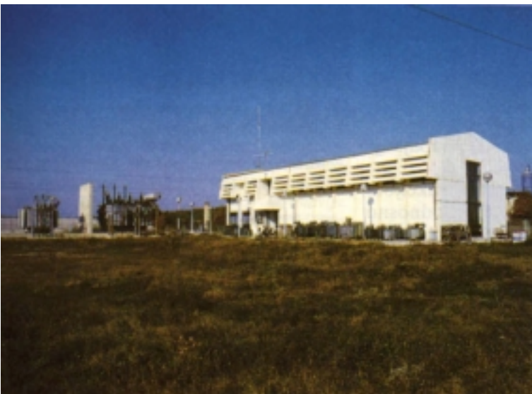
TS 35 kV Dubrova - zgrada
