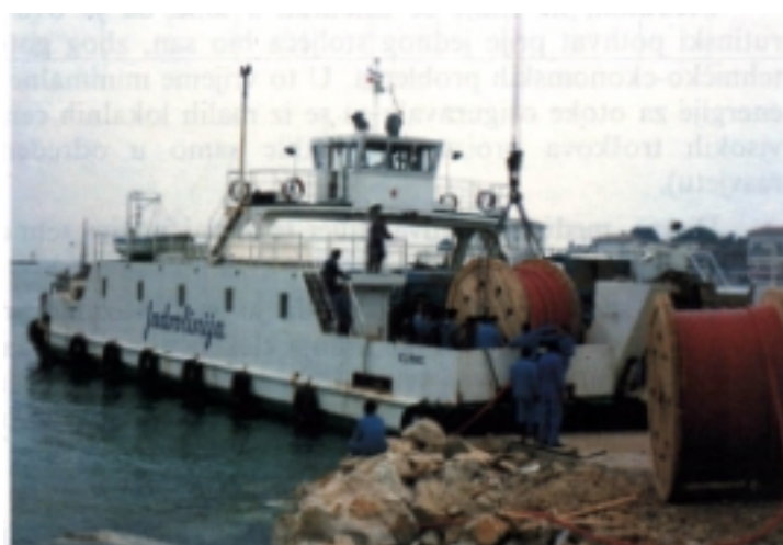
Tehnička priprema za polaganje podmorskog kabela za otok Sv. Nilola kod Poreča
