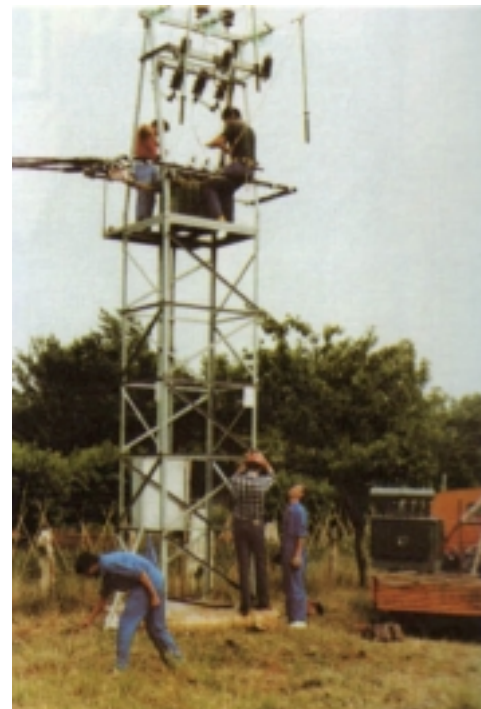
Zamjena transformatora
