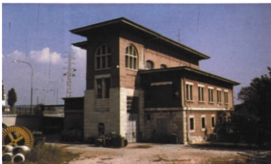
Slika 21b. Trafostanica Gregorica - Pula. danas.
