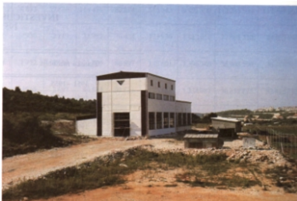
Nova zgrada trafostanice -Pula
