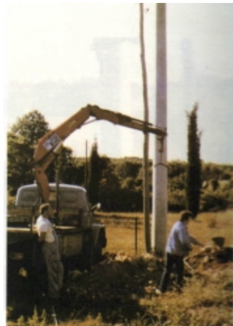
Ugradnja 20 k V betonskog stupa
