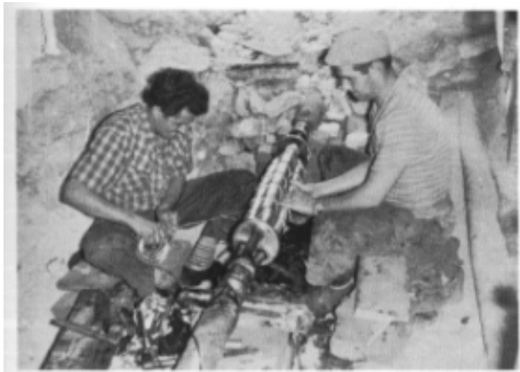
Izrada 35kV kableske spojnice Pula 1-Centar 1961. godine
