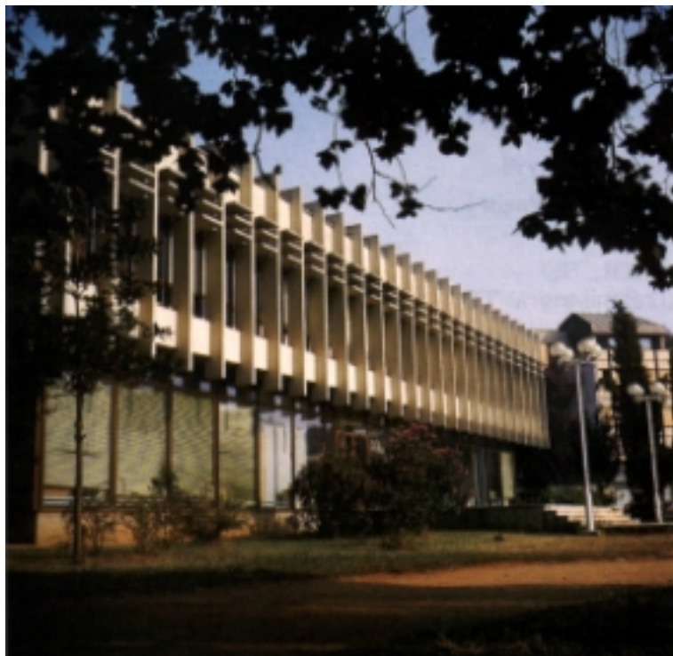
Zgrada službe potrošača - izvođač "Istragradnja" Pula
