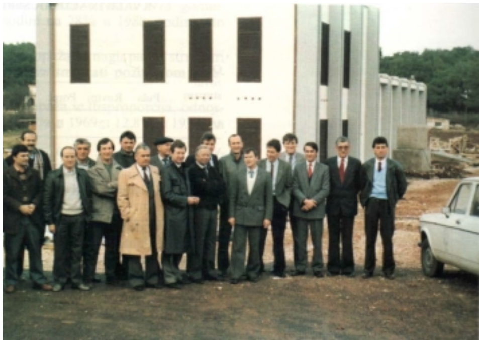
Posjeta TS 110/35 kV Dolinko u izgradnji
