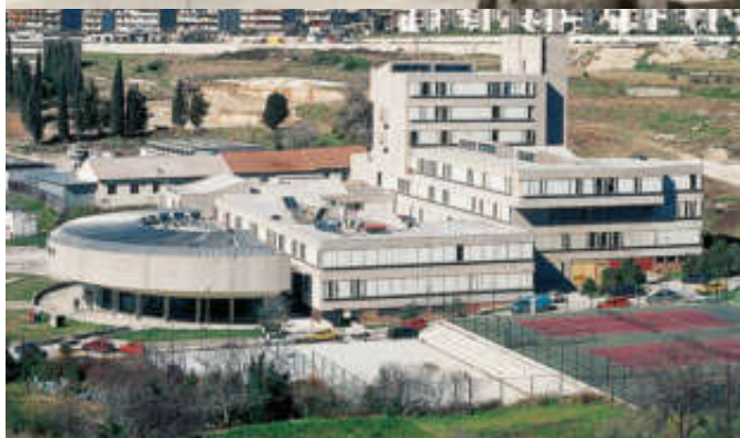
Nova zgrada FESBa na lokaciji Visoka
