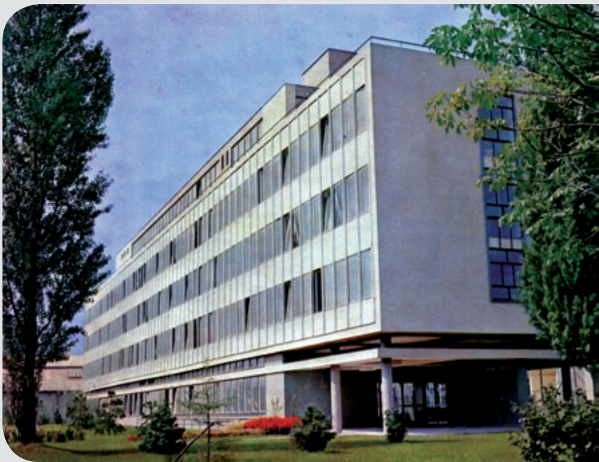
S.4.13. Zgrada Zavoda za aparate i postrojenja i Zavoda za tehnologiju proizvoda te Uprave i zajedničkih službi Elektrotehničkog instituta izgrađena 1966.
