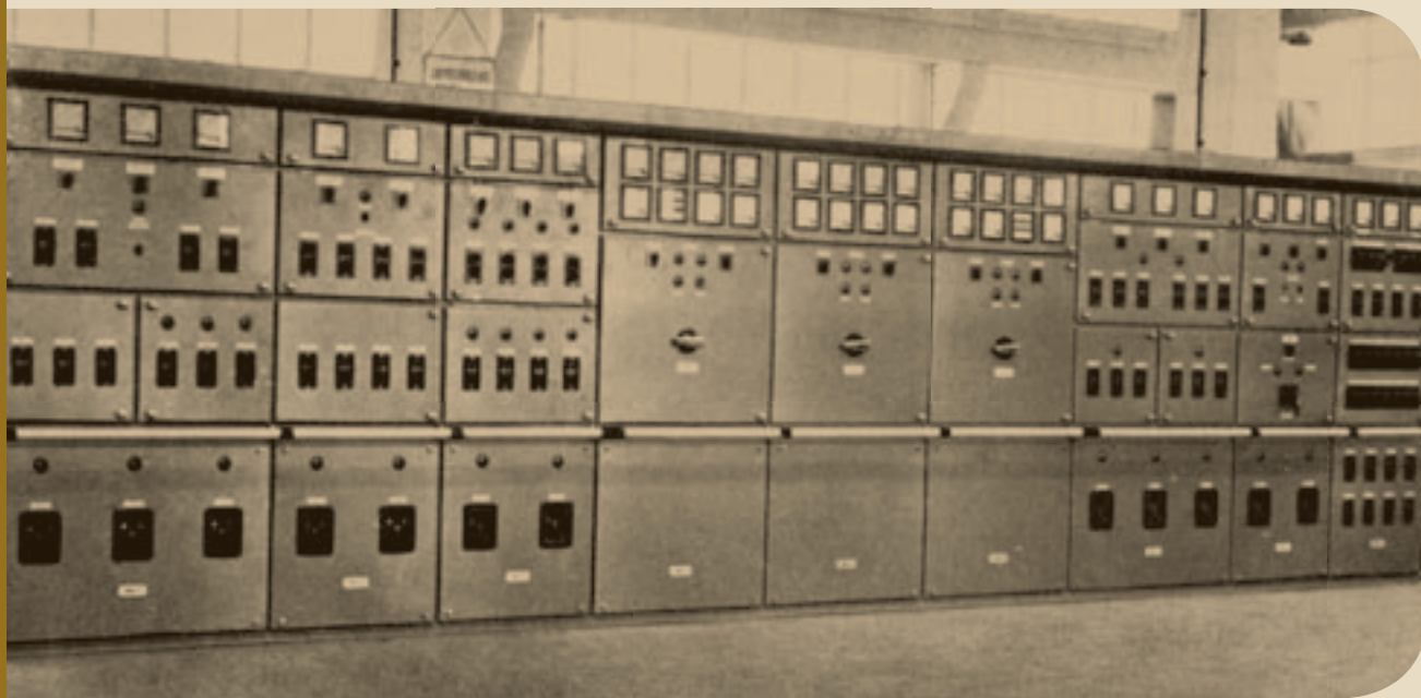
S.3.23. Glavna razvodna ploča od 7 polja broda "Chopin"
