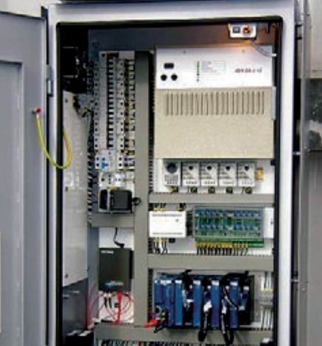
S.5.69. Ormar monitoring sustava za trajno nadziranje rada transformatora
