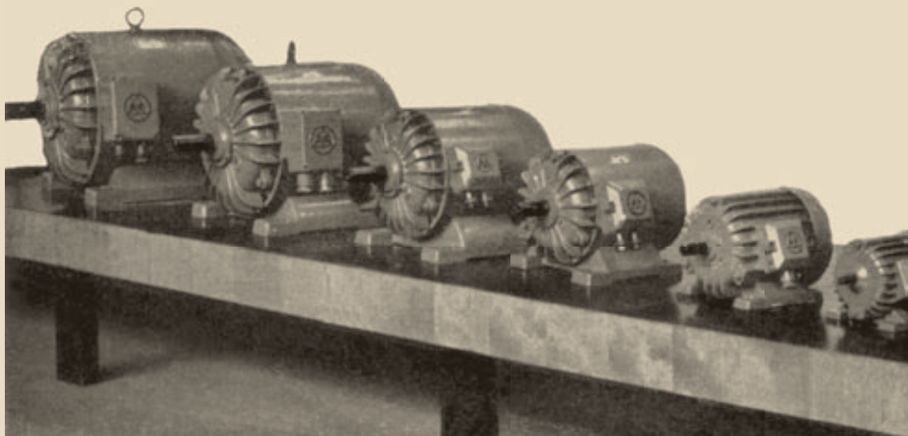
S.3.7. Stara serija elektromotora iz proizvodnje 1945. i nova serija s lijevanim aluminijским kućištem i kanalima za hlađenje prema patentu prof. Dolenca iz proizvodnje 1960.
