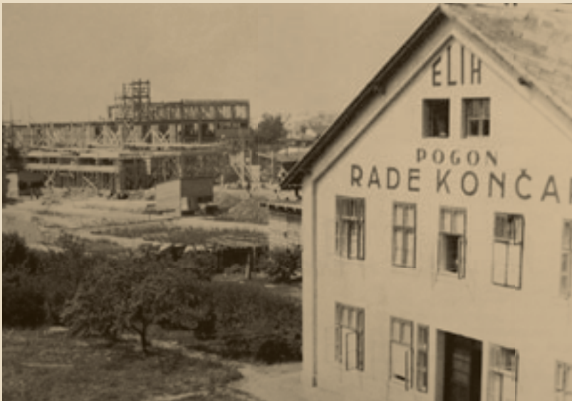
S:2.8. Izgled lokacije i početak gradnje tvorničkih hala na lokaciji Trešnjevka, Fallerovo šetalište
