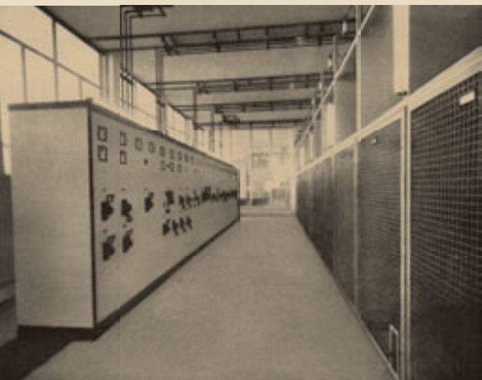
S.3.37. Visoko i niskonaponsko postrojenje u transformatorskoj stanici i asinkroni motori od 600 kW žične pruge u Željezari Zenica iz 1955.
