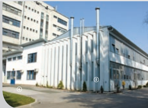
Zgrada Zavoda za materijale i tehnologije s Laboratorijem za fizikalno-kemijska ispitivanja i Laboratorijem za mehanička i tehnološka ispitivanja, izgrađena 1965., prenamijenjena i obnovljena 2008.
