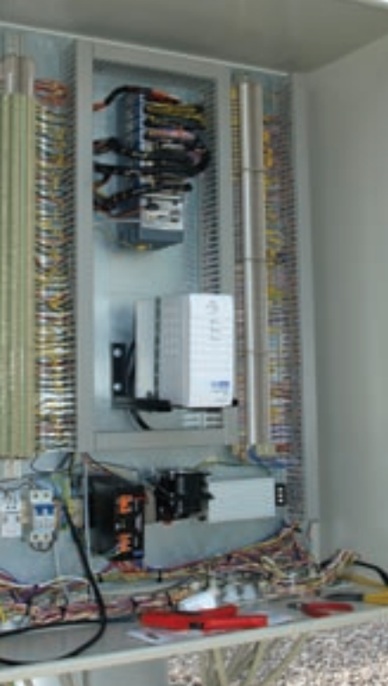
S:5.74. Prototip monitoringa VN postrojenja koji je ugrađen u TS Meline nedaleko od Rijeke i pušten u eksperimentalni rad 2010.
